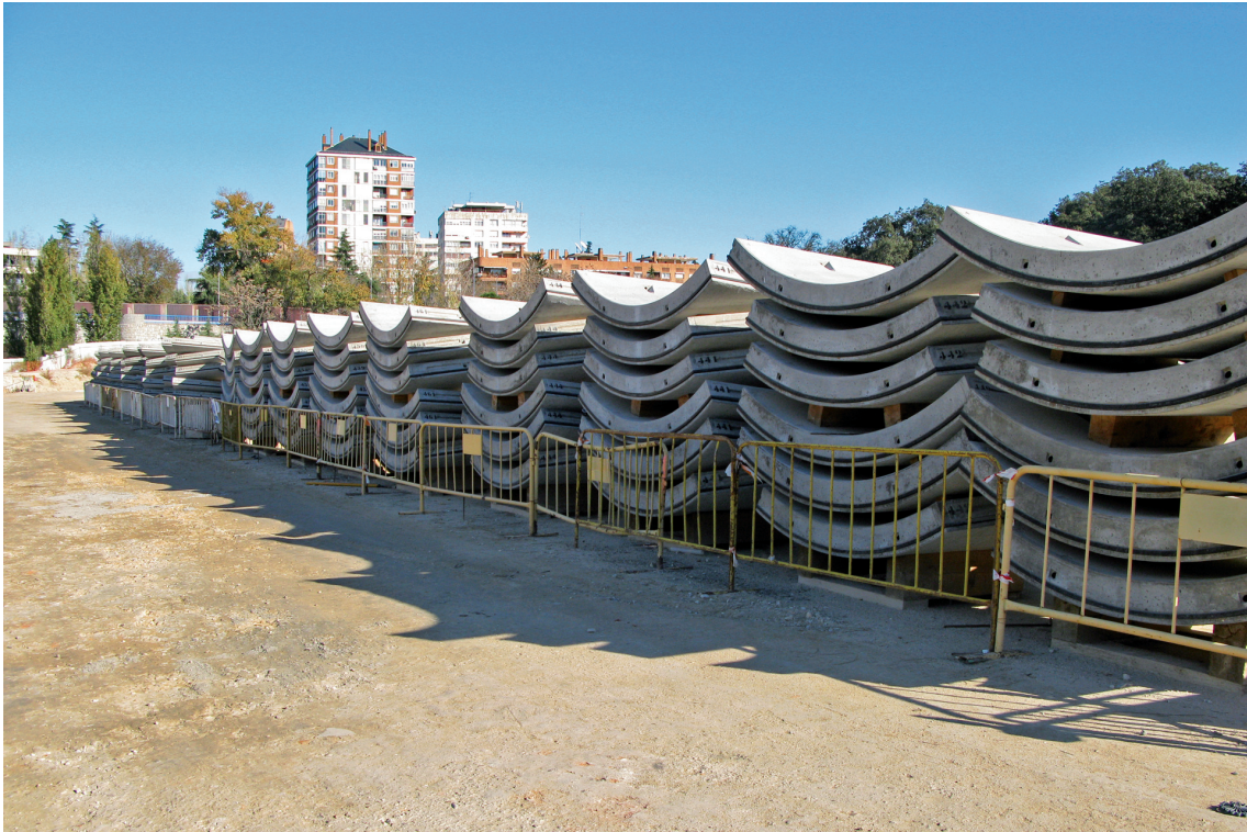
Parque de dovelas prefabricadas de hormigón armado para revestimiento del Colector de Pinos, en ejecución.
