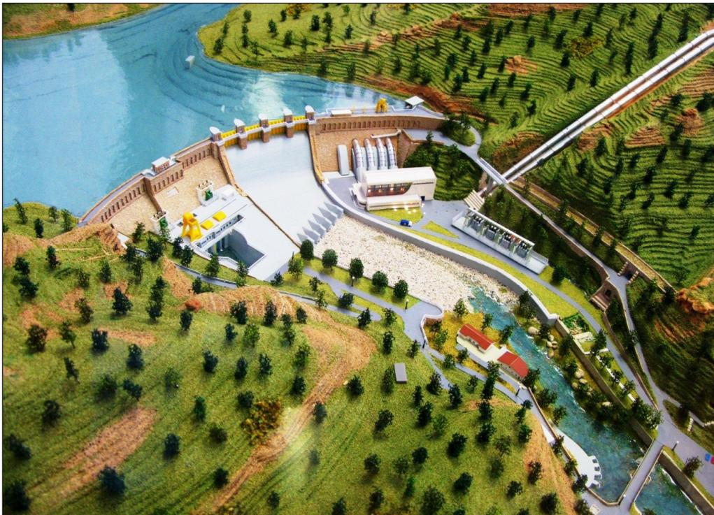
Maqueta de la presa y central reversible de Bolarque. Se aprecia el cuenco amortiguador, las tuberías de aspiración (a la derecha del cuerpo de presa), la impulsión de Bolarque II - La Bujeda y el centro de transformación. (Maqueta de Gas Natural Fenosa)
