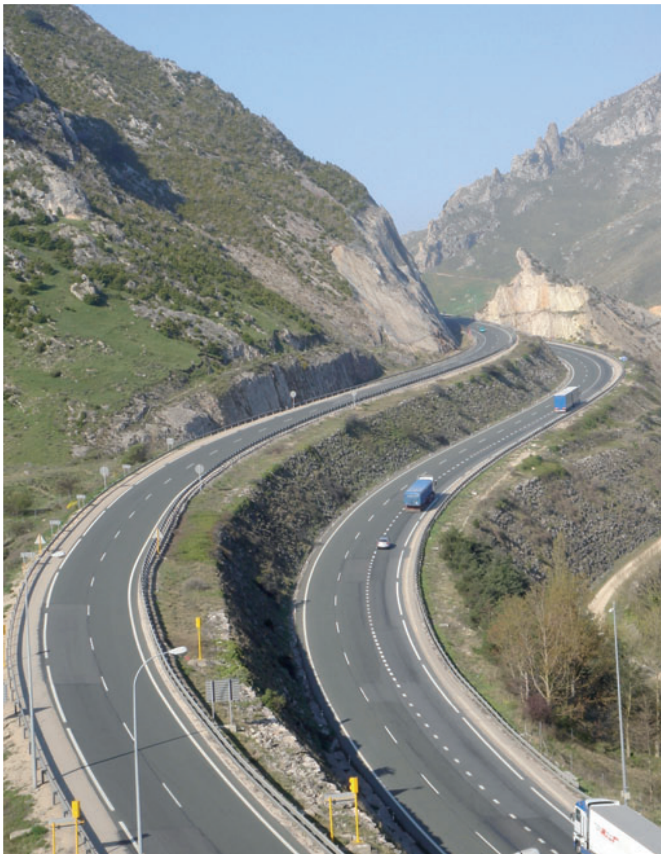
AP-1: Burgos – Armiñón. Km. 60+500. Desfiladero de Pancorbo (Burgos)
