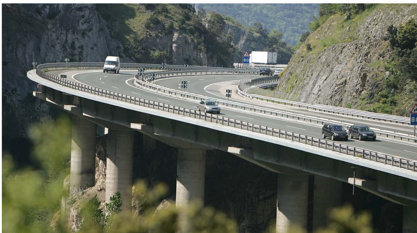
AP-68: Bilbao-Zaragoza. Pk 52 + 100, Viaducto de Subijana
