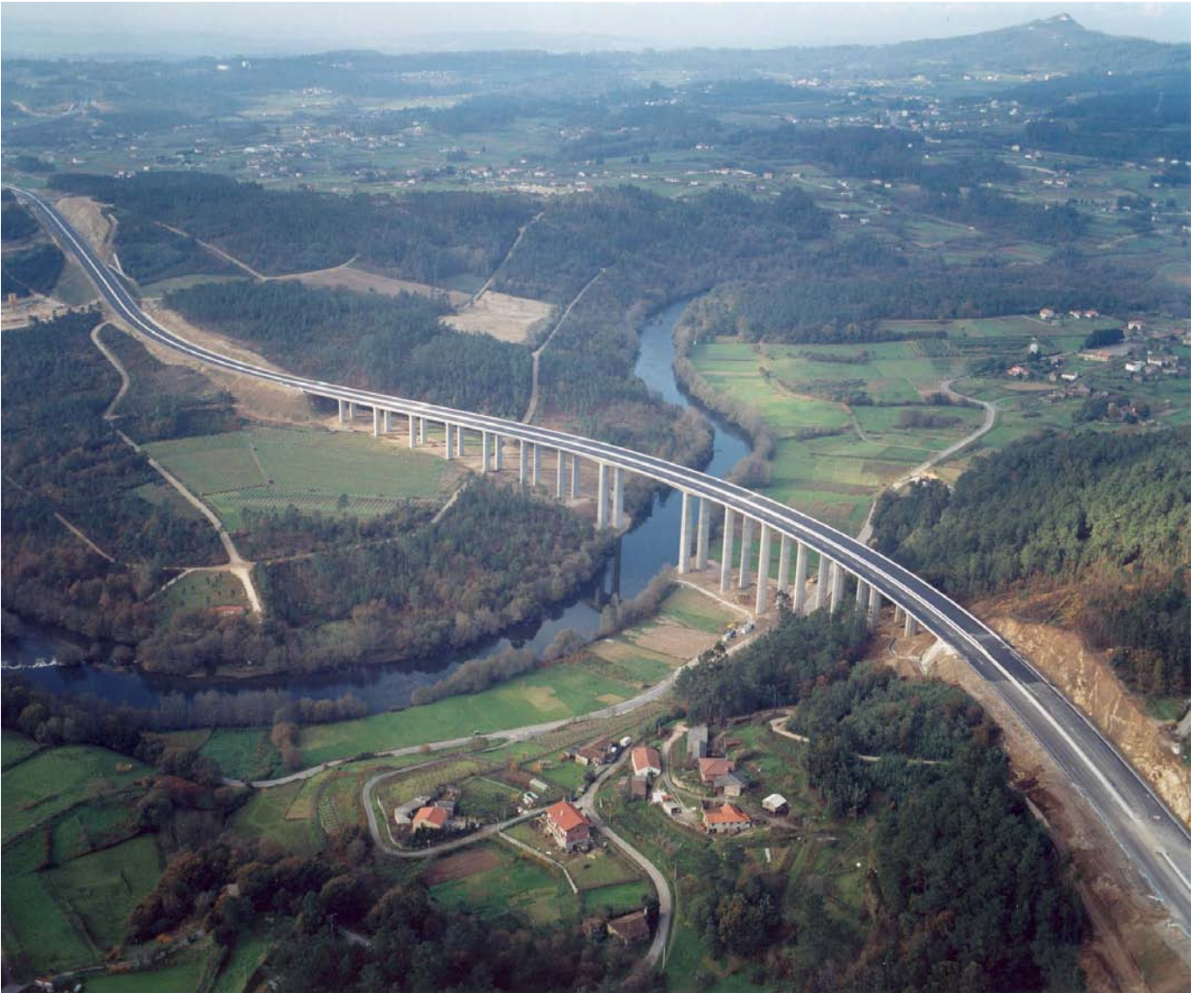
AP-53: Santiago-Alto de Sto. Domingo. Viaducto de Ulla
