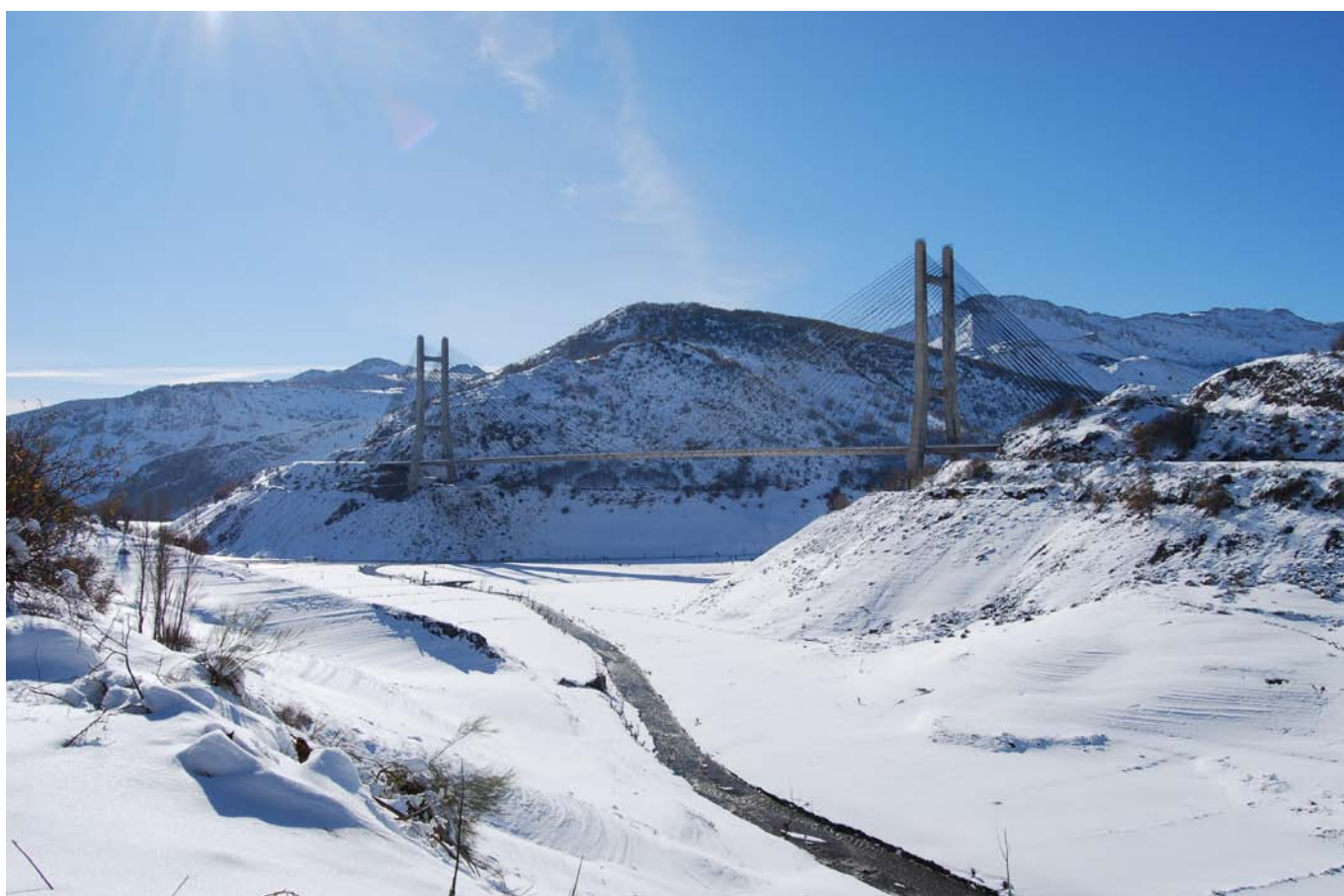
AP-66: León-Campomanes. Viaducto Carlos Fernández Casado.
