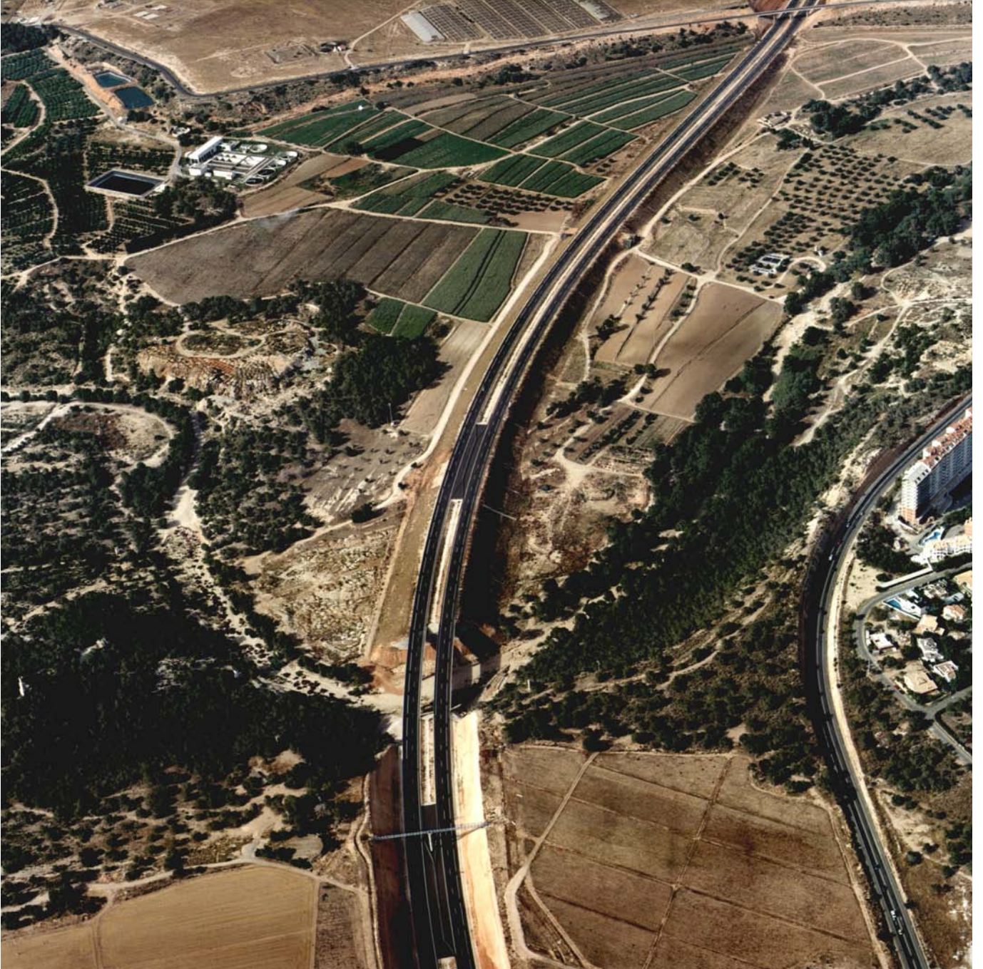
AP-7: Alicante-Cartagena. Pk 767. Viaducto del río Nacimiento.
