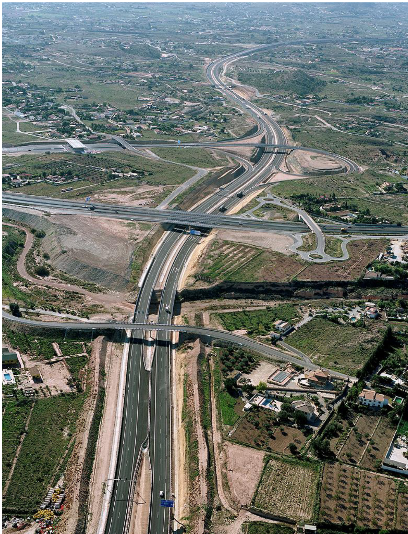
AP-7: Circunvalación de Alicante. Troncal de Monforte
