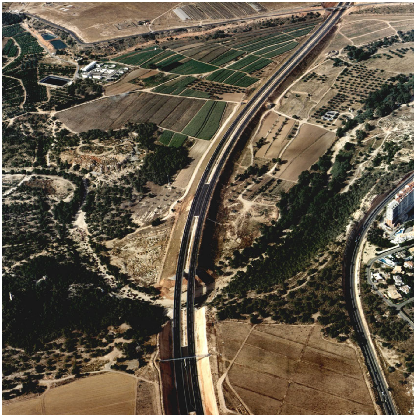
AP-7: Alicante-Cartagena. Pk 767. Viaducto del río Nacimiento.
