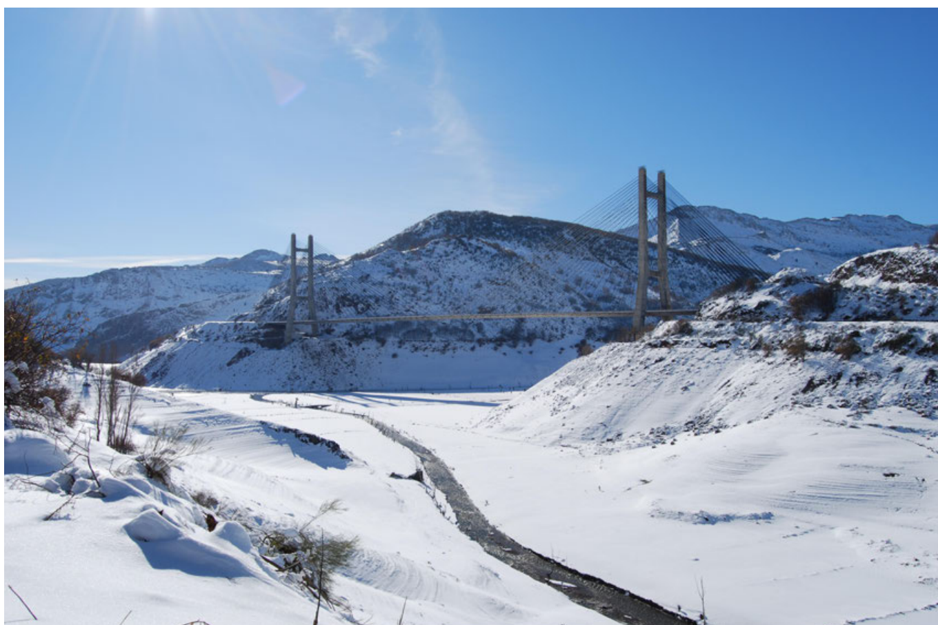
AP-66: León-Campomanes. Viaducto Carlos Fernández Casado.
