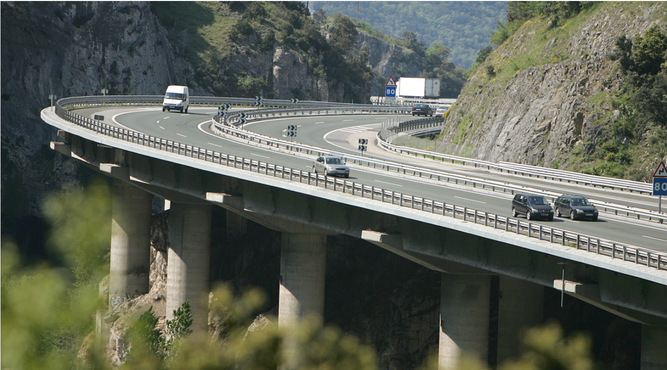
AP-68: Bilbao-Zaragoza. Pk 52 + 100, Viaducto de Subijana
