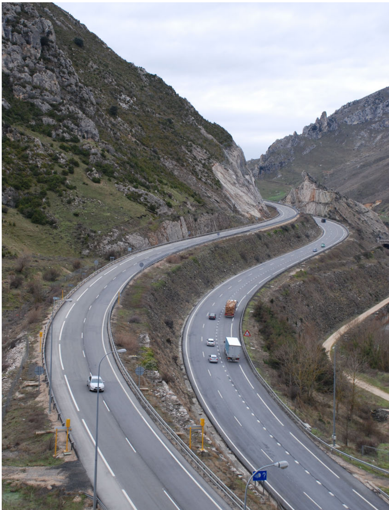
AP-1: Burgos-Armiñón. Desfiladero de Pancorbo (Burgos)
