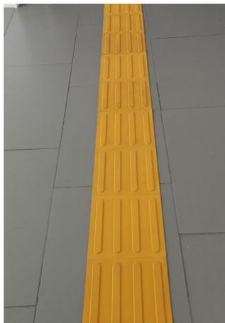
Señalización podotáctil en el interior de edificio
