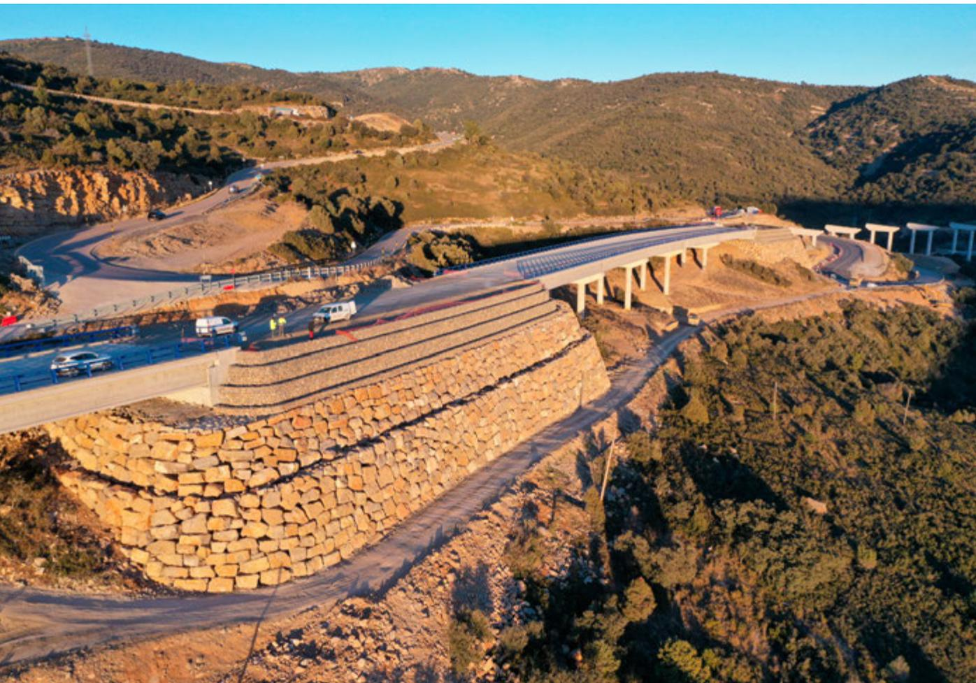
Muro de escollera ejecutado entre dos viaductos.
