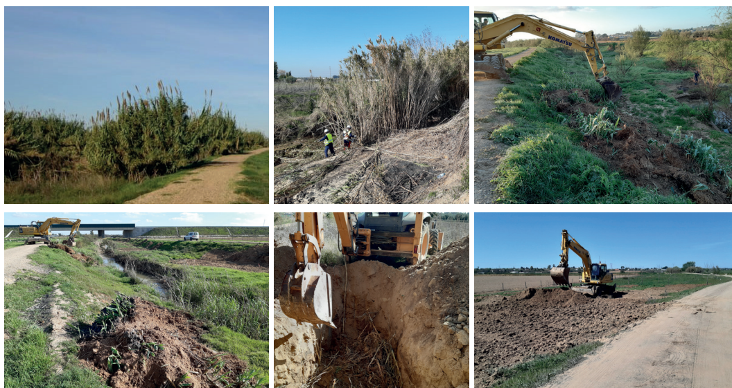
FIG. 8/ Evolución de los trabajos de eliminación de la caña común ( Arundo donax ) e inertización de rizomas
