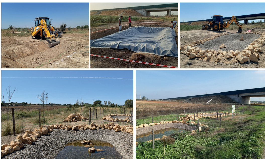
FIG. 10/ Evolución de los trabajos de construcción de charcas para anfibios
