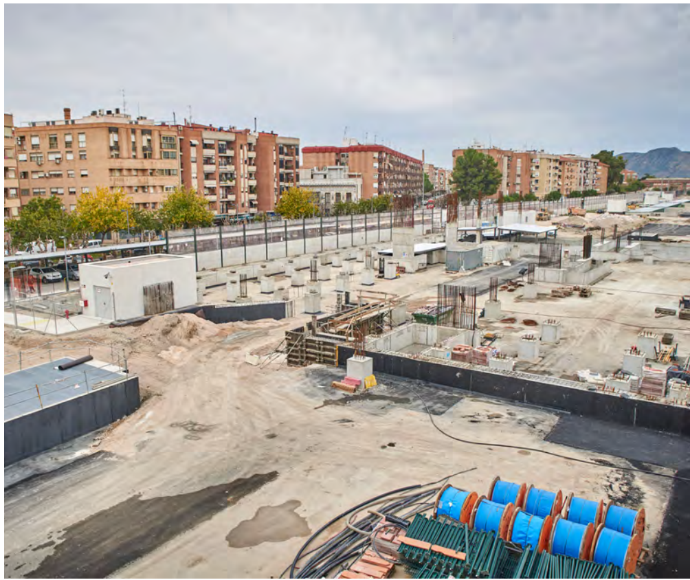
Obras sobre el corredor soterrado de la que será la estación definitiva de Murcia.
