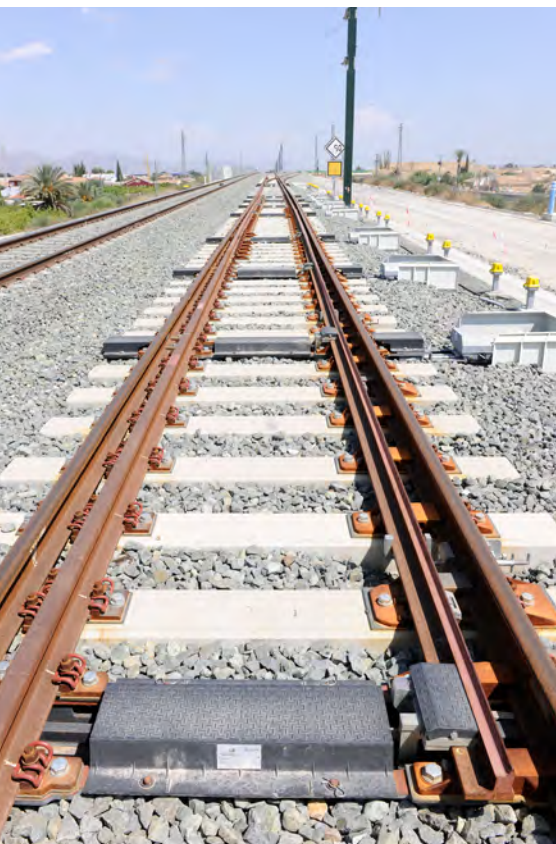
Detalle del tercer carril.
