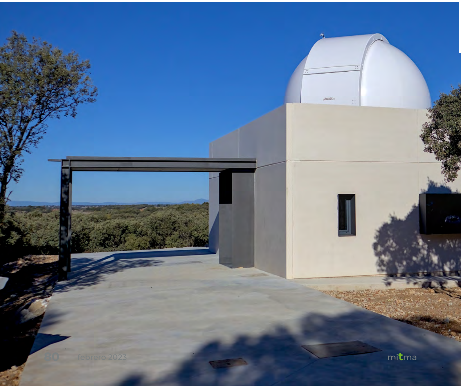
Edificio de la estación YLARA.
