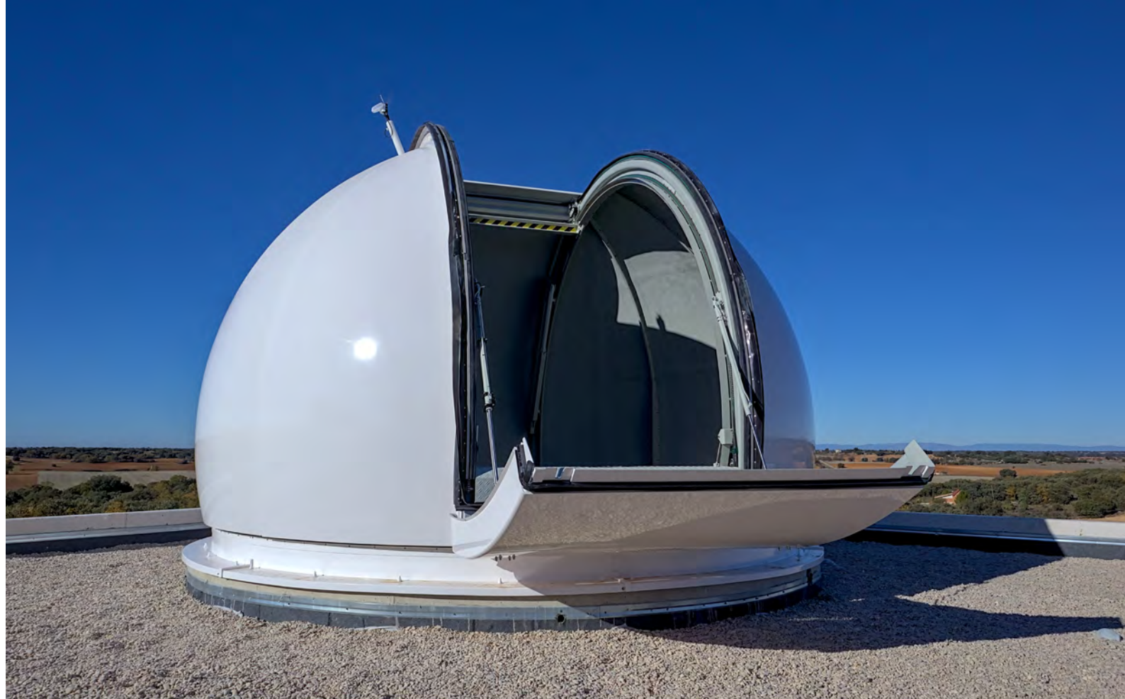
Cúpula de Baader Planetarium tipo slit type de 5.3 metros instalada en la estación del Observatorio de Yebes.
