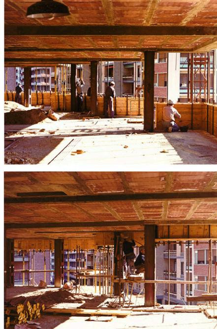
FIG. 7./ Escario-Vidal-Vives (EVV): Edificio 'Vitalicio', dibujo del sistema de montaje de los encofrados de los antepechos de hormigón (izquierda). Imágenes del dicho montaje, invierno de 1971 (derecha)
