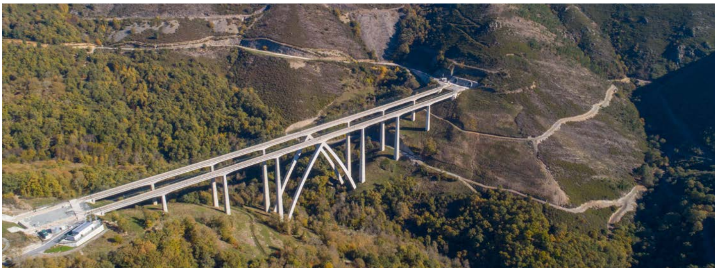
El viaducto de Teixeira adaptó su diseño y construcción para minimizar la afección a un LIC.
