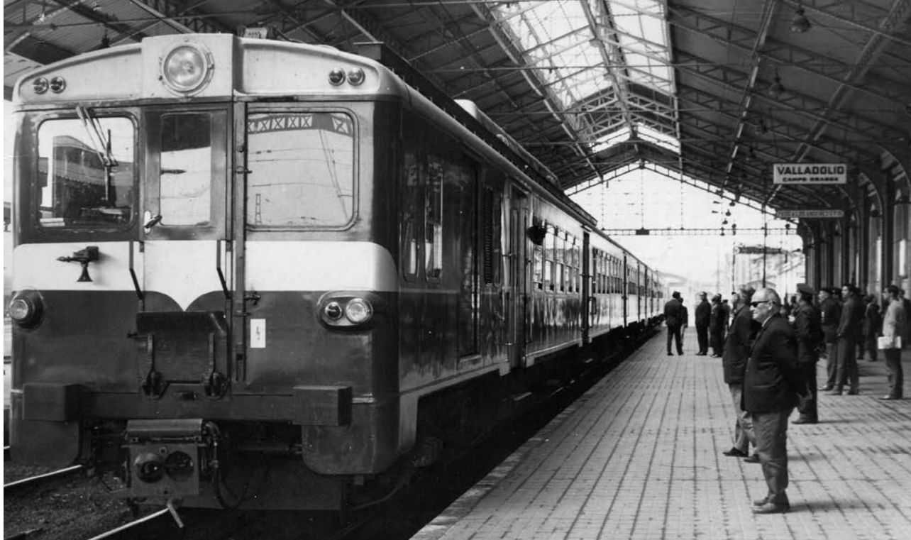
Estación de Valladolid, años 60.
