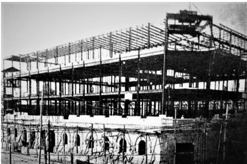
FIG. 12/ Esqueleto de acero en los cuatro pisos del Edificio de Correos. Sin autor, Ca. 1903
