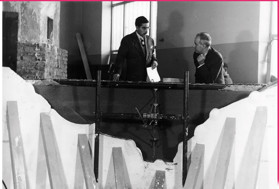
Ensayo del modelo de una cubierta para el Club Táchira de Caracas, proyecto de Eduardo Torroja (1957).
