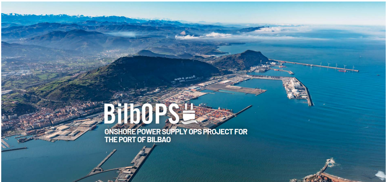
BilbOPS para el suministro de energía eléctrica en los atraques de los buques del Puerto de Bilbao.
