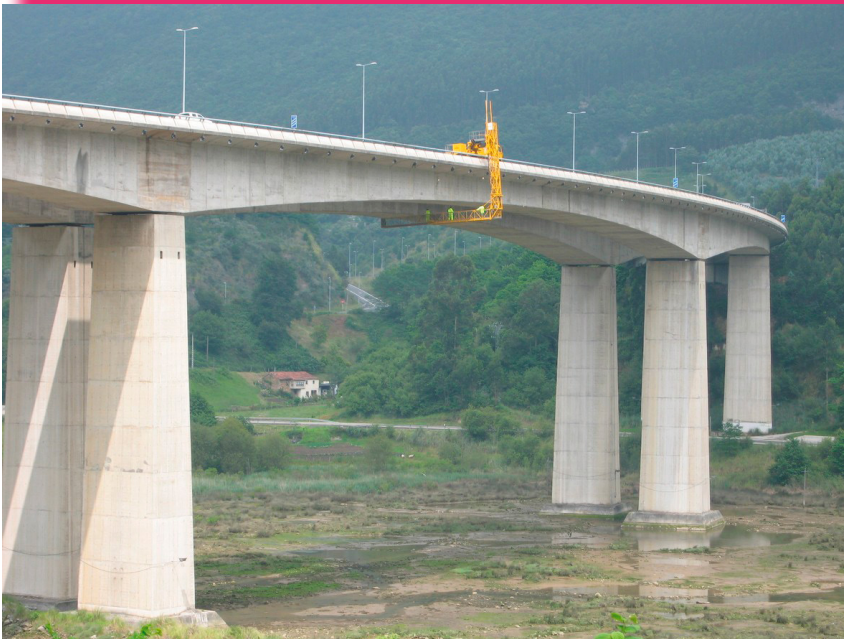
Inspección del viaducto de Oriñón (2008), construido con el método de avance en voladizo.
