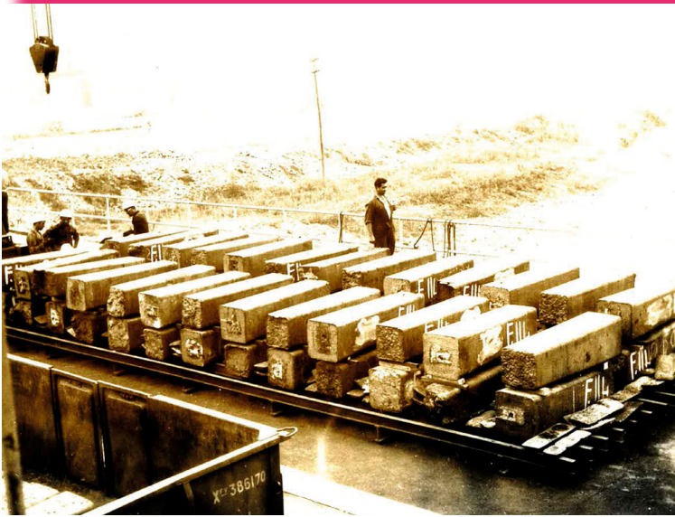
Pruebas de carga: puente del embalse de Las Segadas (1964) y viga en AZCA (1969).
