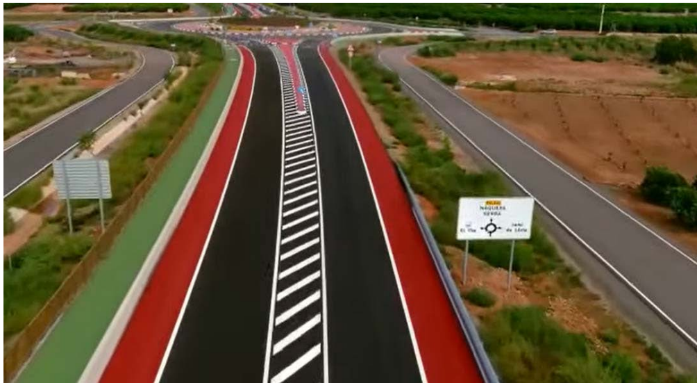
Fotografía 4.1 Oferta dual de infraestructura ciclista en carretera.
