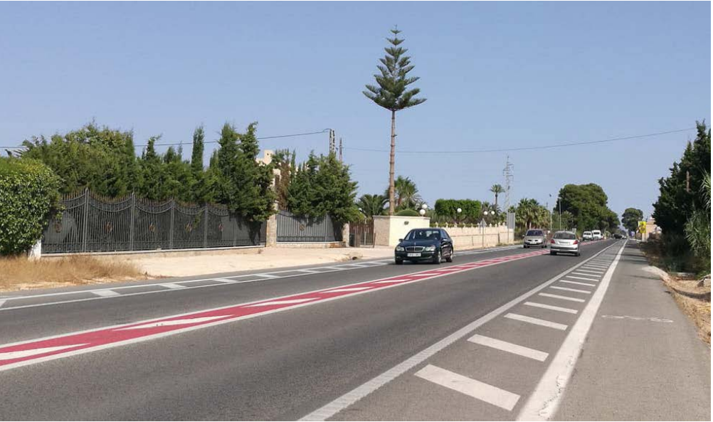
Fotografía 5.30 Ajuste de calzada mediante «Dientes de dragón» en travesía
