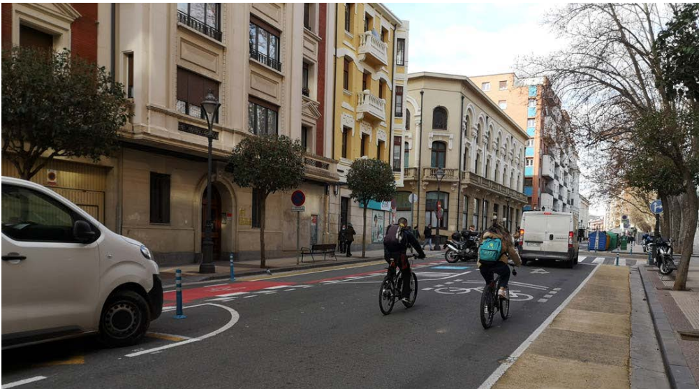
Fotografía 2.4 Urbanismo táctico. Adecuación de glorieta para reducir calzada e incluir vía ciclista
