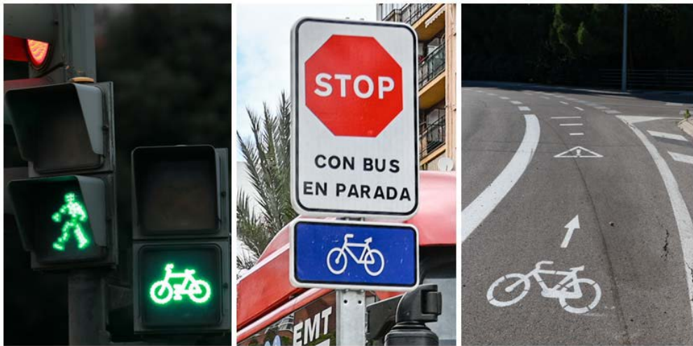
Fotografía 6.9 Señalización semafórica, señalización vertical y señalización horizontal
