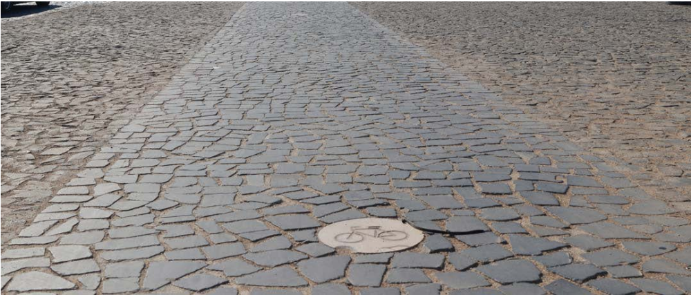
Fotografía 6.27 Diferenciación del pavimento ciclista mediante el color de los adoquines
