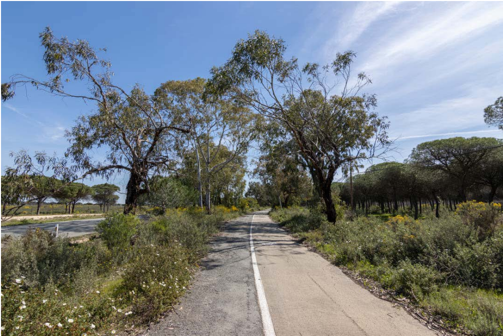
Fotografía 6.33 Las labores de mantenimiento deben evitar la invasión de vegetación en las vías ciclistas
