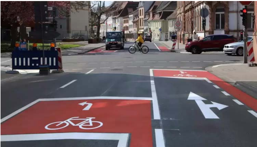
Fotografía 5.10 Plataformas avanzadas de espera y carriles ciclistas complementarios de acceso
