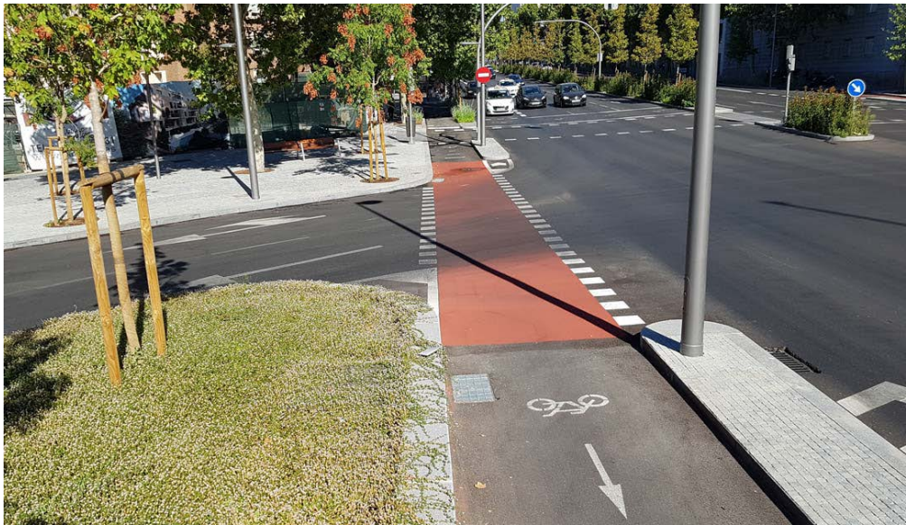
Fotografía 5.14 Carriles ciclistas unidireccionales en glorieta partida
