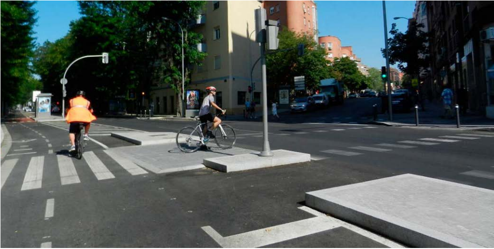
Fotografía 6.10 Diferente regulación para los ciclistas en un paso peatonal semaforizado
