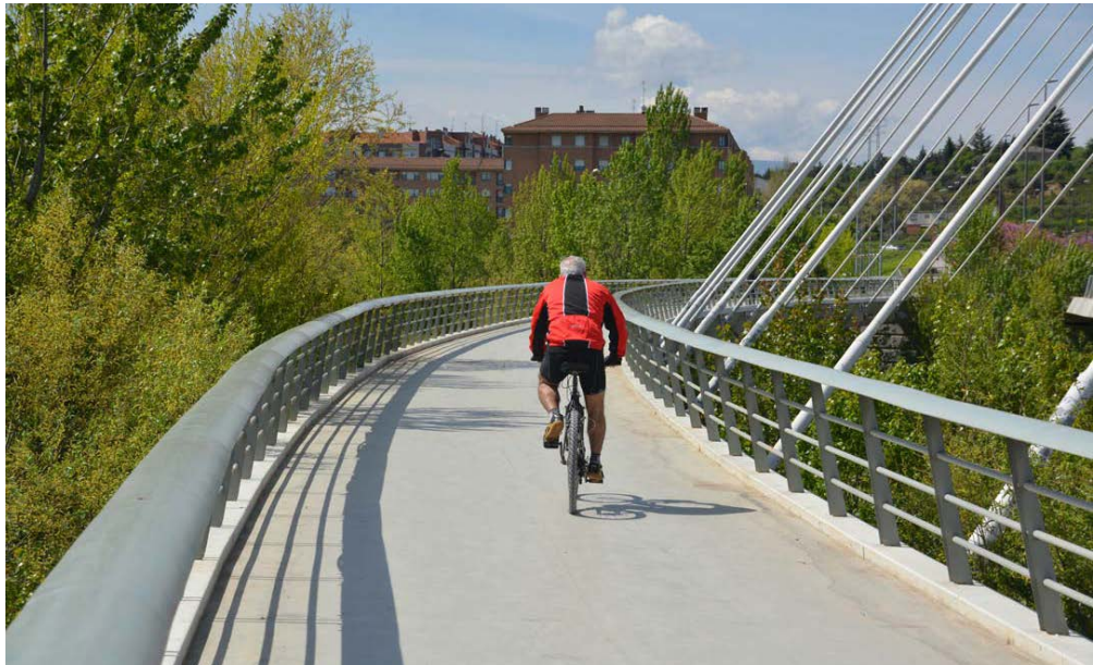
Fotografía 6.5 Barandilla con pasamanos volcado hacia la plataforma ciclista
