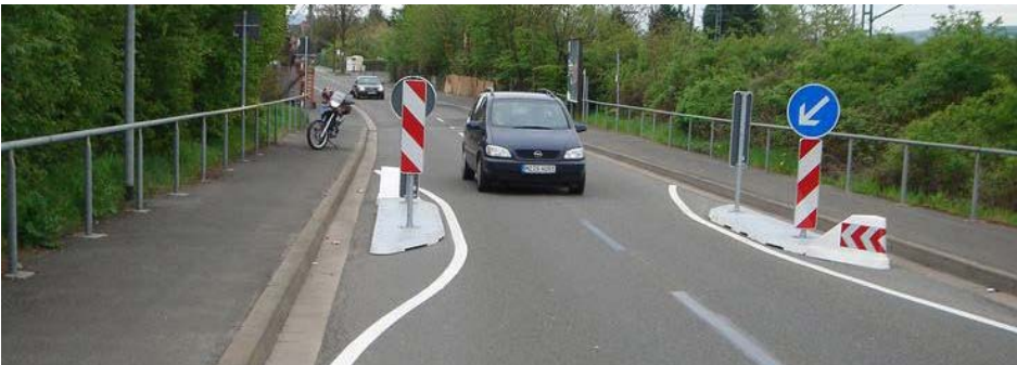
Fotografía 5.33 Estrechamiento lateral en zona interurbana
