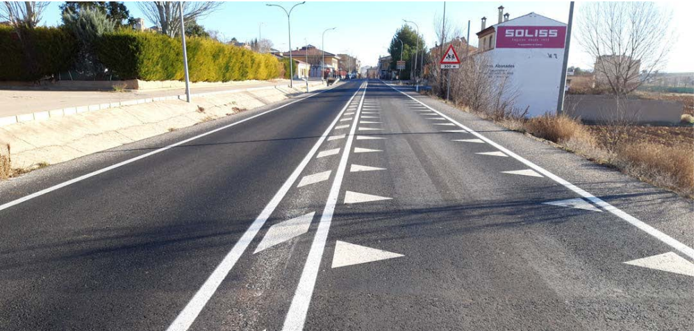
Fotografía 5.30 Ajuste de calzada mediante «Dientes de dragón» en travesía
