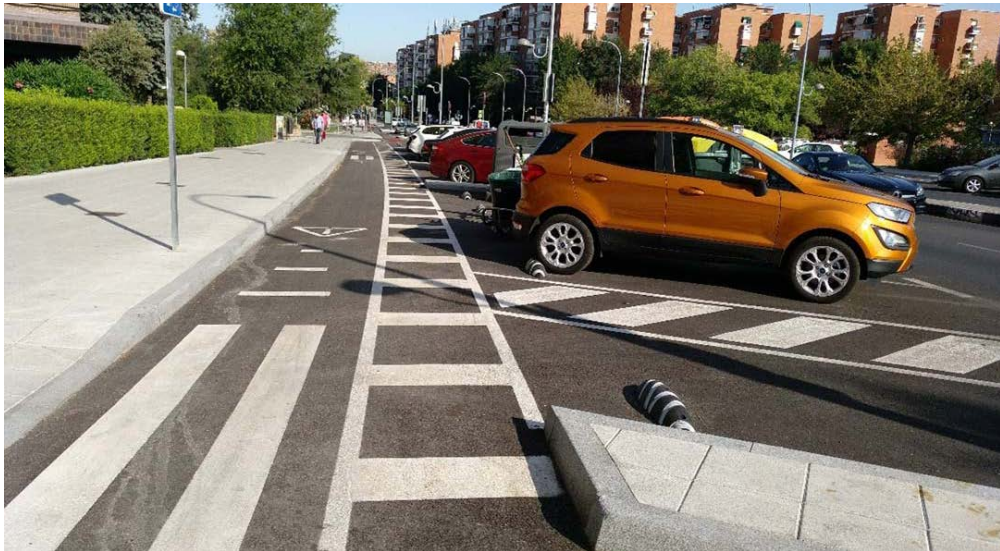
Fotografía 4.12 Vía ciclista unidireccional entre la banda de servicio con aparcamiento en batería y la acera
