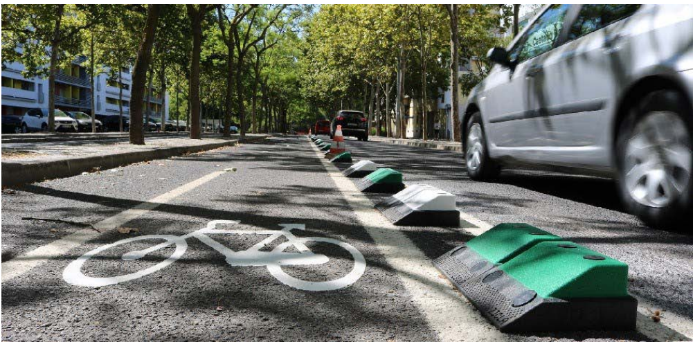
Fotografía 6.43 Separadores plásticos de perfil longitudinal rectangular
