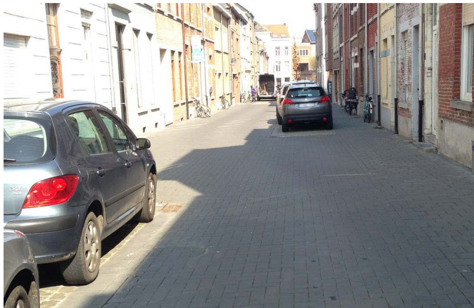
Fotografía 5.35 Zigzag mediante disposición alterna del aparcamiento
