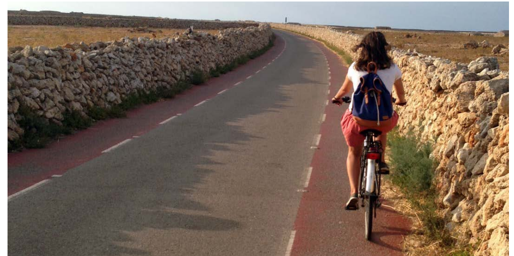
Fotografía 4.21 Banda de protección en plataforma muy estrecha
