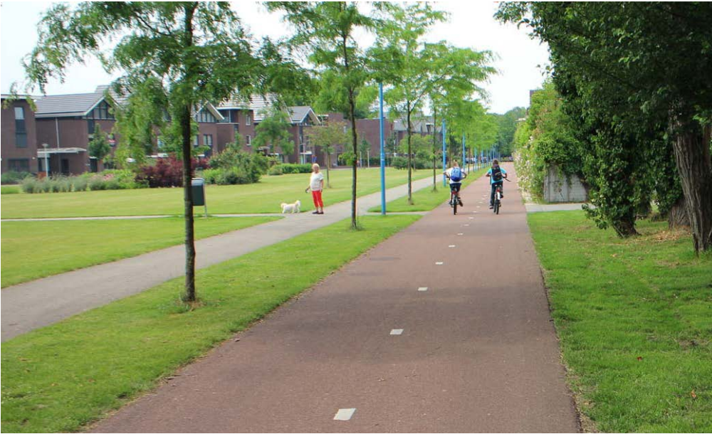
Fotografía 6.12 Marca vial de separación de sentidos economizando pintura
