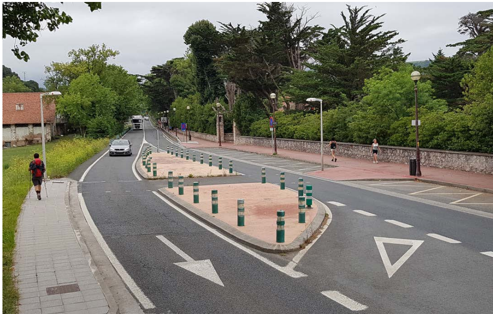
Fotografía 5.39 Cruce peatonal / ciclista sin prioridad sobre carretera
