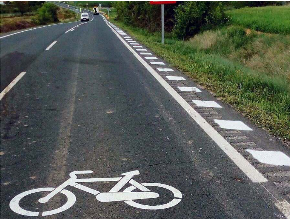
Fotografía 4.23 Acondicionamiento de carril con refuerzo de la señalización ciclista en carretera interurbana
