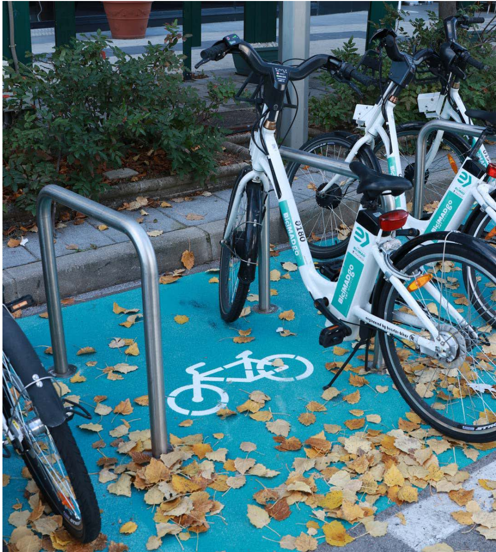
Fotografía 7.5 Aparcabicis U invertida más sencillo y extendido (con dos anclajes en el suelo)
