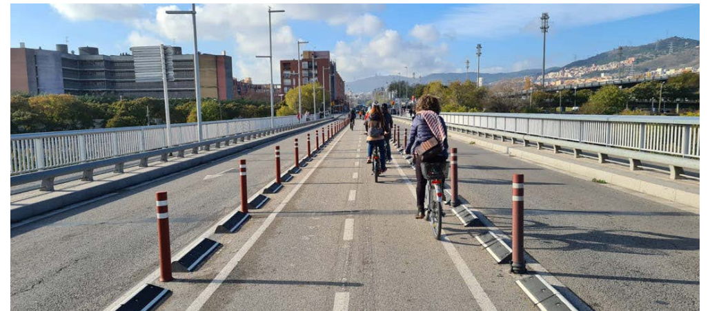
Fotografía 6.46 Hitos cilíndricos como complemento de separadores bajos
