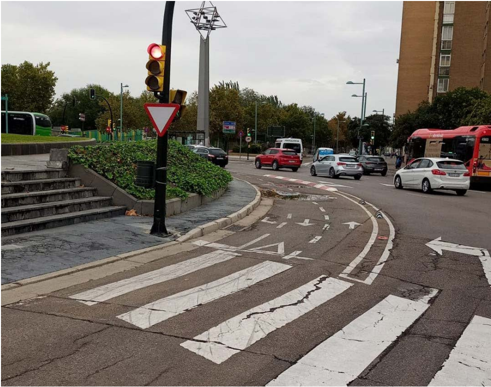
Fotografía 5.13 Trazado de una vía ciclista por el anillo interior de una rotonda
