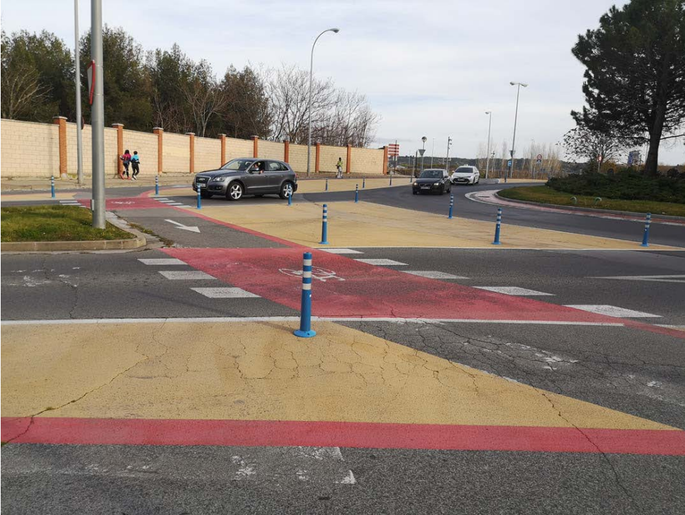
Fotografía 5.11 Glorieta grande convertida mediante medidas de bajo coste en glorieta compacta y carril ciclista segregado unidireccional
