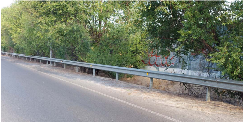
Fotografía 8.1 Ejemplo de arcén sin la adecuada limpieza
