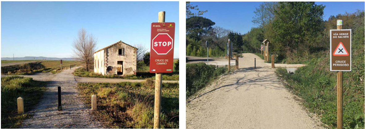
Fotografía 5.7 Vías ciclistas que cruzan caminos con ceda el paso u obligación de parada en vía ciclista
