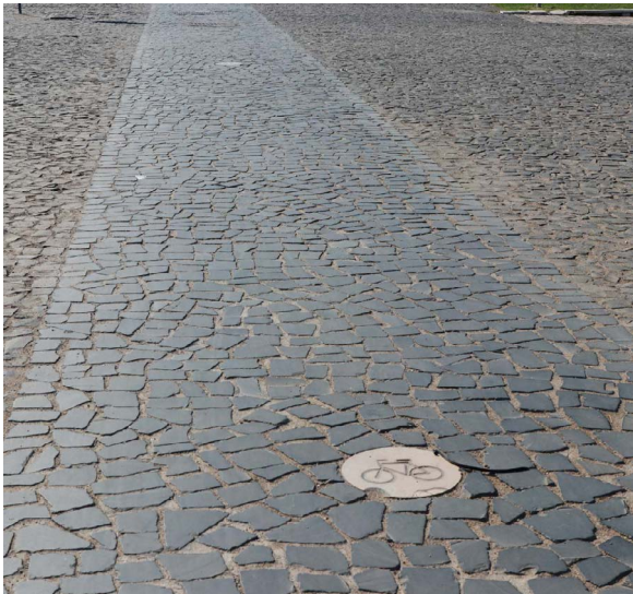
Fotografía 5.5 Ejemplo de guía para ciclistas en itinerarios que atraviesan espacios peatonales
