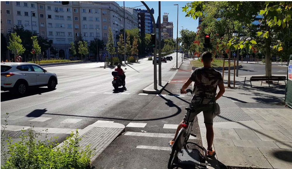
Fotografía 5.15 Regulación semafórica diferente de las vías ciclistas en glorieta partida
