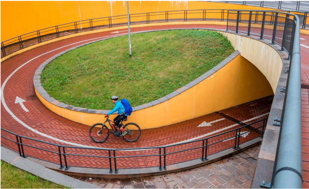
Fotografía 6.2 Las pendientes constituyen un elemento esencial en el diseño de pasos a distinto nivel.
