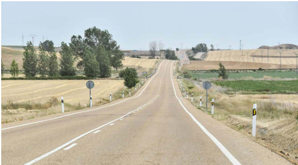
Fotografía 3.2 Imagen de una carretera tipo A
