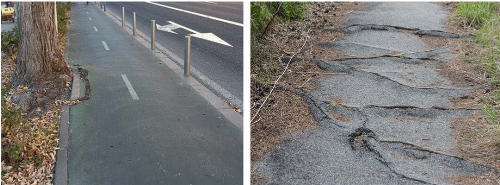
Fotografía 6.32 Las raíces de árboles cercanos a menudo deterioran el firme de las vías ciclistas
