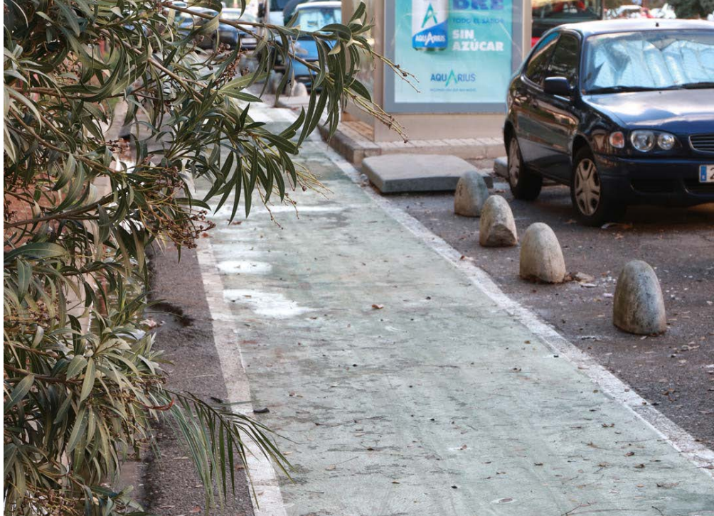
Fotografía 8.4 Ejemplo de mantenimiento deficiente respecto a la vegetación de borde
