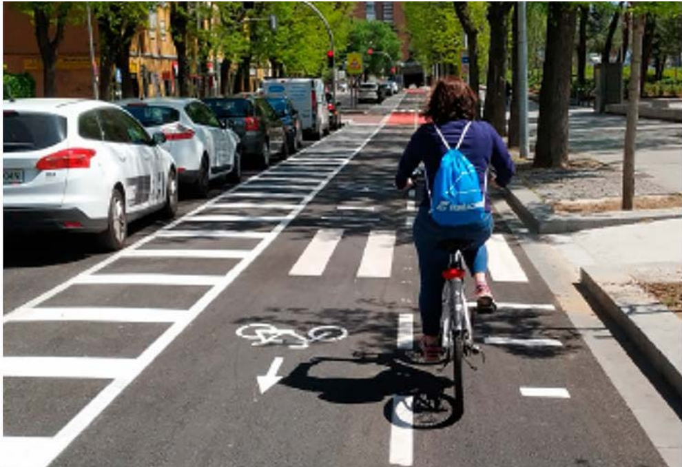
Fotografía 4.13 Vía ciclista bidireccional entre la banda de servicio con aparcamiento en línea y la acera
