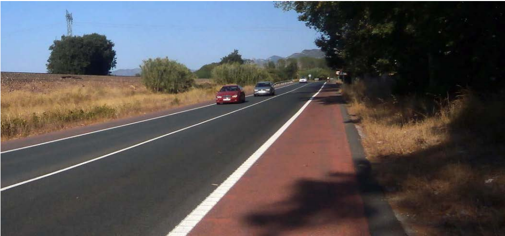
Fotografía 4.24 Acondicionamiento del arcén para la circulación ciclista
