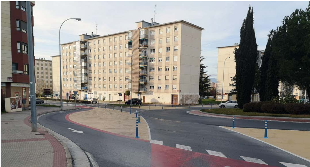
Fotografía 2.4 Urbanismo táctico. Adecuación de glorieta para reducir calzada e incluir vía ciclista
