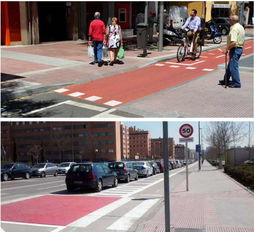
Fotografía 5.2 Vía ciclista que cruza paso peatonal a cota de calzada
