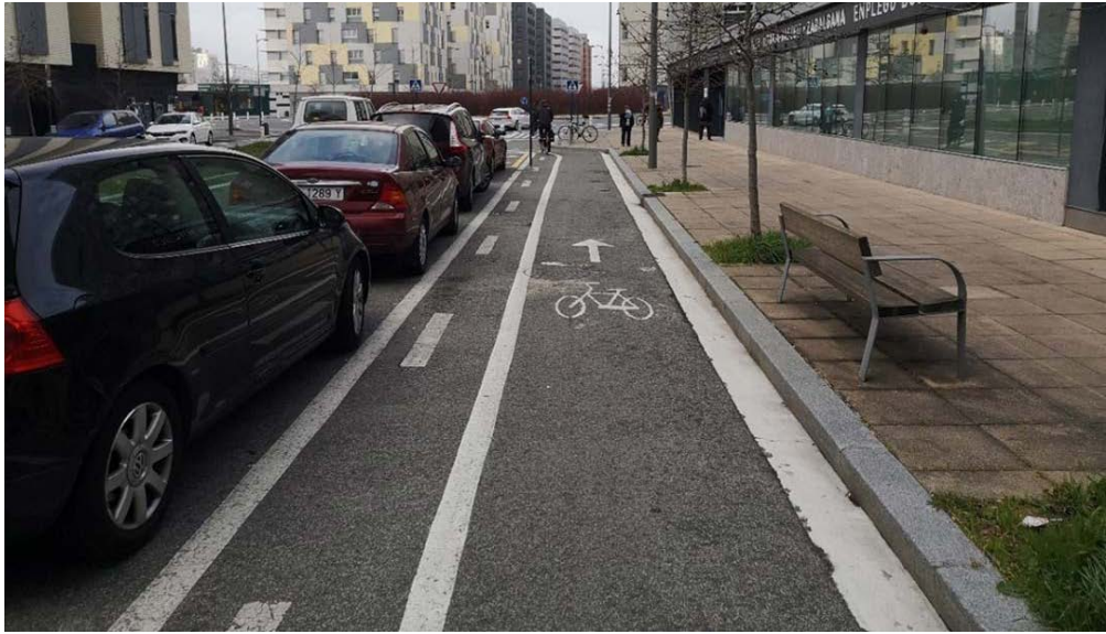
Fotografía 4.11 Vía ciclista unidireccional entre banda de servicio con aparcamiento en línea y la acera
