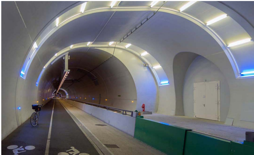
Fotografía 6.17 Los túneles requieren iluminación constante
