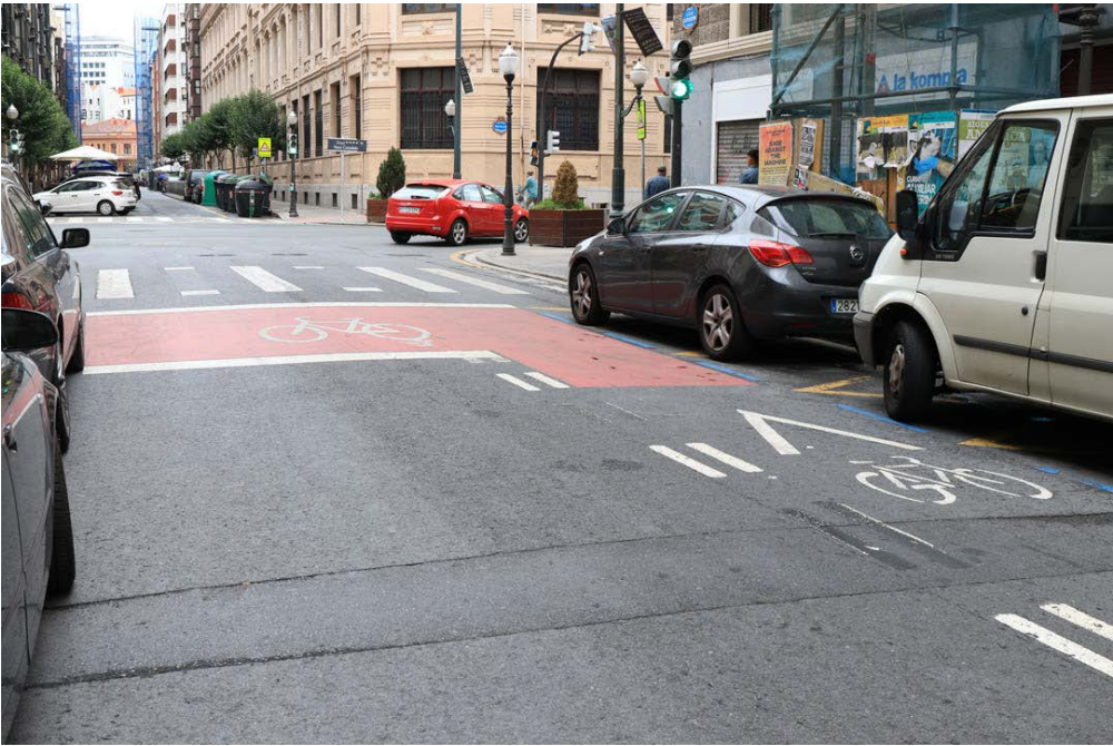
Fotografía 5.9 Plataforma avanzada de espera para ciclistas
