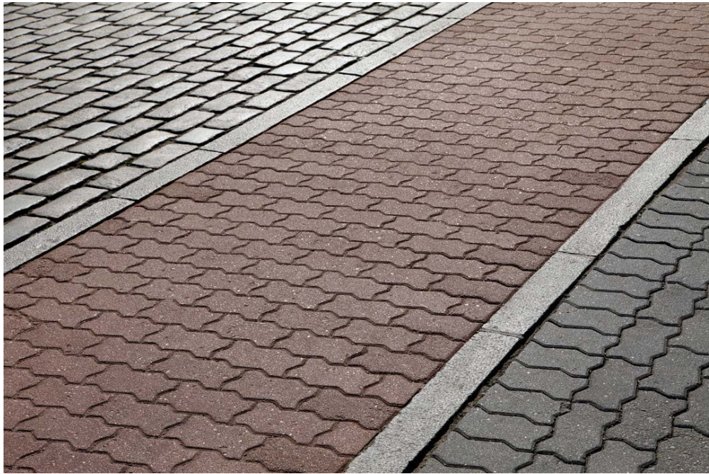
Fotografía 6.26 Pavimento de adoquines prefabricados. Requiere encintado con bordillo
