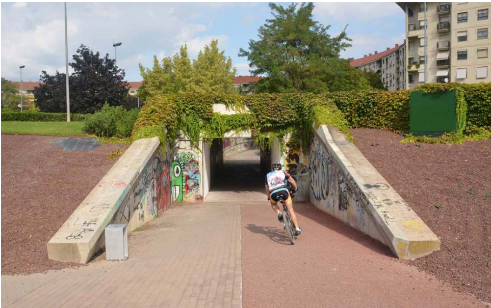
Fotografía 6.6 Los pasos inferiores cortos favorecen la visibilidad de los usuarios
