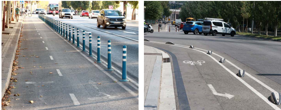
Fotografía 4.4 Elementos de protección discontinua
