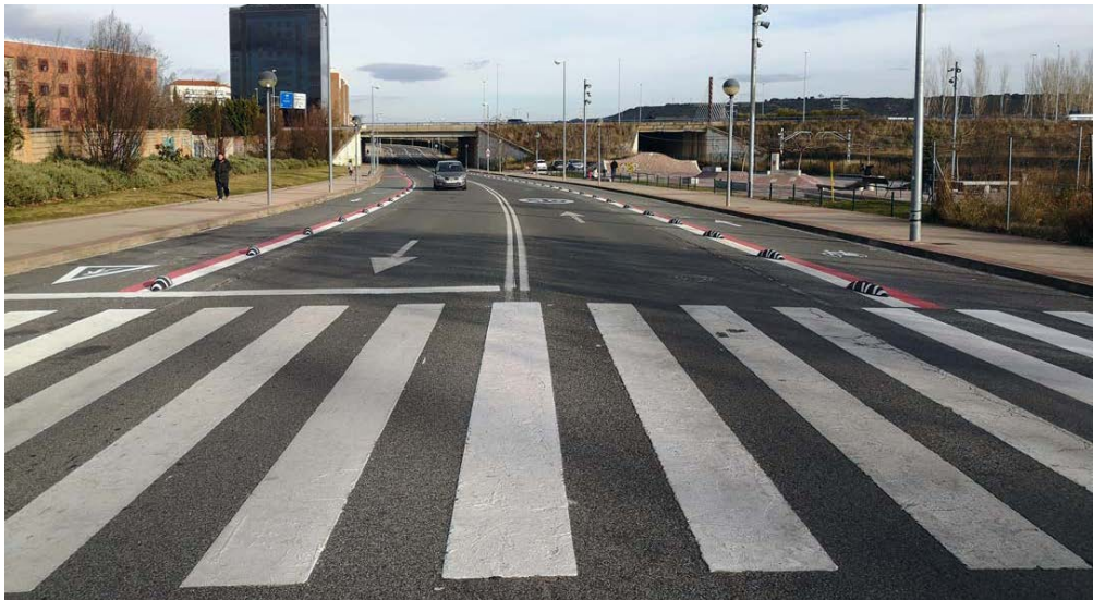
Fotografía 4.8 Vía ciclista unidireccional en lateral entre calzada y acera
