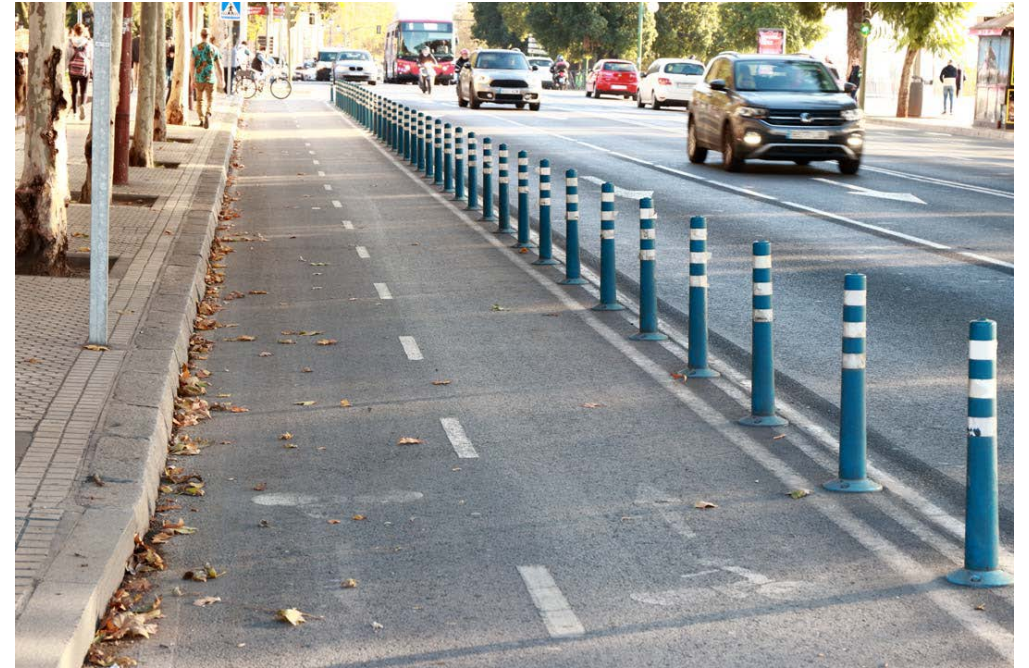
Fotografía 6.46 Hitos cilíndricos como complemento de separadores bajos
