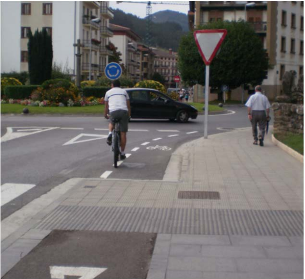
Fotografía 5.12 Transición de vía ciclista segregada a uso compartido de la calzada en aproximación a una glorieta.
