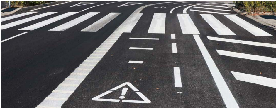
Fotografía 4.2 Delimitación con línea blanca continua con bandas sonoras
