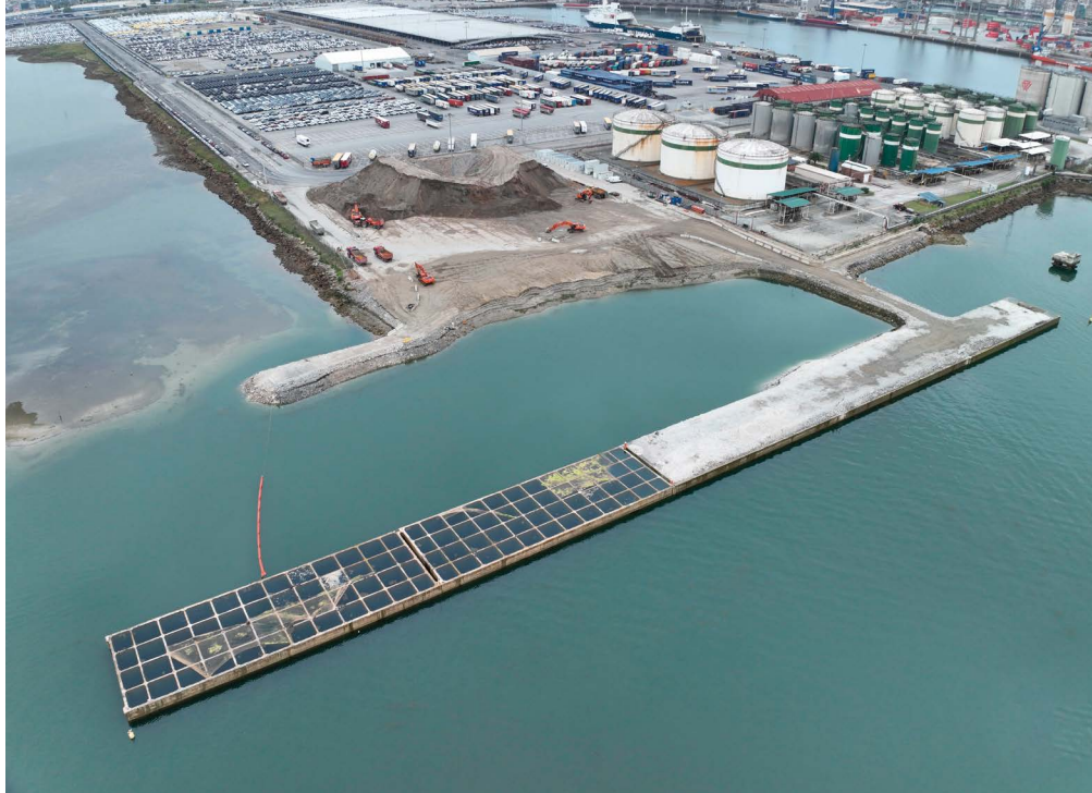
Imagen aérea del relleno de los cajones.
