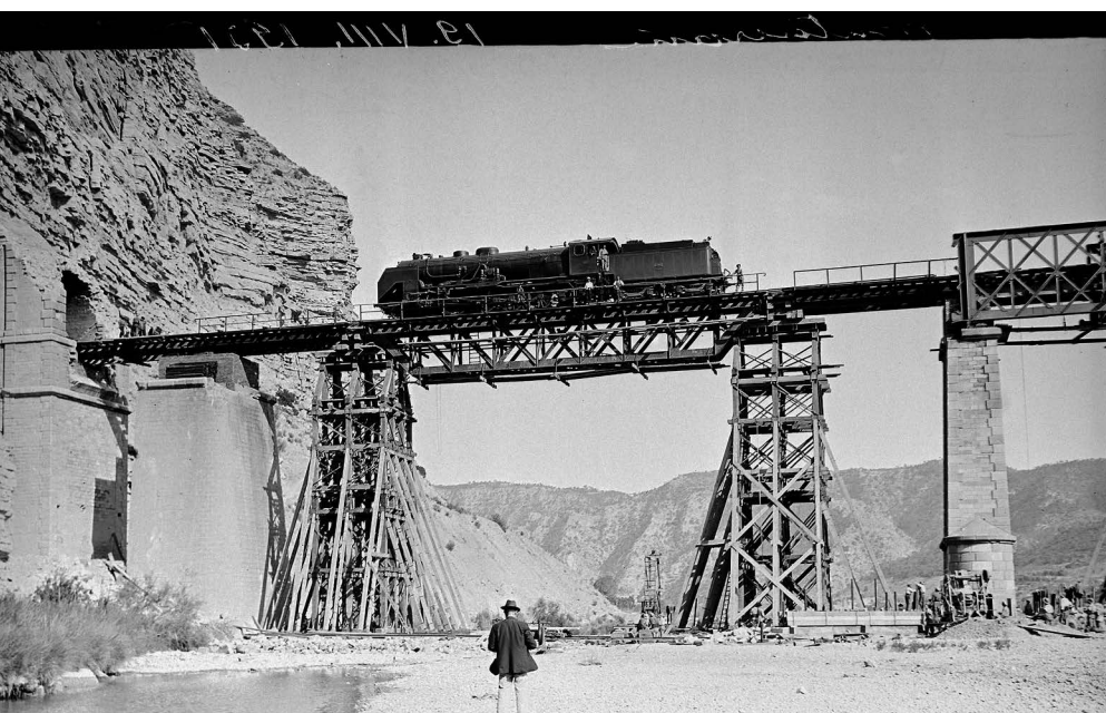
Prueba de carga del tramo de vía provisional instalado sobre dos castilletes de traviesas, para restablecer el servicio de la línea tras el accidente. 19 de agosto de 1931.
