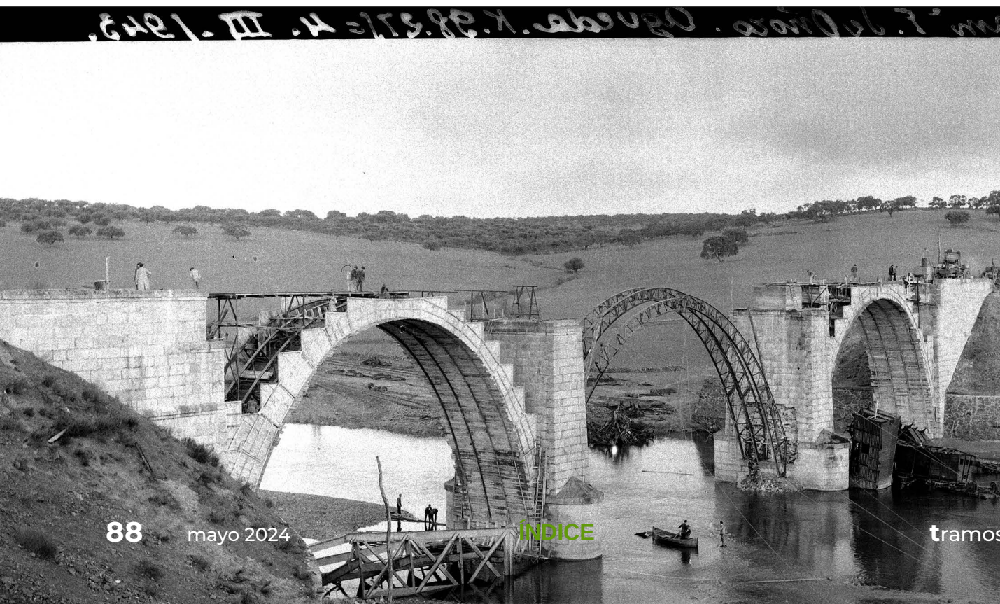
Hormigonado de los extremos del nuevo puente Mariego sobre el río Águeda, en el p. k. 98,275 de la línea de Salamanca-Fuentes de Oñoro. Año 1943.
