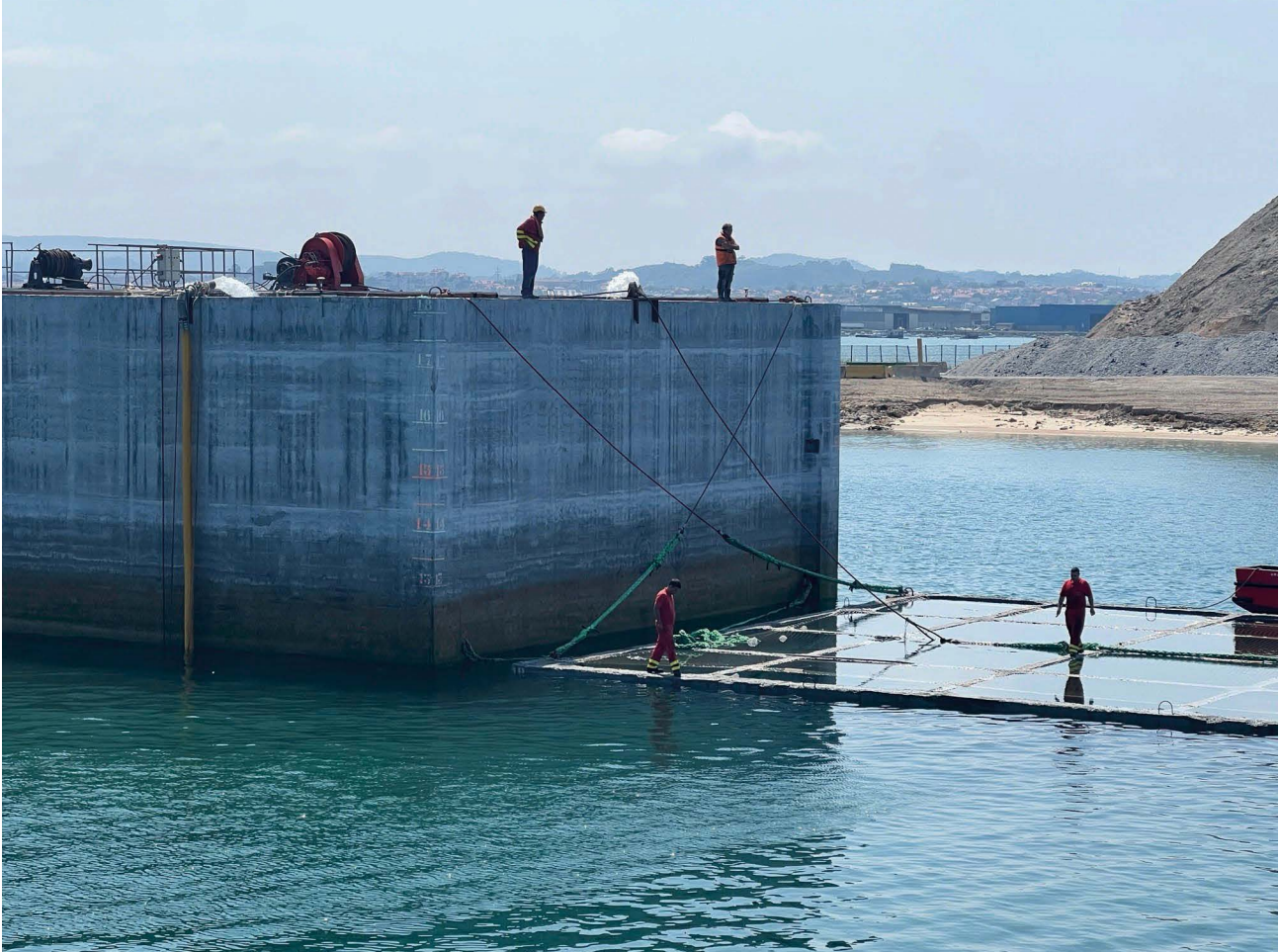
Fondeo de un cajón en su posición definitiva.
