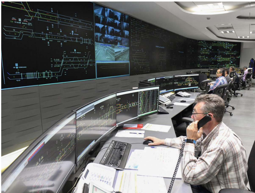
Videowall y puestos de CTC en el CRC de Madrid-Puerta de Atocha.
