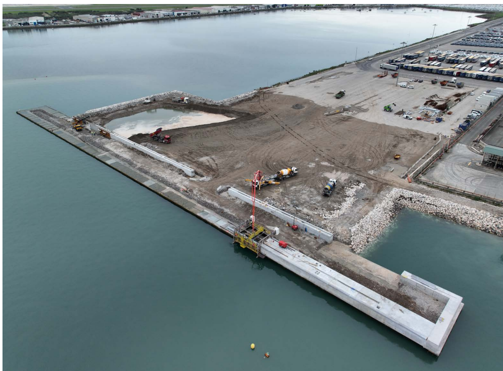
Ejecución de la viga cantil mediante carro de encofrado.
