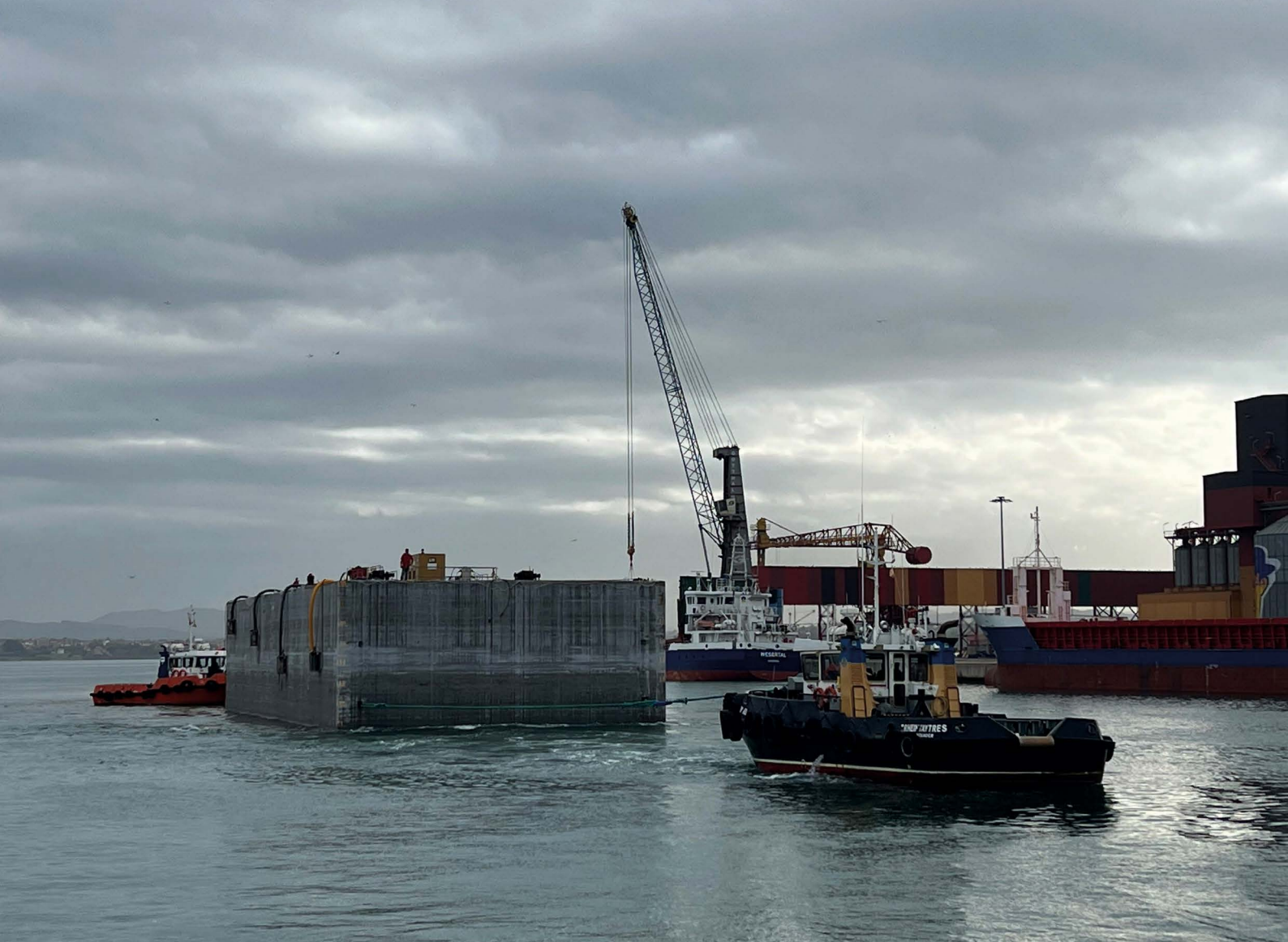
Traslado de uno de los cajones con el apoyo de un remolcador.
