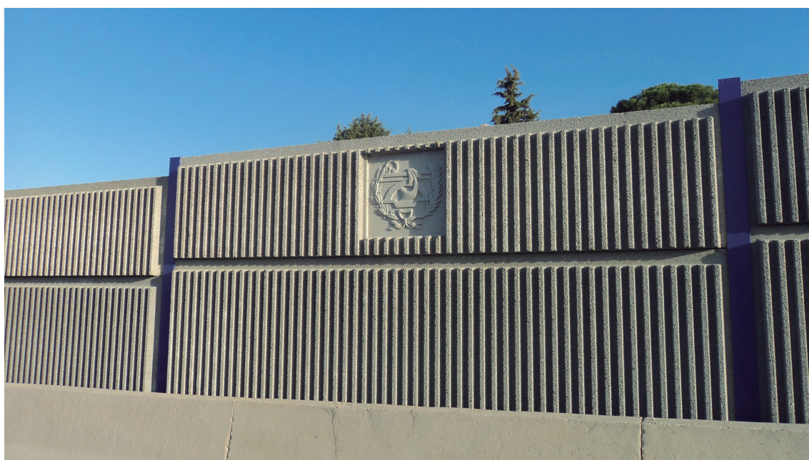
Figura 14: Vista de un panel de hormigón poroso absorbente.
