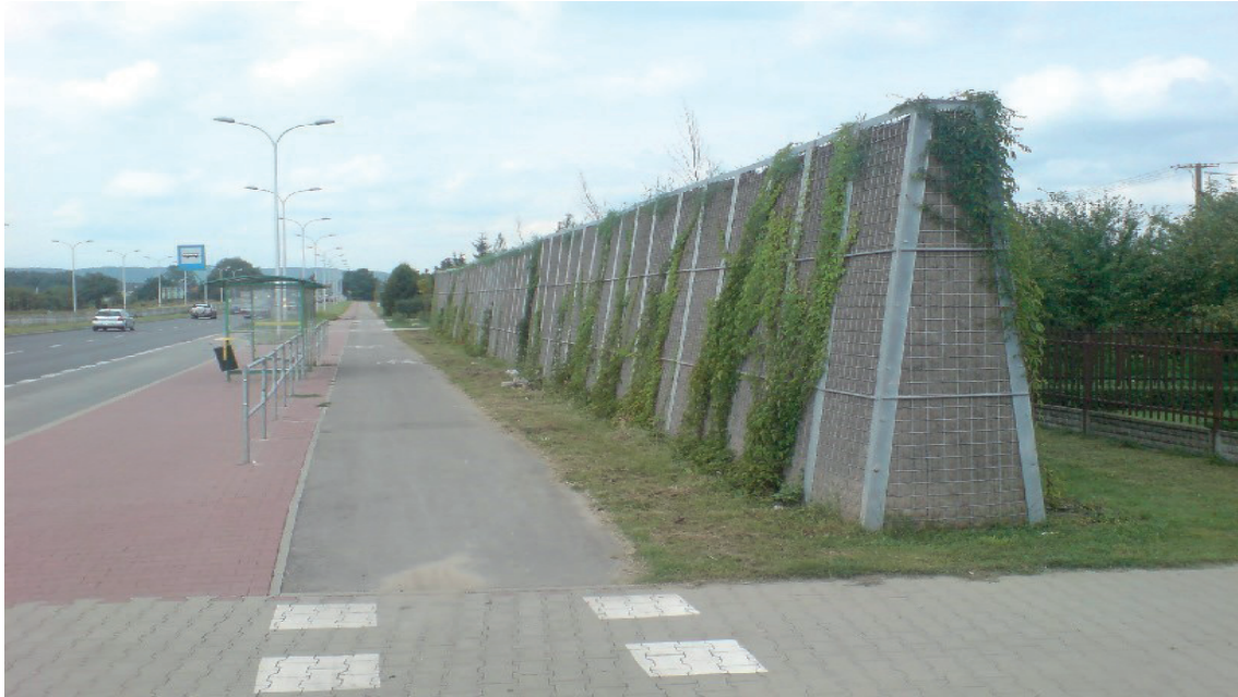
Figura 24: Pantallas acústicas vegetalizables con estructura portante interior.
