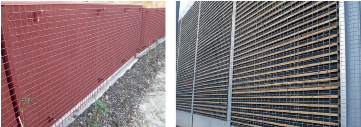
Figura 59: Ejemplos de mallas de protección antigrafiti sobre pantallas acústicas de hormigón y madera.
