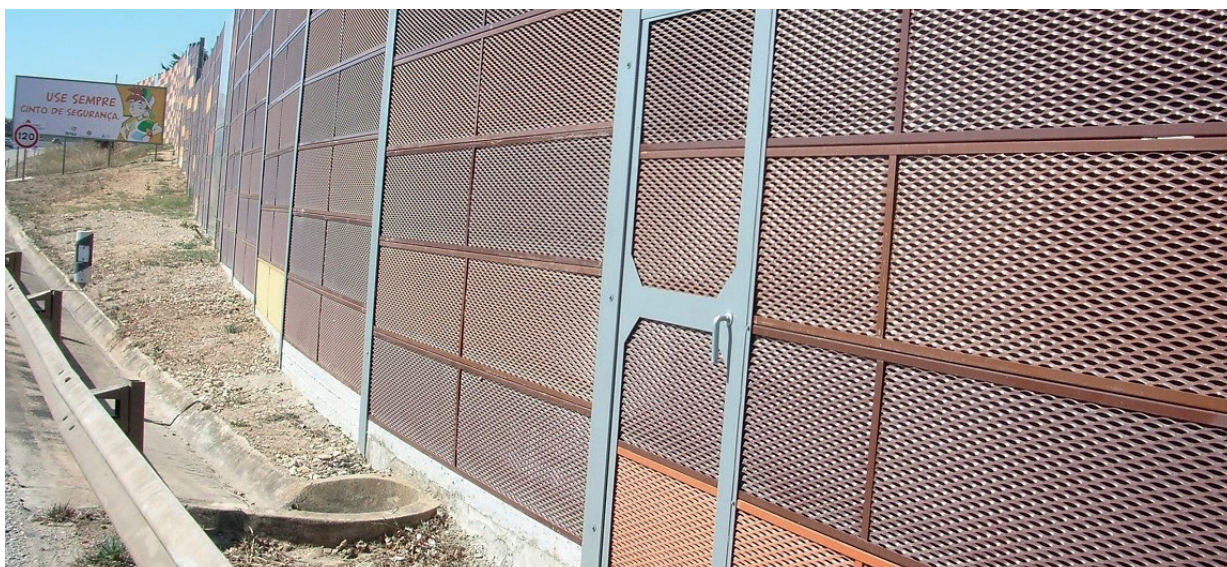
Figura 62: Vista de un tramo de pantalla metálica con una puerta de emergencia.
