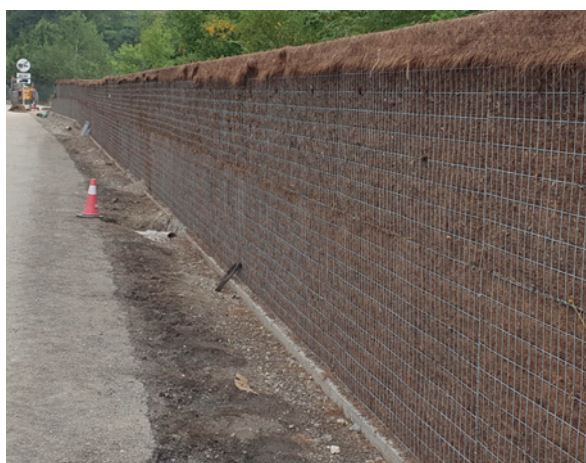
Figura 23: Pantallas vegetalizable a base de terreno reforzado y control de erosión con manta de coco.
