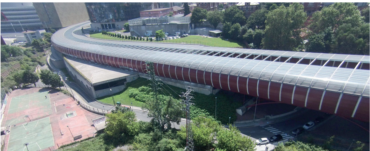
Figura 44: Galería quasi-total en los accesos a Olabeaga en Bilbao.
