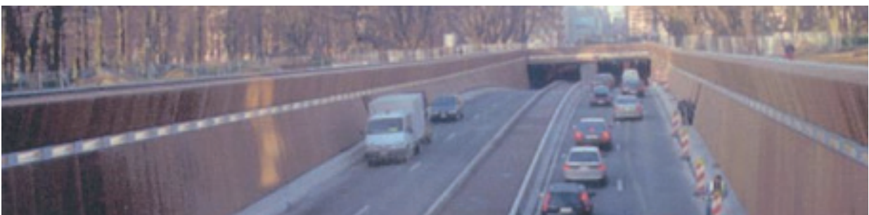
Figura 49: Vista de paneles de madera con fibra de vidrio.
