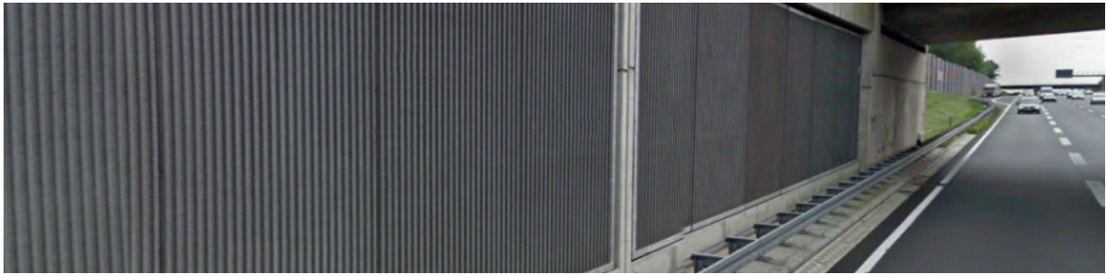
Figura 47: Vista de paneles porosos de hormigón.
