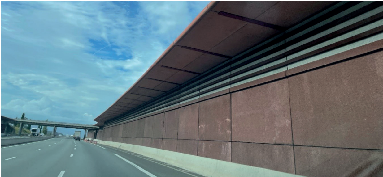
Figura 43: Cubierta parcial en la carretera A63 en Bidart (Francia).
