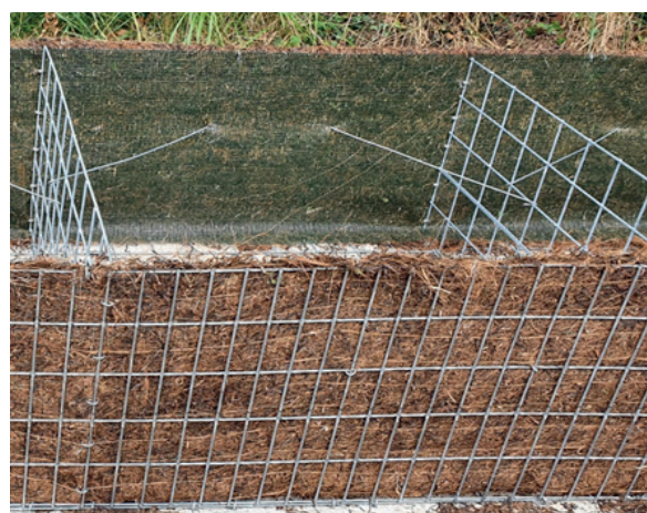
Figura 23: Pantallas vegetalizable a base de terreno reforzado y control de erosión con manta de coco.
