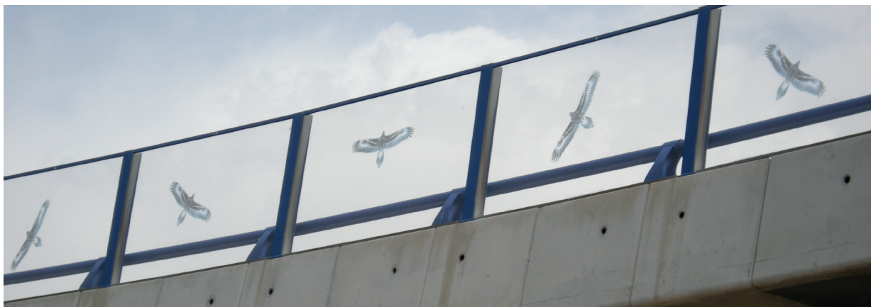
Figura 65: Pantalla transparente con siluetas de rapaces que no son efectivas para impedir las colisiones de aves.
