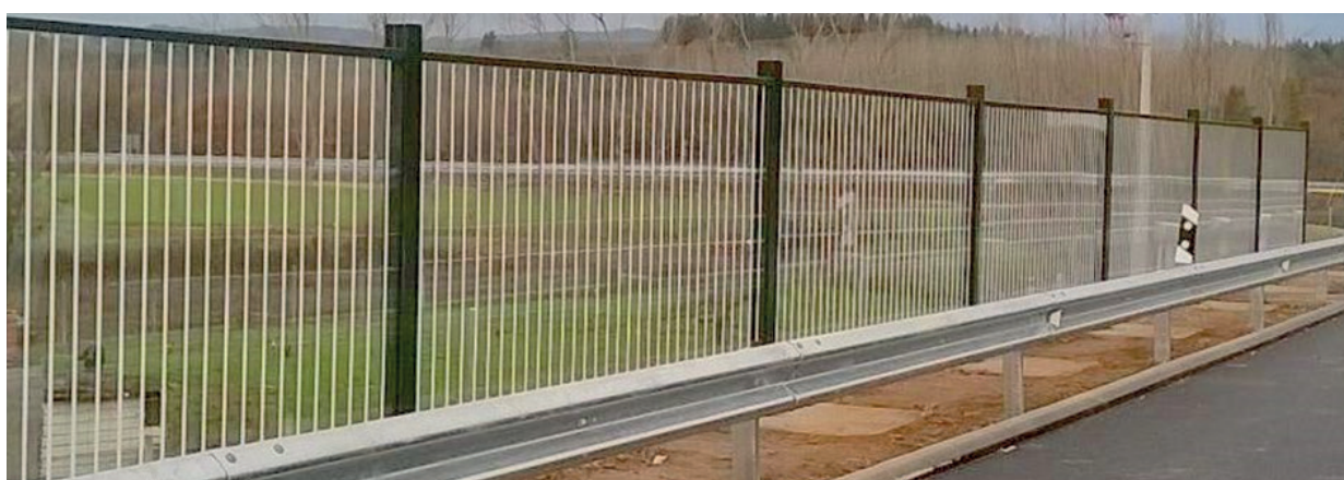
Figura 63: Pantalla transparente con franjas verticales para impedir las colisiones de aves.
