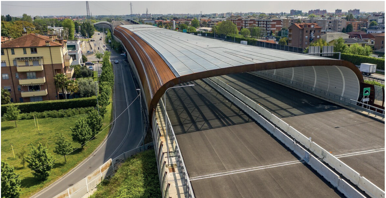
Figura 45: Cubierta total de la vía en Italia.
