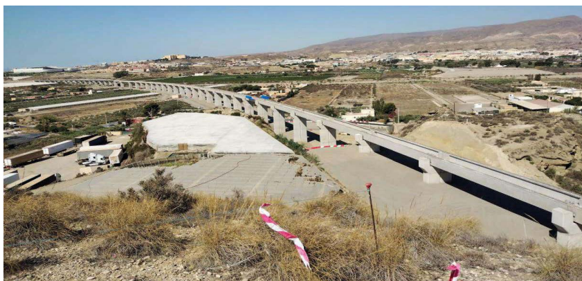
Viaducto sobre el río Andarax (1414 metros), el más largo de Almería.
