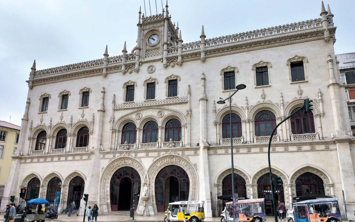
El edificio neogótico de tres plantas de la estación de Lisboa-Rossío es de estilo neogótico manuelino, de mampostería de ladrillo y mortero revestida con losas de piedra y la fachada de caliza.
