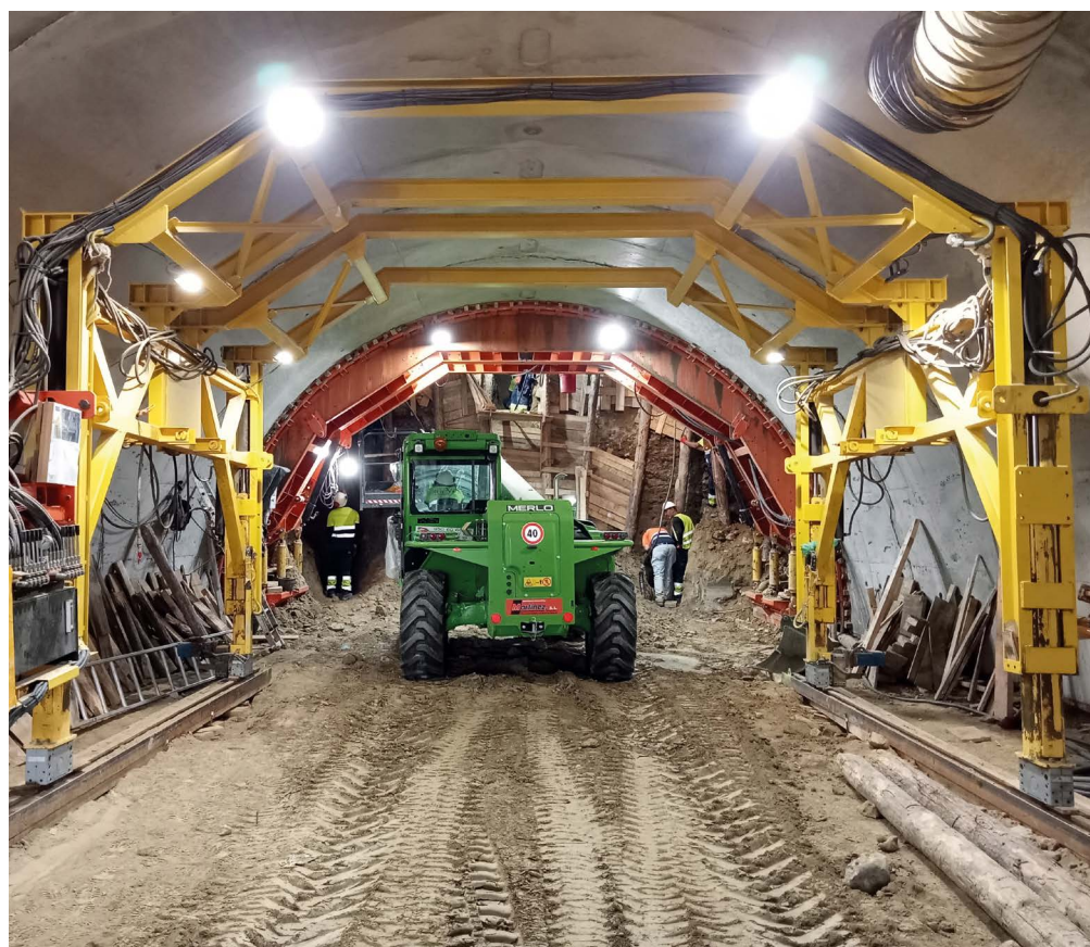
Trabajos en el túnel de Viator, ejecutado según el método belga.
