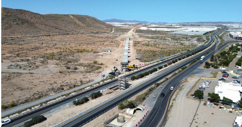
Ejecución de pilas del viaducto del Cebollero sobre la autovía A-7.
