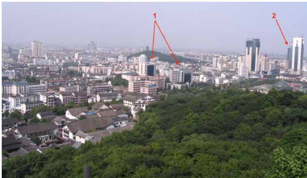
FIG. 2 / Shaoxing, vista de la colina Jishan desde la cumbre de Fushan, previa al inicio de las demoliciones.
