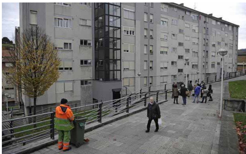
FIG. 5 / Ejemplo de rehabilitación de viviendas municipales: fachada y ascensor
