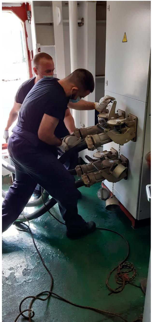
El nuevo reglamento para el despliegue de infraestructuras de combustibles alternativos (AFIR) establece objetivos de despliegue obligatorios para el suministro eléctrico de buques en puerto. La implementación de sistemas Onshore Power Supply (OPS) permitirá a los barcos conectarse a la red eléctrica terrestre, eliminando la dependencia de motores auxiliares y reduciendo significativamente las emisiones de CO<sub>2</sub> y la contaminación acústica.
