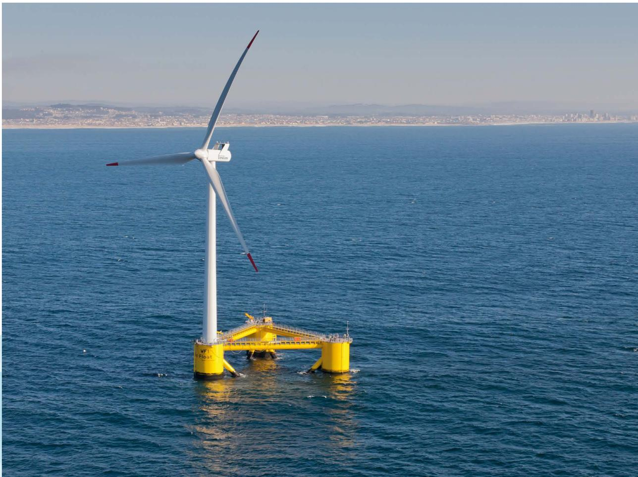
la capacidad de poder mantenerse a flote para no hundirse y la capacidad de permanecer estable ante los embates del mar y el viento para no volcar y quedar suspendido en la superficie marina. Por ello, están diseñados para mantenerse a flote gracias a unas "columnas" cilíndricas huecas, y algunos de ellos incorporan lastre para añadir estabilidad a la estructura.
