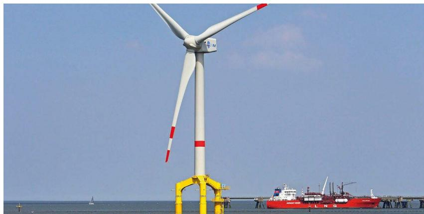
Marcado de aspas y de torre del aerogenerador con líneas rojas.
