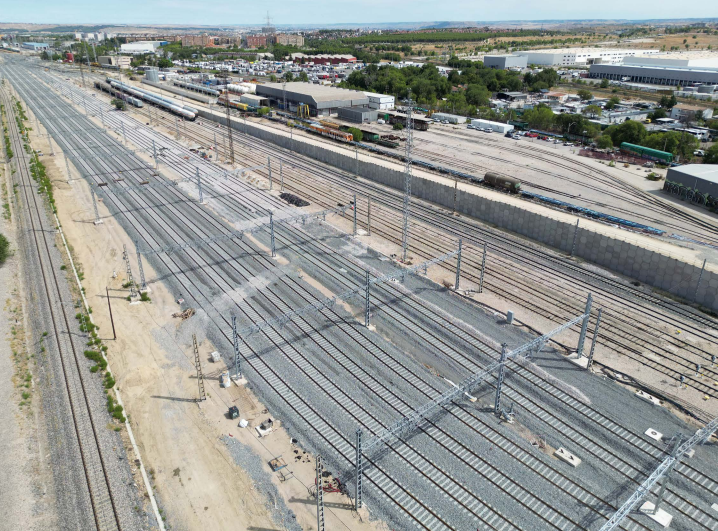
Instalación técnica y terminal de Madrid-Vicálvaro.
