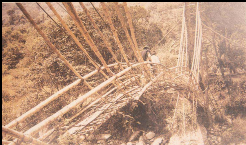
Ejemplo de utilización de materiales indígenas con técnicas europeas: puente en arco atirantado construido con guaduas. Tierradentro, Cauca.
