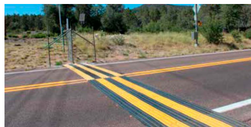
Placa electrificada sobre el pavimento. Prescripciones Técnicas para el Diseño de Pasos de Fauna y Vallados Perimetrales (2015).
