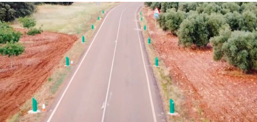
Disposición de las balizas a lo largo de una carretera. Fuente: Visever.
