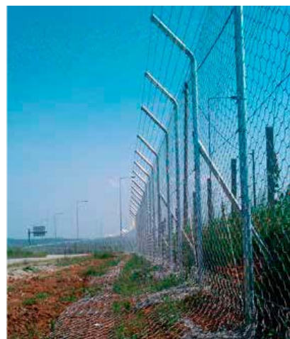
Vallado específico para oso con visera superior y faldón inferior. Prescripciones Técnicas para el Diseño de Pasos de Fauna y Vallados Perimetrales (2015).
