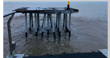
Fig. 8. "Gloria" demolishes the Pont del Petrolí.
