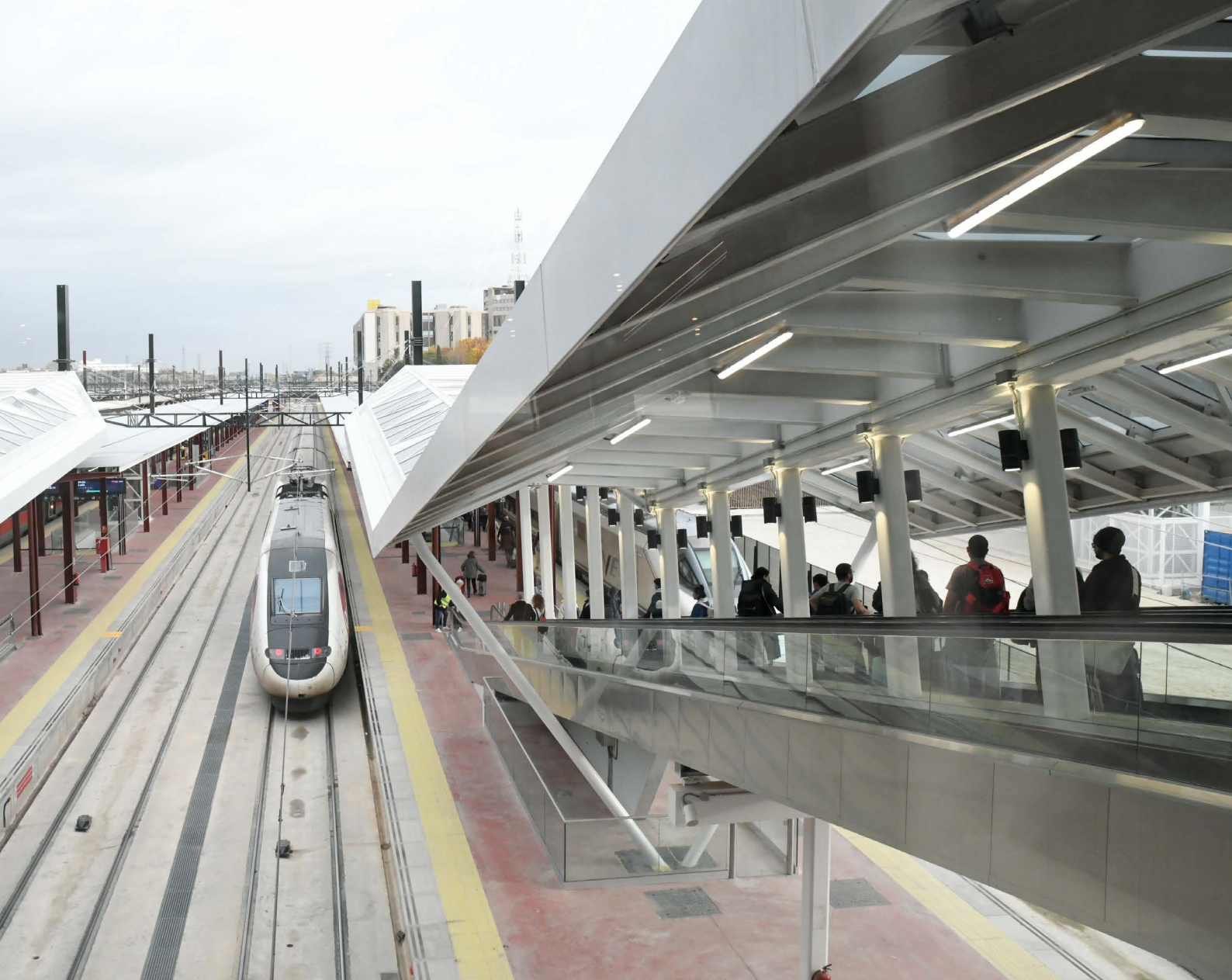
Vista desde el vestíbulo de las nuevas vías y fingers de acceso a los andenes.
