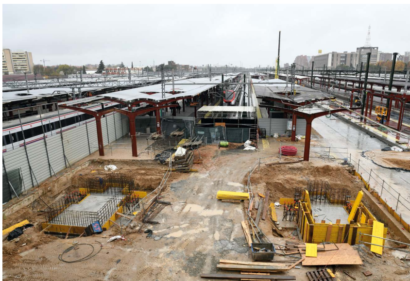
Trabajos de cimentación para ampliación del vestíbulo en los andenes de Cercanías.
