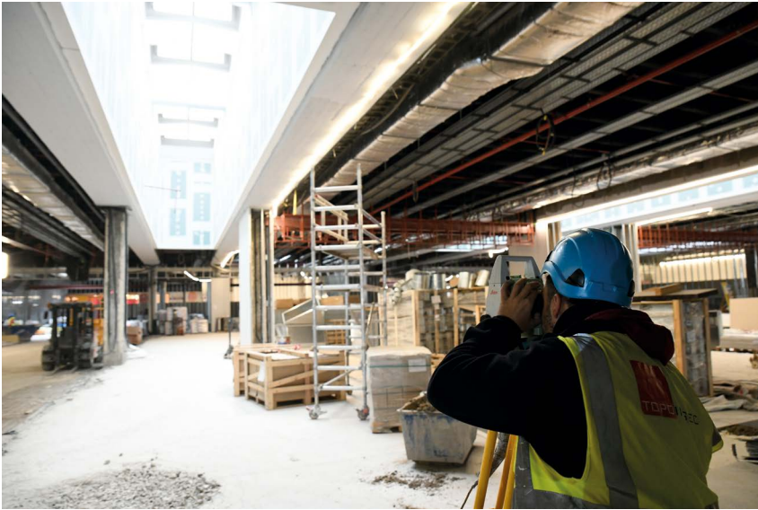
Trabajos en el interior del futuro vestíbulo de Cercanías.
