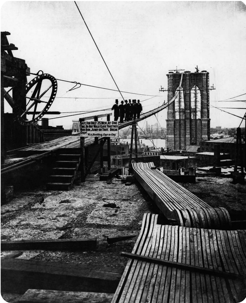
Puente de Brooklyn en construcción.
