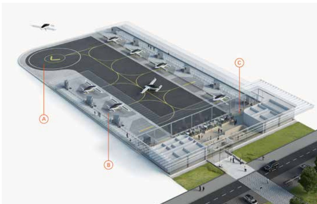
FIG. 3 / Configuración prevista de un vertipuerto. Legenda: (A) área de despegue y aterrizaje de las aeronaves VTOL (Vertical Take-Off and Landing), (B) puestos de estacionamiento de las aeronaves VTOL, (C) área terminal (de gestión de pasajeros)
