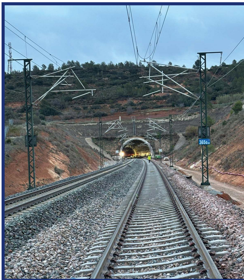
Acceso reconstruido al túnel de Chiva.
