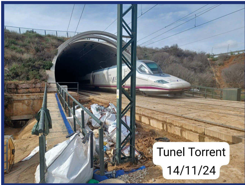
Primer tren AVE en el túnel de Torrent tras su recuperación.
