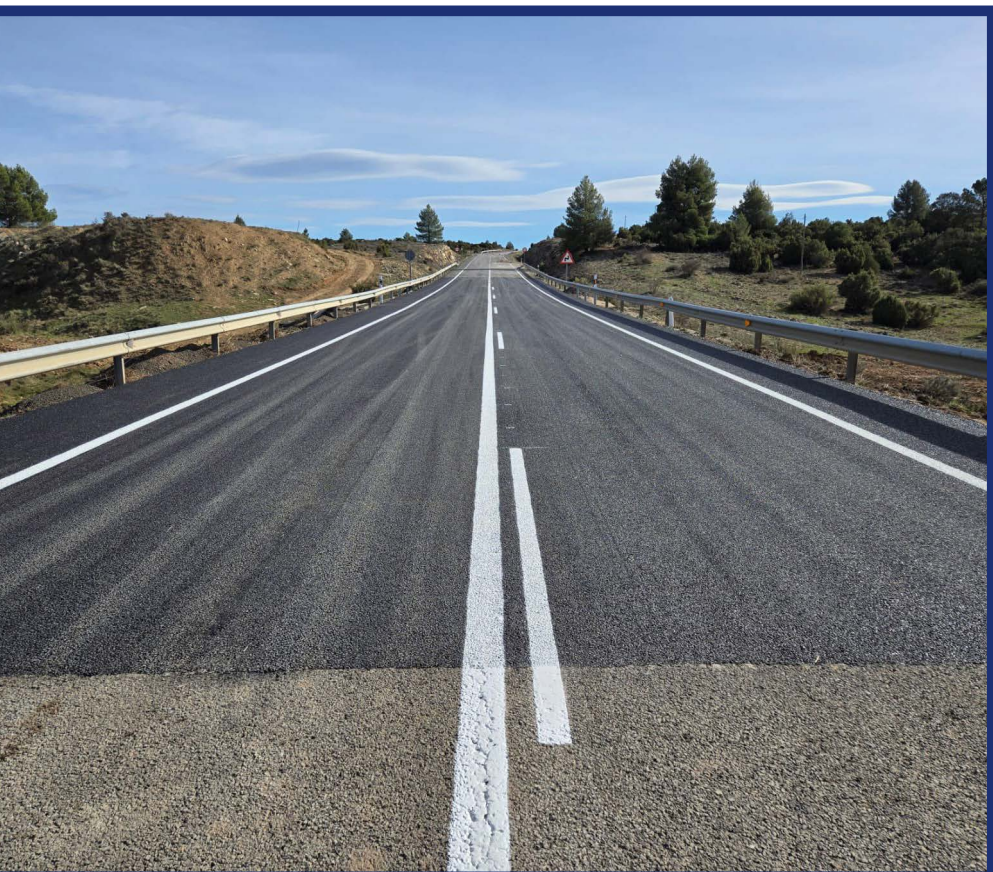
Calzada del baipás de la N-330 ya terminada.
