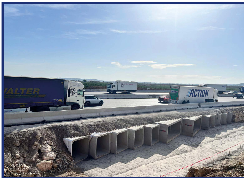
Marcos de drenaje bajo el baipás de la A-7, ya en servicio.
