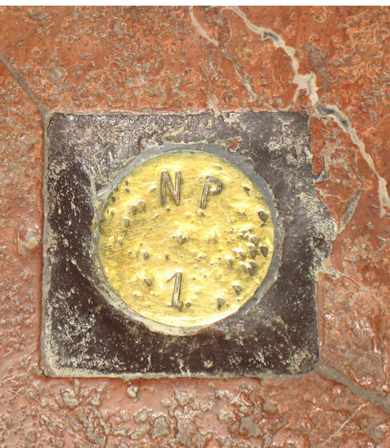
Señal NP1 en el primer escalón del Ayuntamiento de Alicante.
