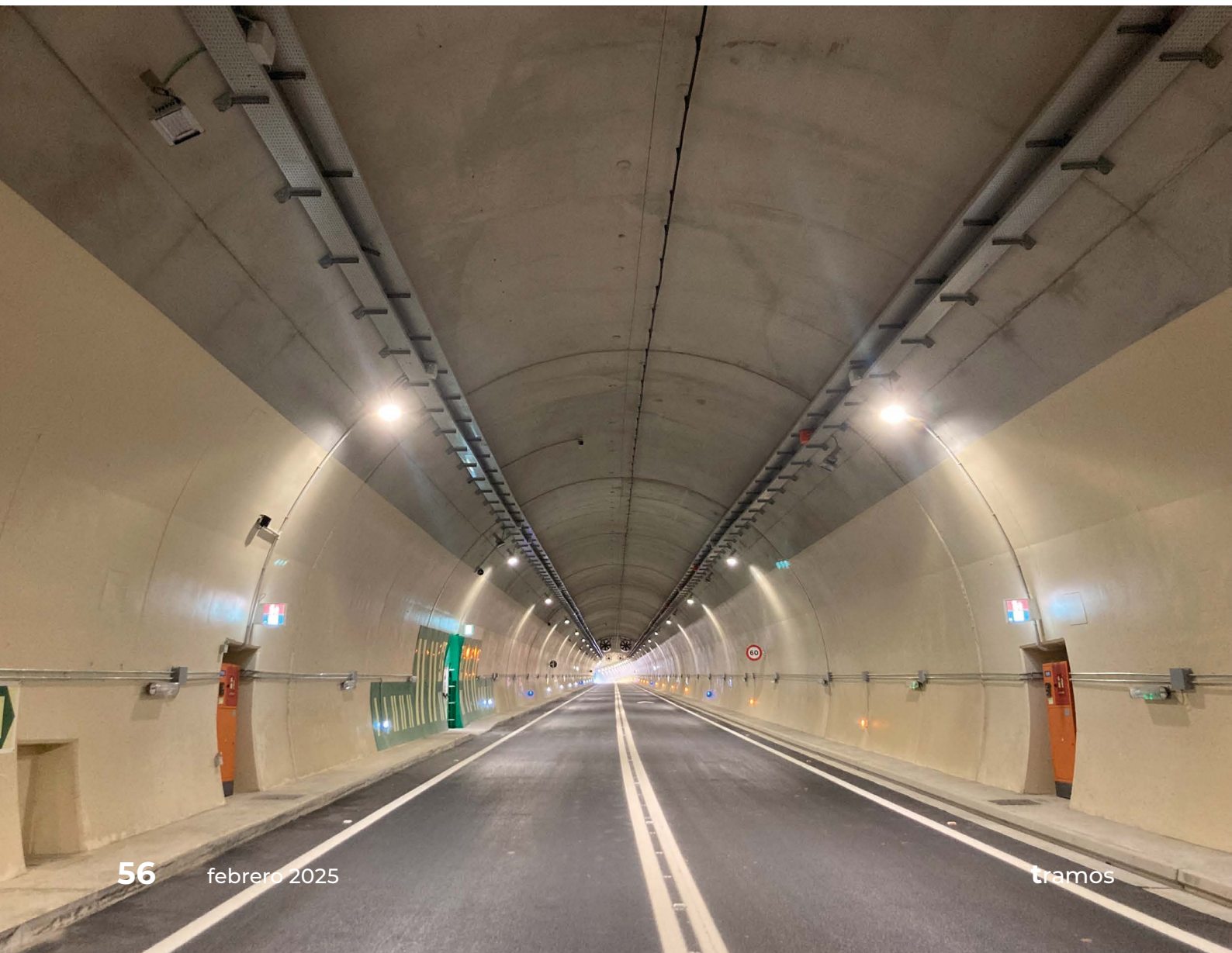
Interior del túnel de Campo 2.
