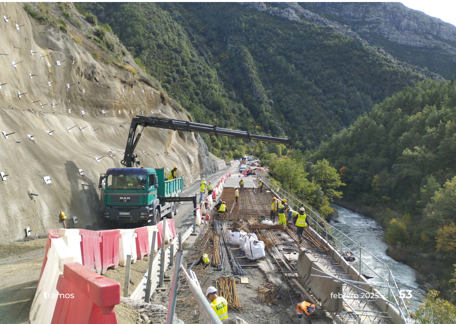
Colocación de losa prefabricada.
