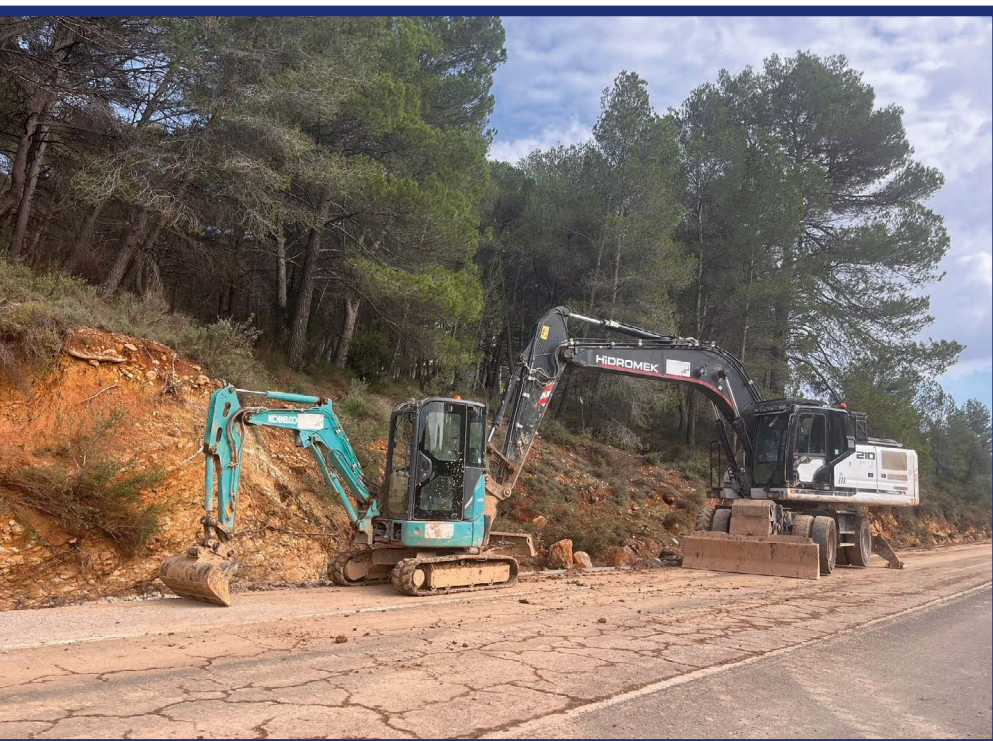
Trabajos de despeje de la carretera N-III a la altura de Siete Aguas.
