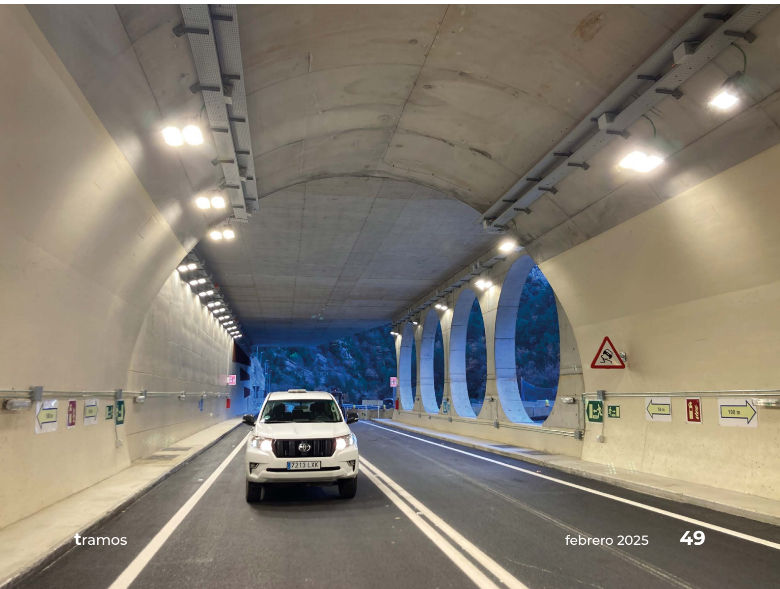
Entrada al túnel de Campo 1.
