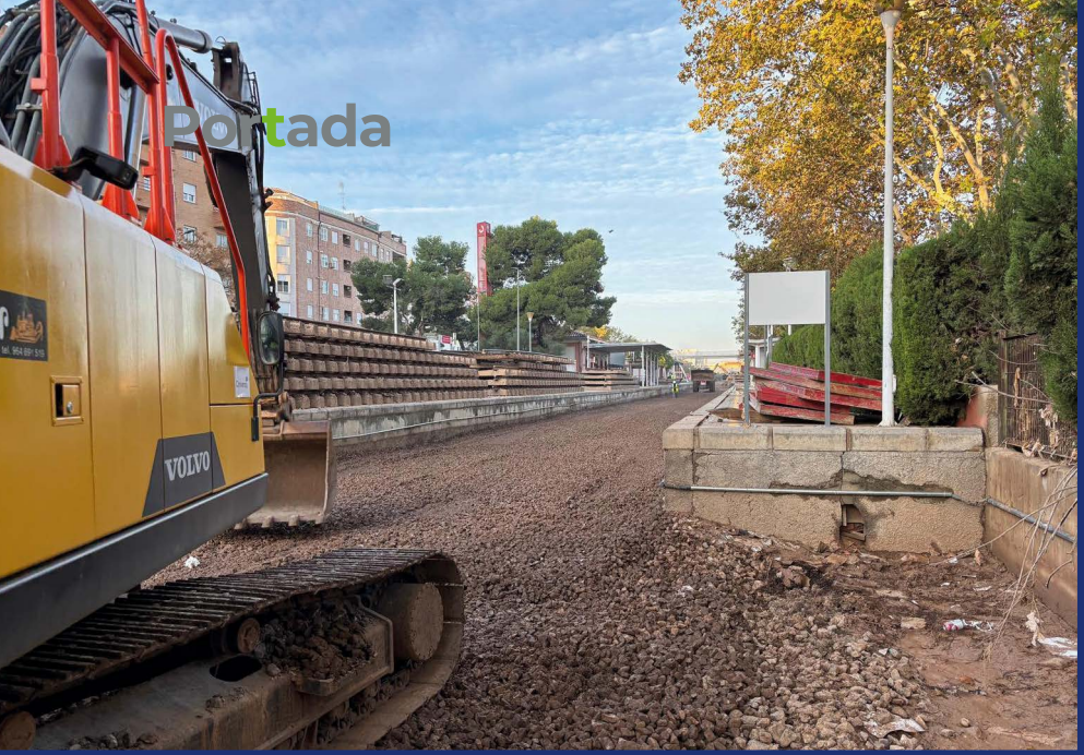
Construcción de plataforma de la estación de Aldaia, en la línea C3.
