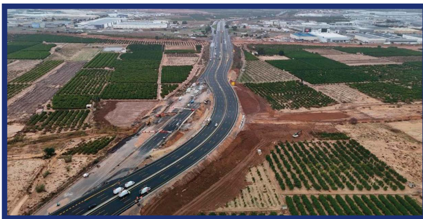
De arriba abajo, asfaltado del baipás de la A-7, demolición del viaducto colapsado y vista general del baipás.
