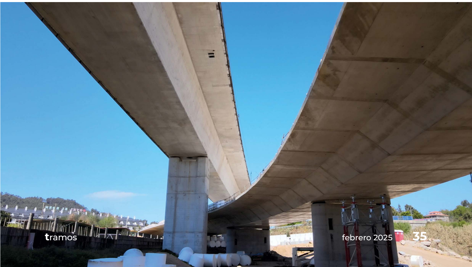
Cruce del viaducto de la A-57 bajo el ferroviario, visto desde abajo.
