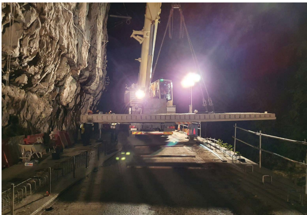
Colocación de losa prefabricada.
