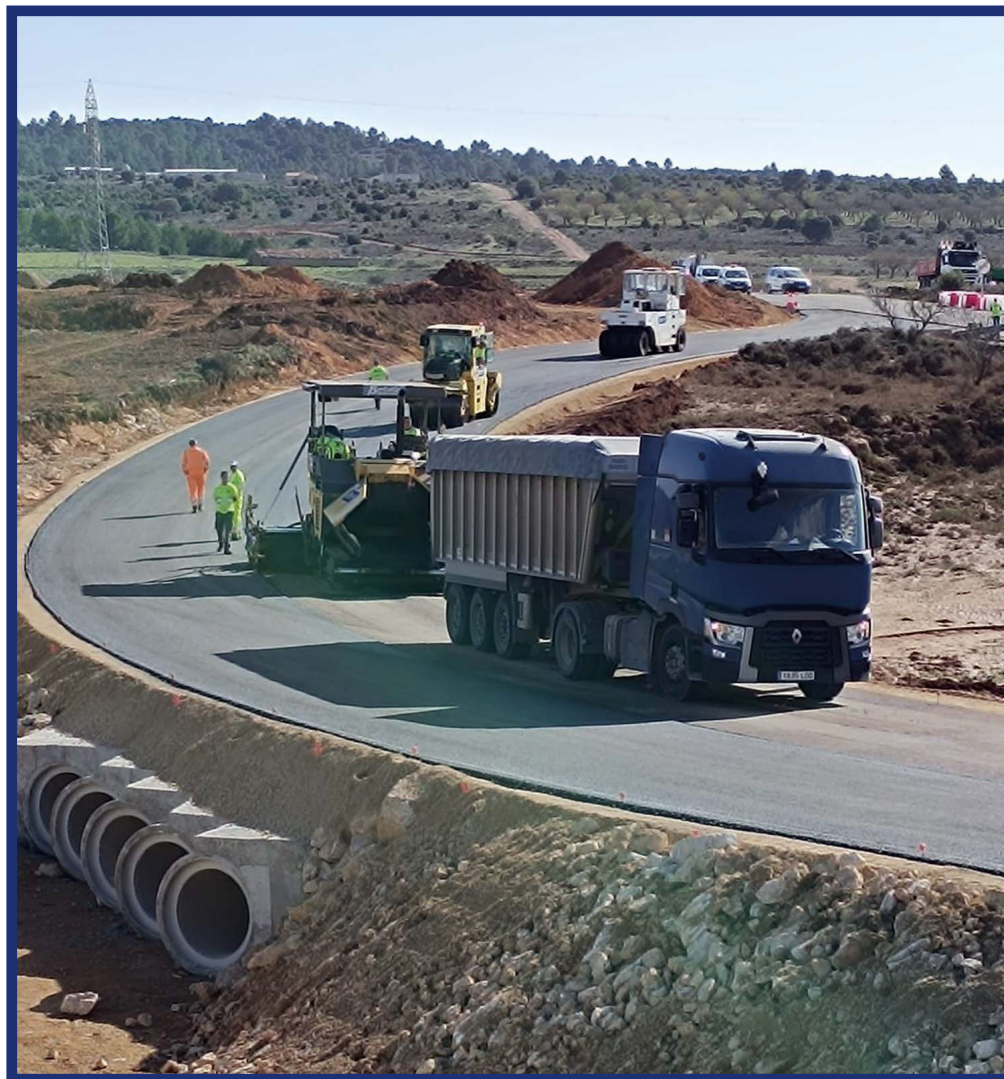
Asfaltado del baipás de la carretera N-330.
