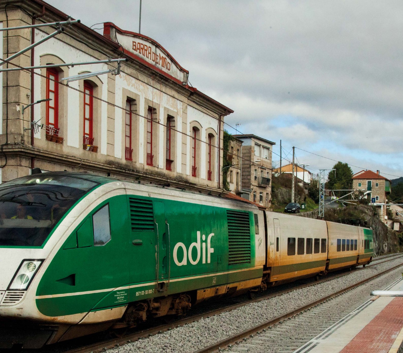
Tren laboratorio BT de Adif en la estación de Barra de Miño.
