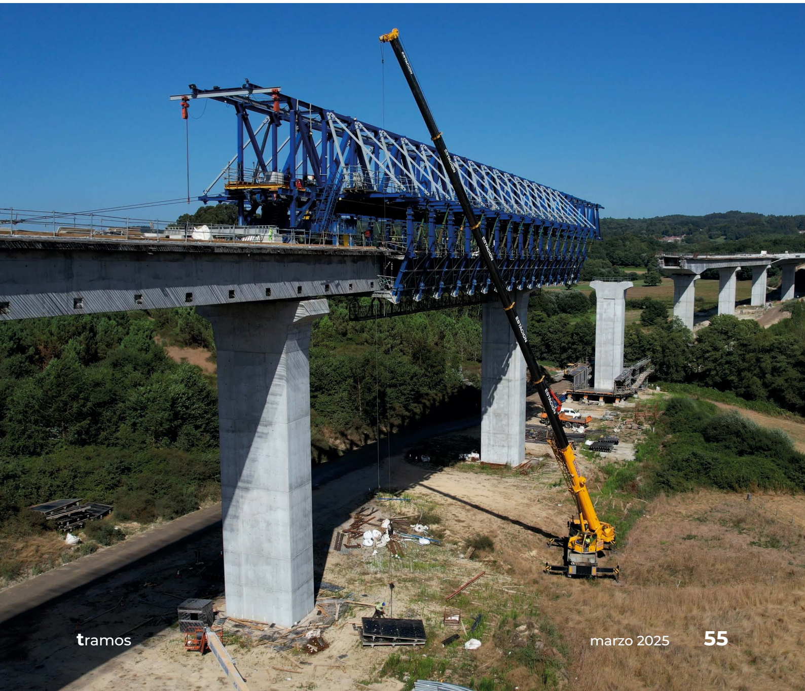
Autocimbra durante la ejecución de un vano.
