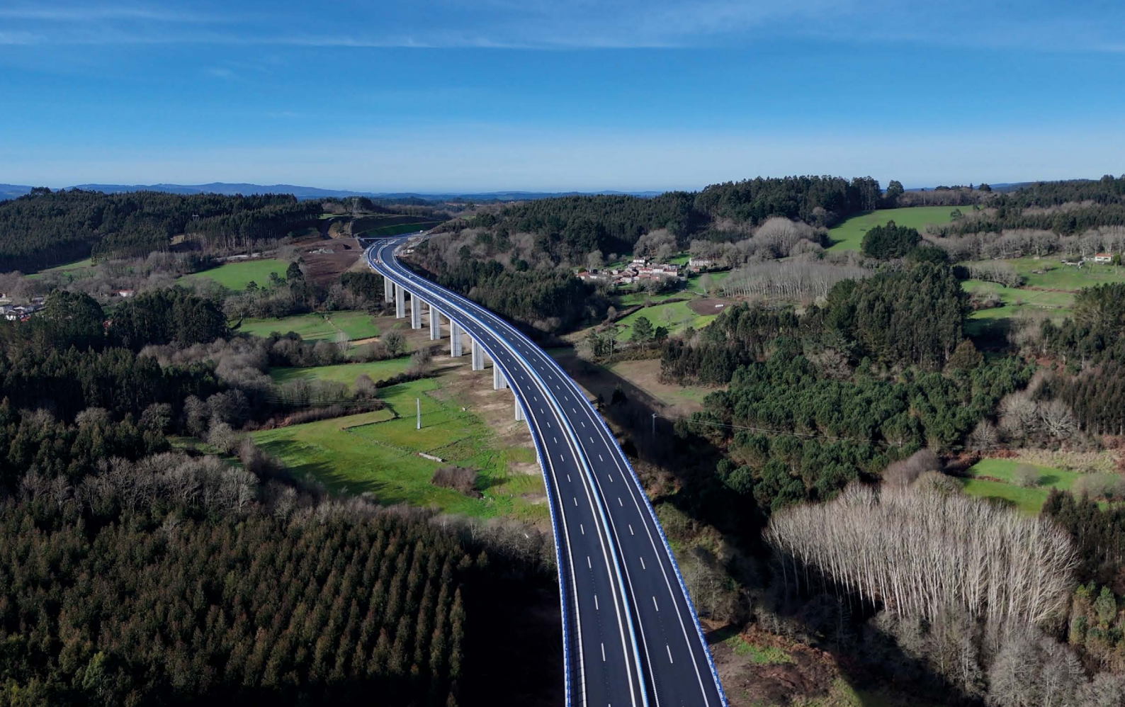
El viaducto sobre el río Pambre, a vista de dron.
