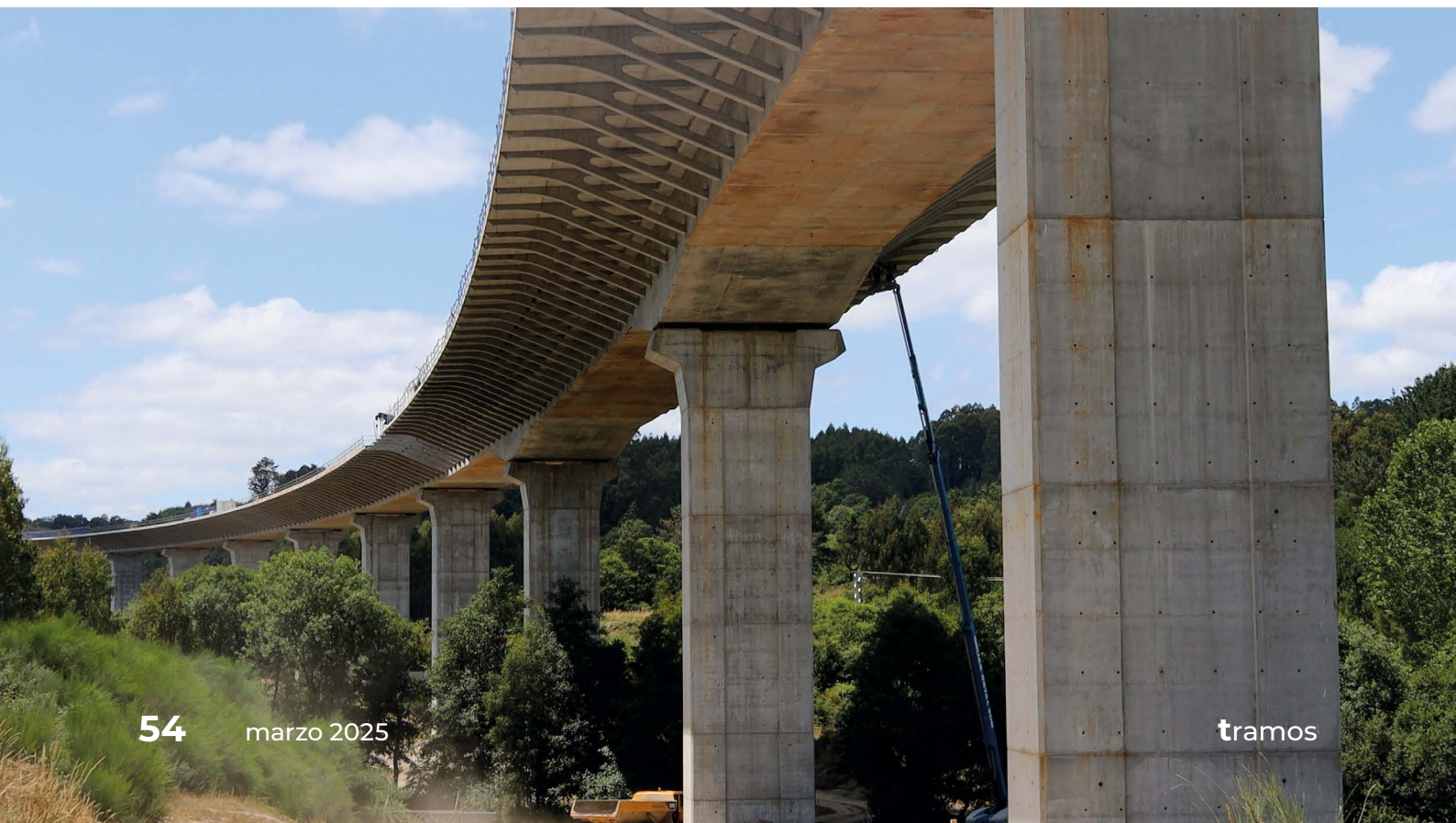
Vista inferior del viaducto de Pambre.
