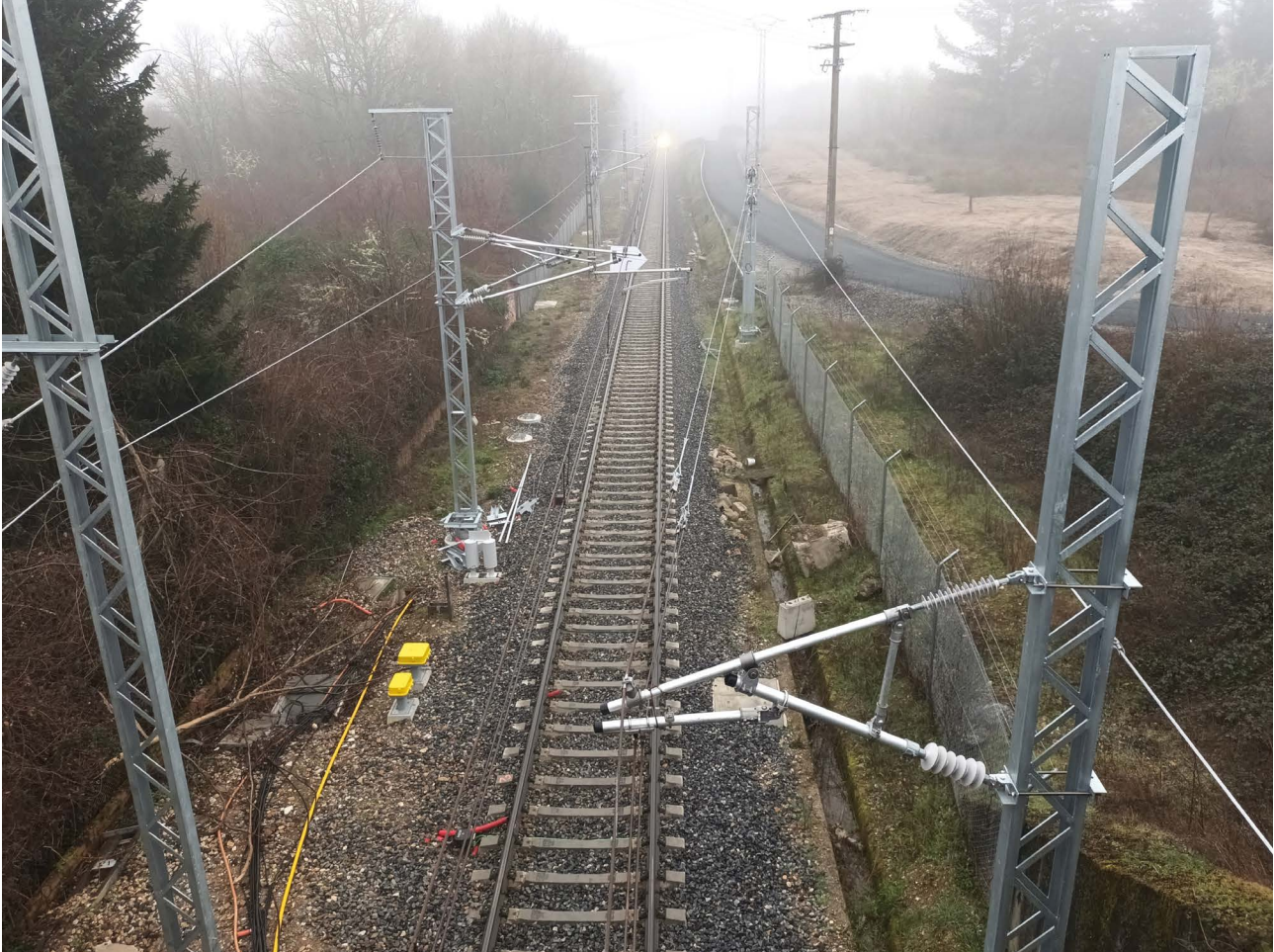
Vía única y nueva electrificación en el tramo Ourense-Monforte.
