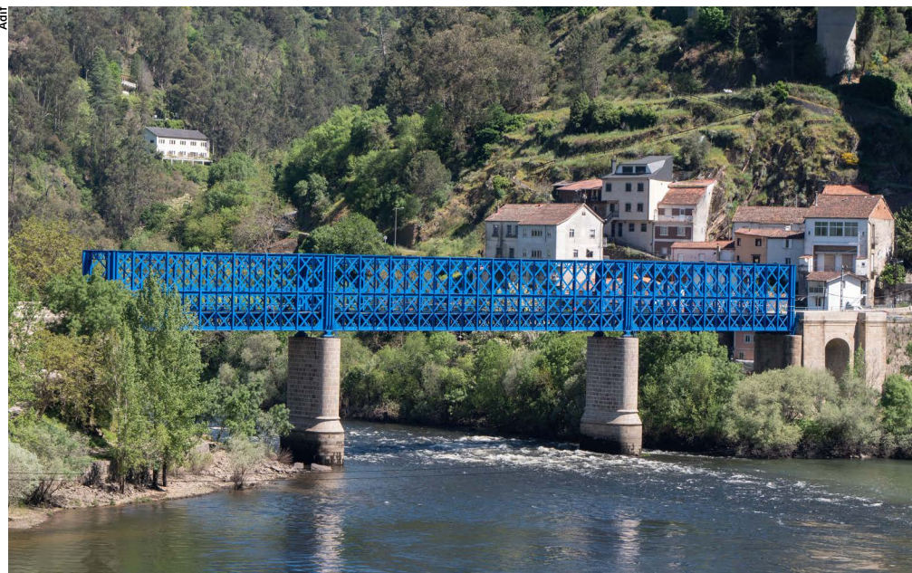
Viaducto de Os Peares sobre el río Miño.
