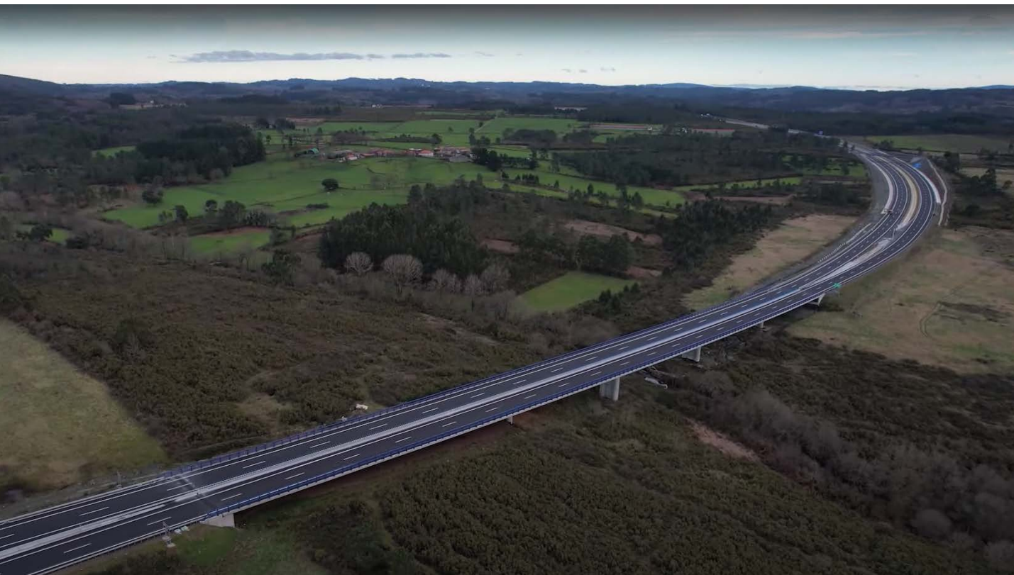
Viaducto sobre el río Seco.
