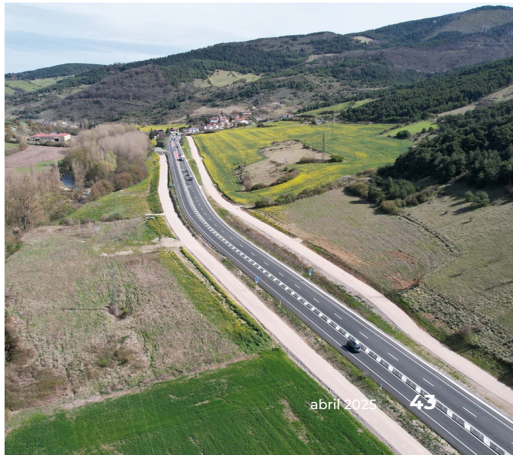
Vista del tramo I de la N-121-A entre Olabe y Soraruren, en servicio.
