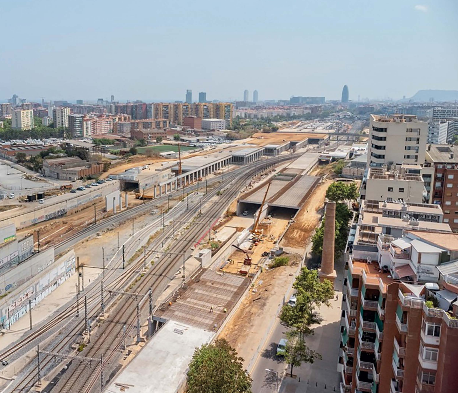
Obras de la Estación de Barcelona-La Sagrera (Cabecera Norte).
