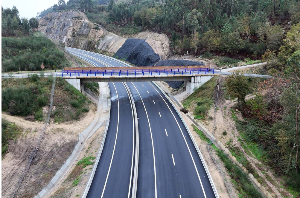
Ramal con sección 2+1 del tramo Vilaboa-A Ermida de la A-57, en Pontevedra.
