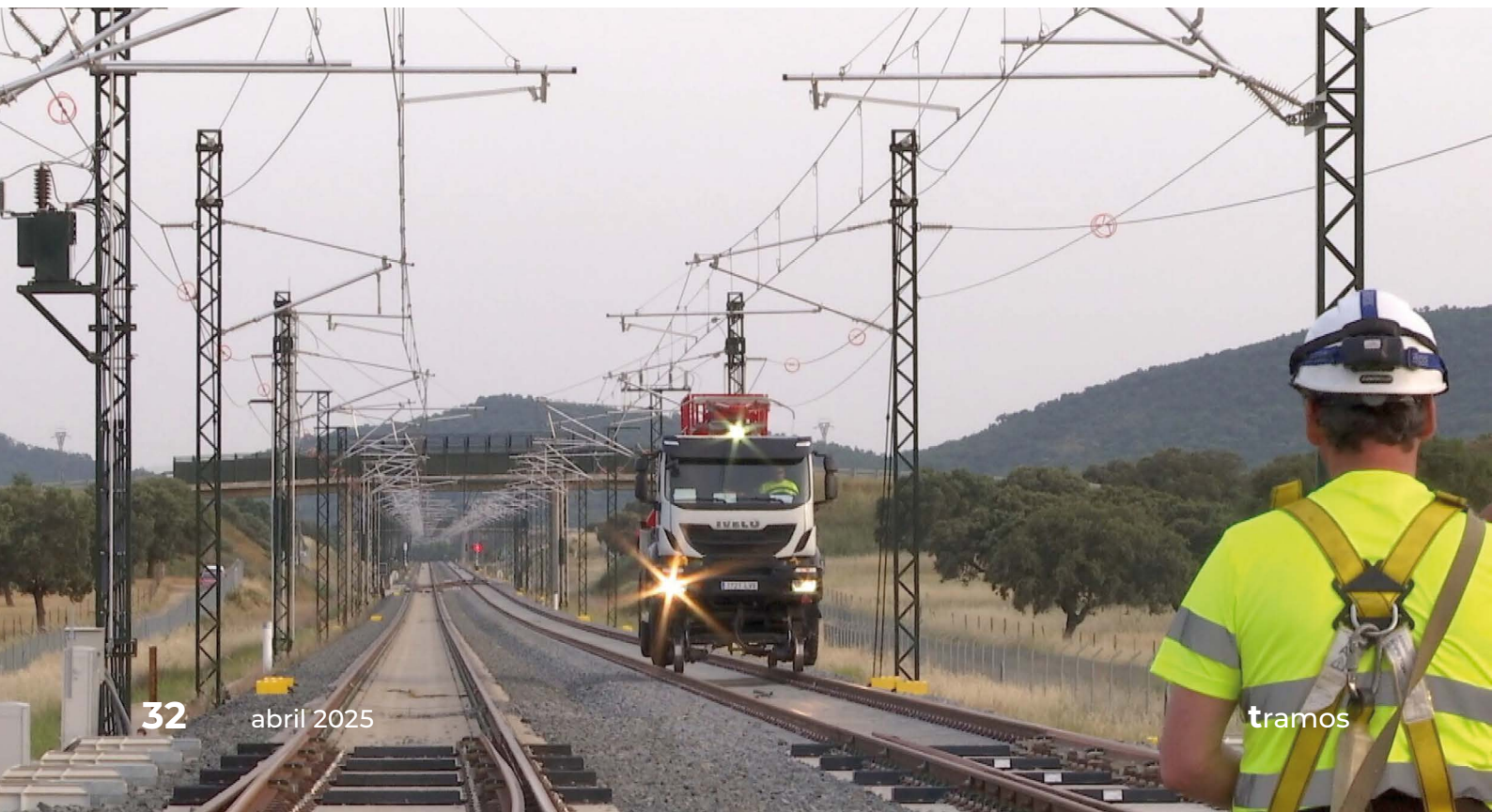
Trabajos de electrificación en la línea de Alta Velocidad Murcia-Almería.
