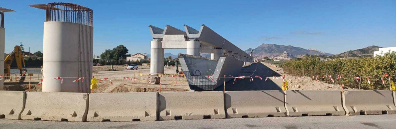
Obras de construcción del viaducto de Alhama de Murcia.
