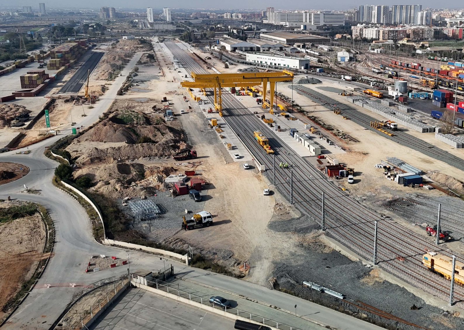
Obras de la nueva terminal intermodal de mercancías de Fuente de San Luis (Valencia).
