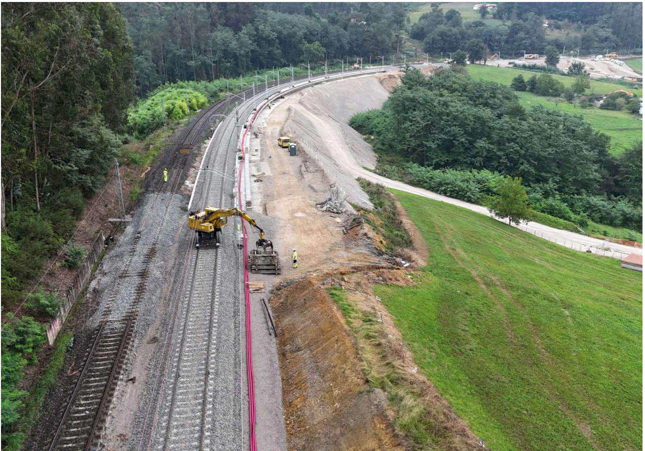
Obras de duplicación de vía entre Renedo y Guarnizo en el terraplén de Parbayón.
