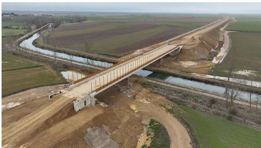
Viaducto sobre el Canal de Castilla. Tramo Amusco-Osorno.
