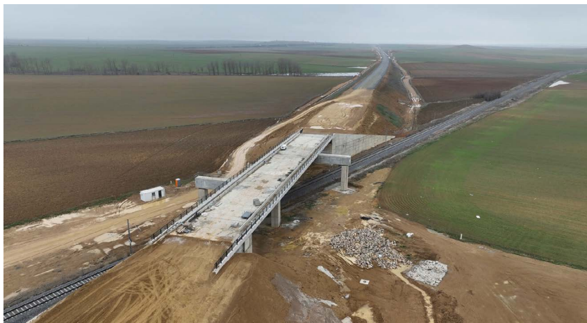
Estructura sobre la línea de ferrocarril Palencia-Santander. Tramo Amusco-Osorno.
