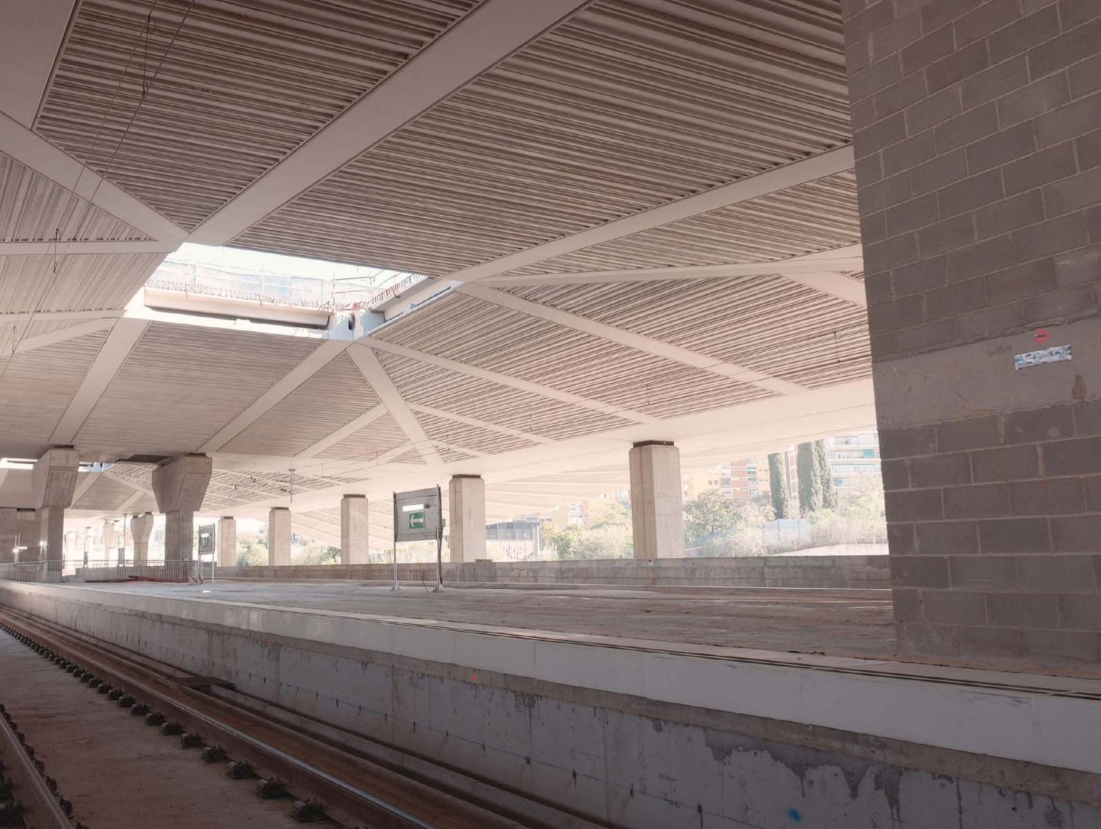
Los lucernarios de la cubierta iluminan el interior de la estación con luz natural.
