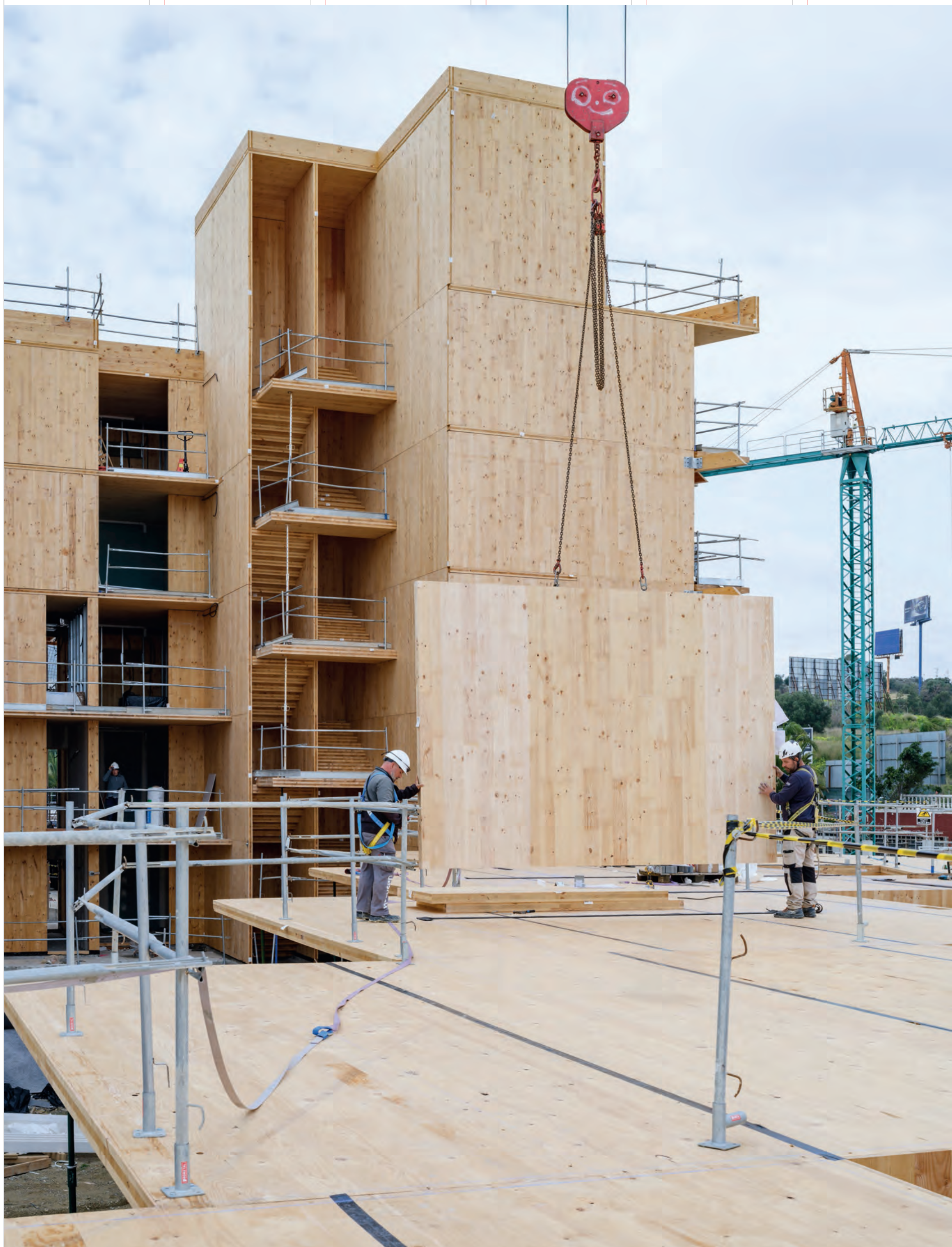
Edificio de apartamentos "coliving" Oceanika en Torremolinos (Málaga). En construcción. Bakpak architects. Foto: María Azkárate / Apartment building "coliving" Oceanika in Torremolinos (Málaga). Under construction. Bakpak architects. Photo: María Azkárate
