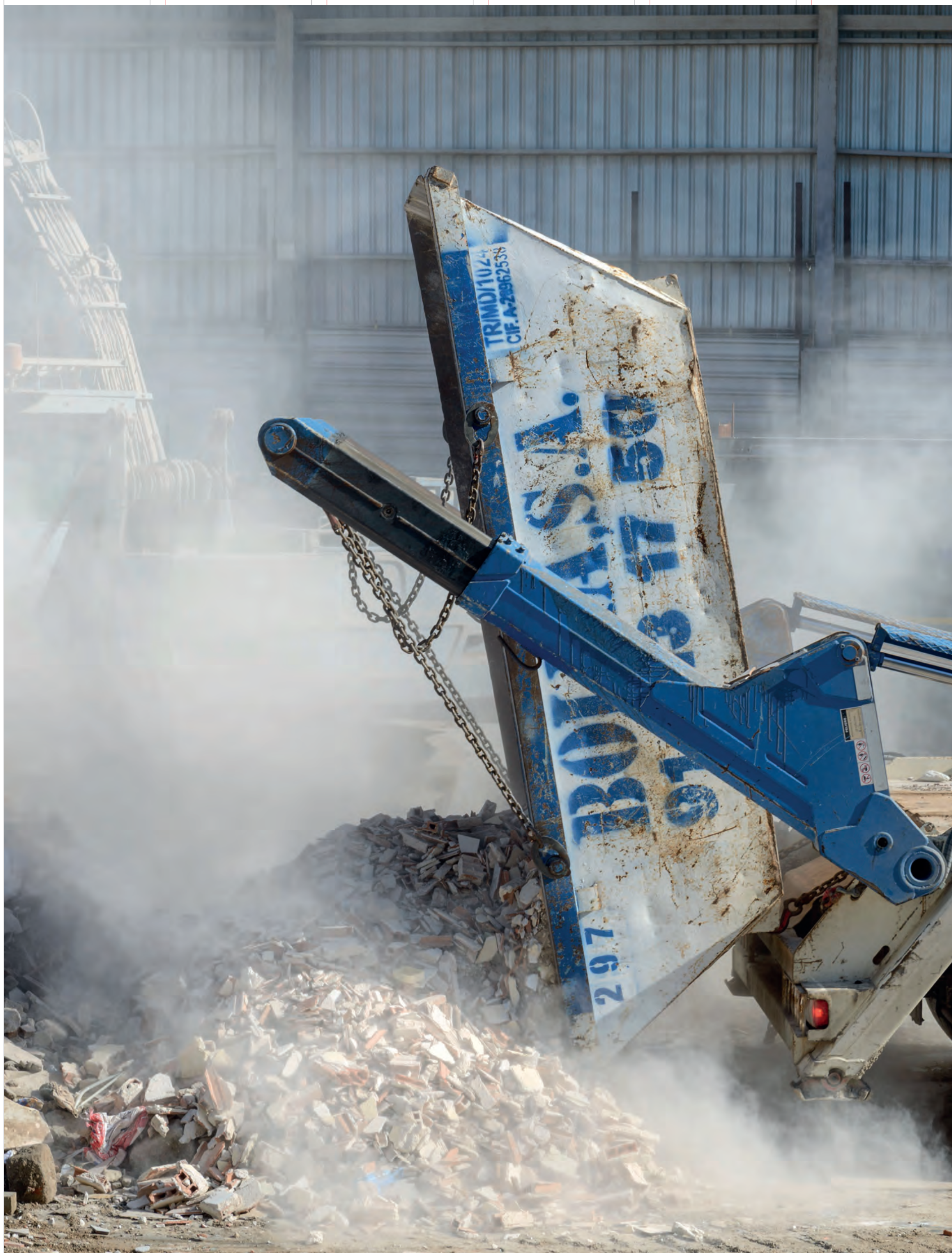
Recepción y volcado de contenedores de residuos mezclados de construcción y demolición (RCD). Foto: Ana Amado / Reception and dumping of mixed construction and demolition waste (CDW) containers. Photo: Ana Amado
