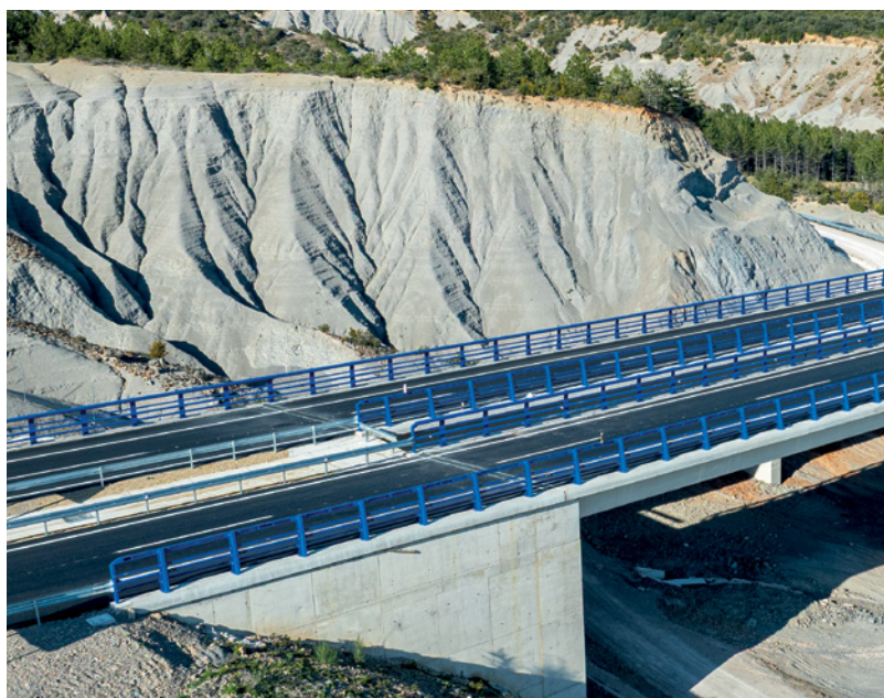
Viaducto de Las Tejas.
