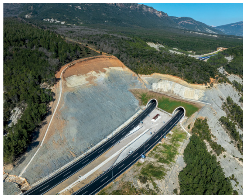
Desmonte junto a la boca del túnel de Menazos.
