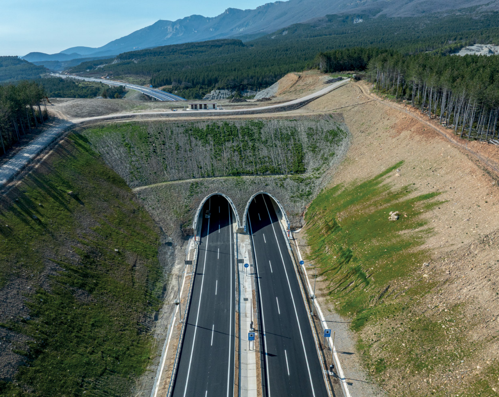
Boca del falso túnel de San Martín.
