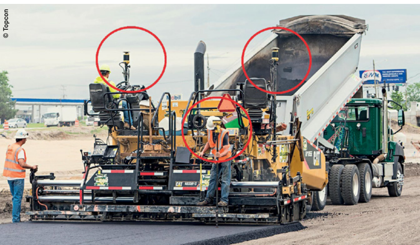
Asfaltado con sensores GNSS.
