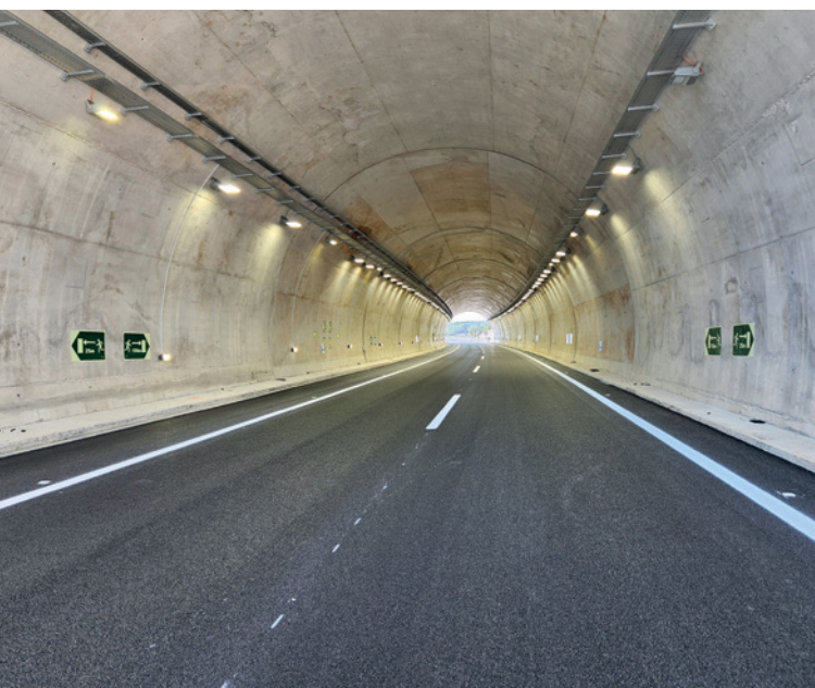
Interior del túnel de Menazos.
