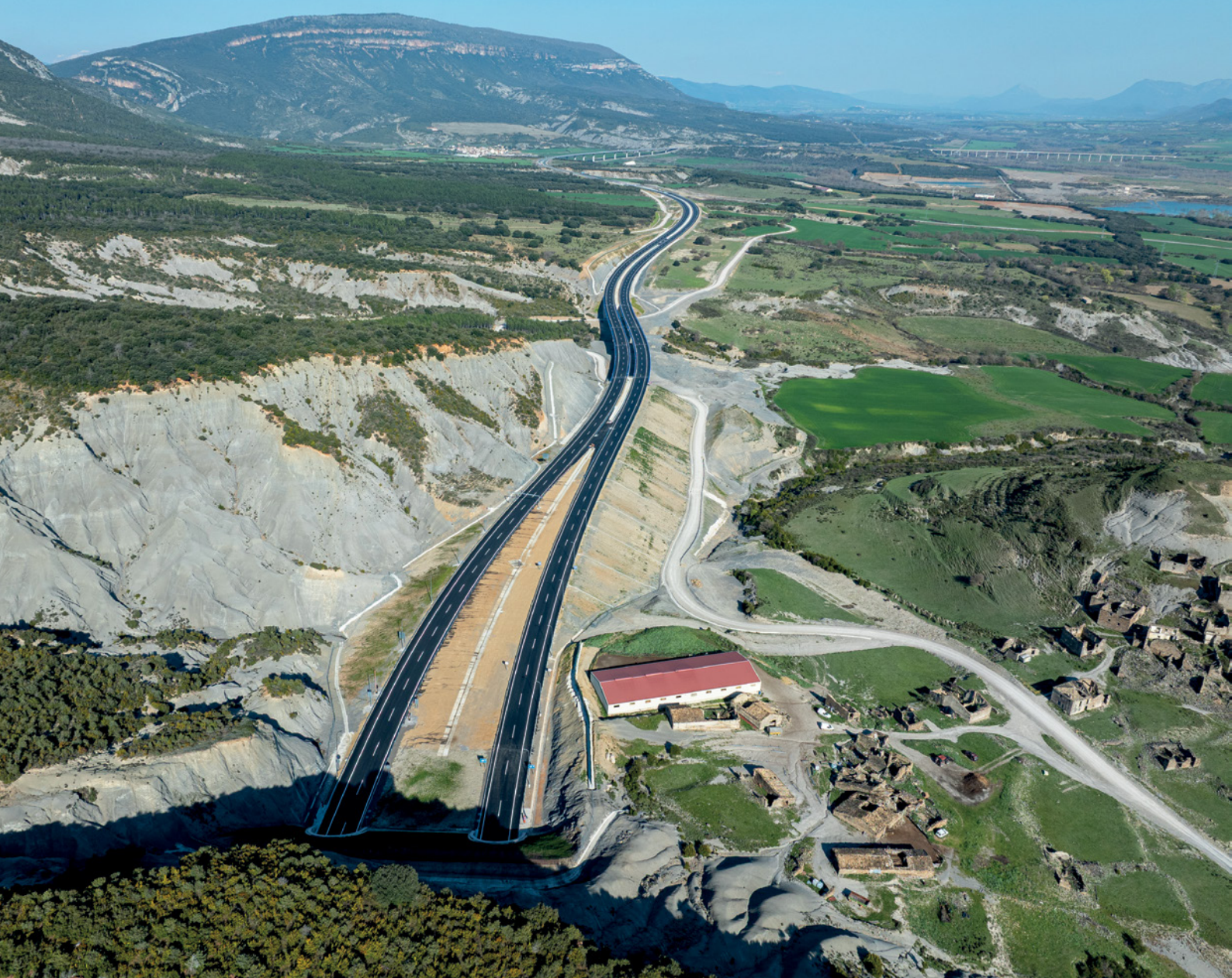
Vista del tramo en sentido este desde el túnel de Esco.
