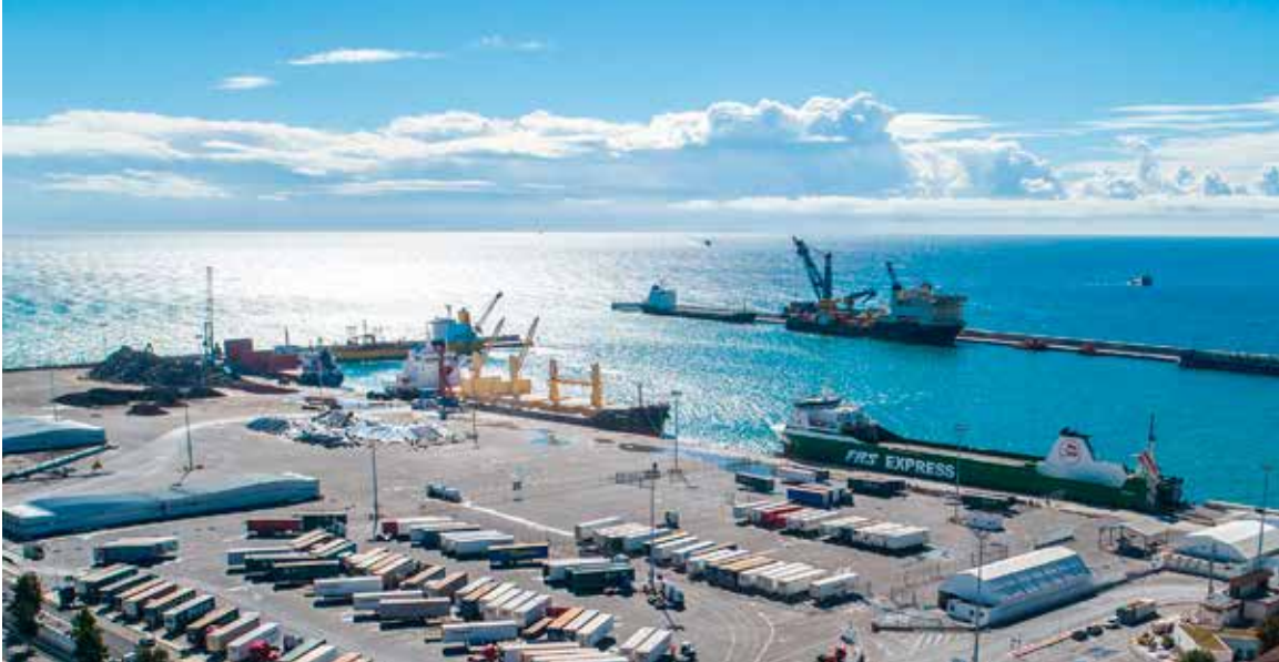
Muelle de la Azucenas, Puerto de Motril.
