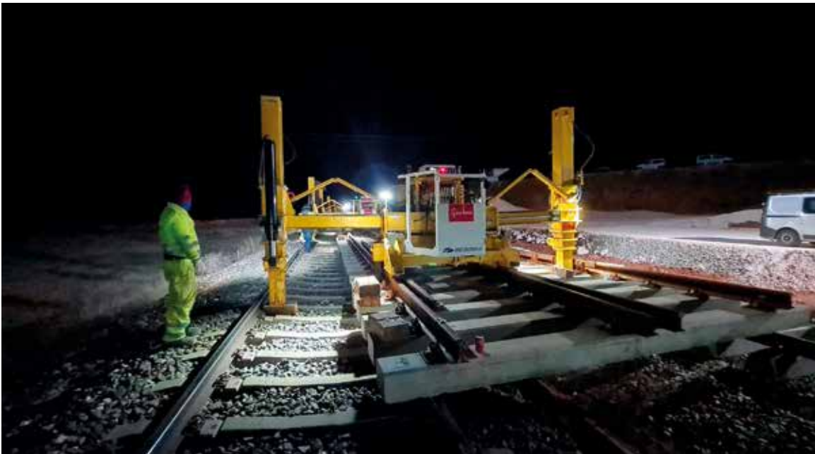
Renovación de vía en la línea Sagunto-Teruel-Zaragoza.
