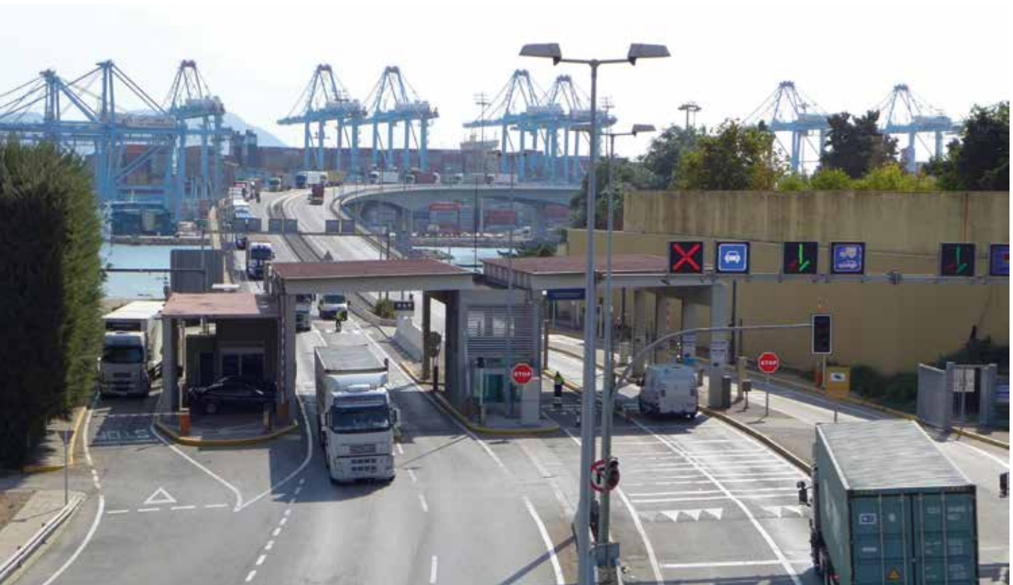
Acceso viario norte al Puerto Bahía de Algeciras.
