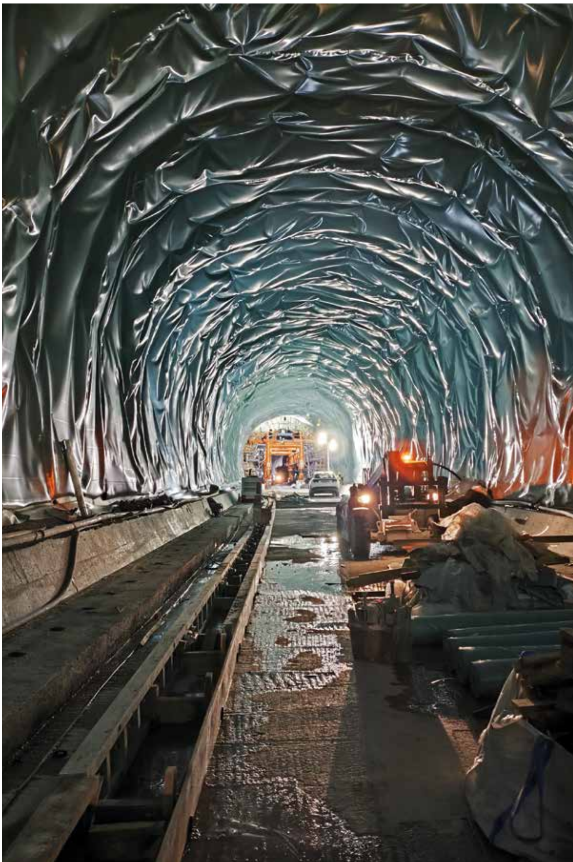
Revestimiento de uno de los túneles del acceso al Puerto Exterior de A Coruña.
