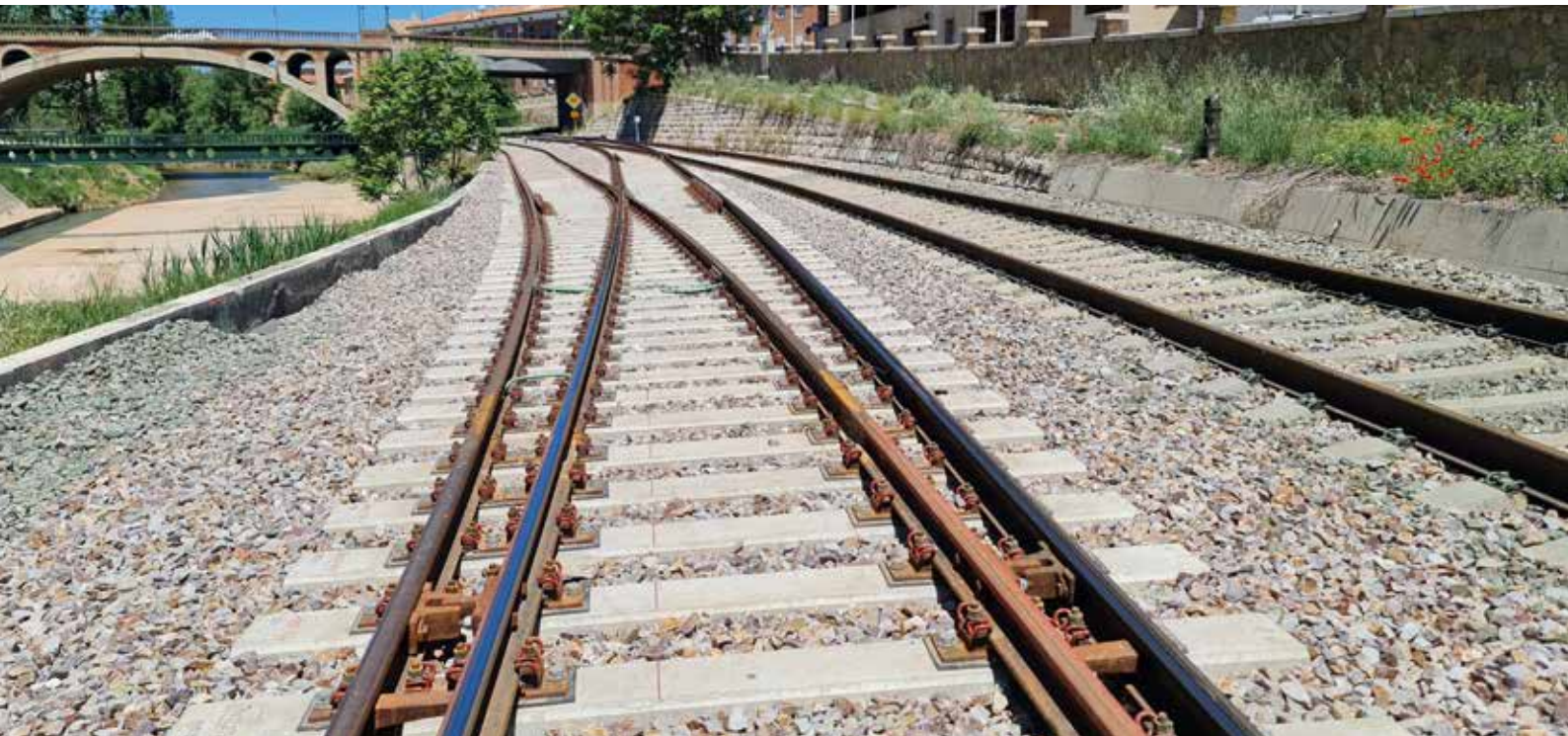
Apartadero para trenes de 750 metros en Teruel, línea Sagunto-Zaragoza.
