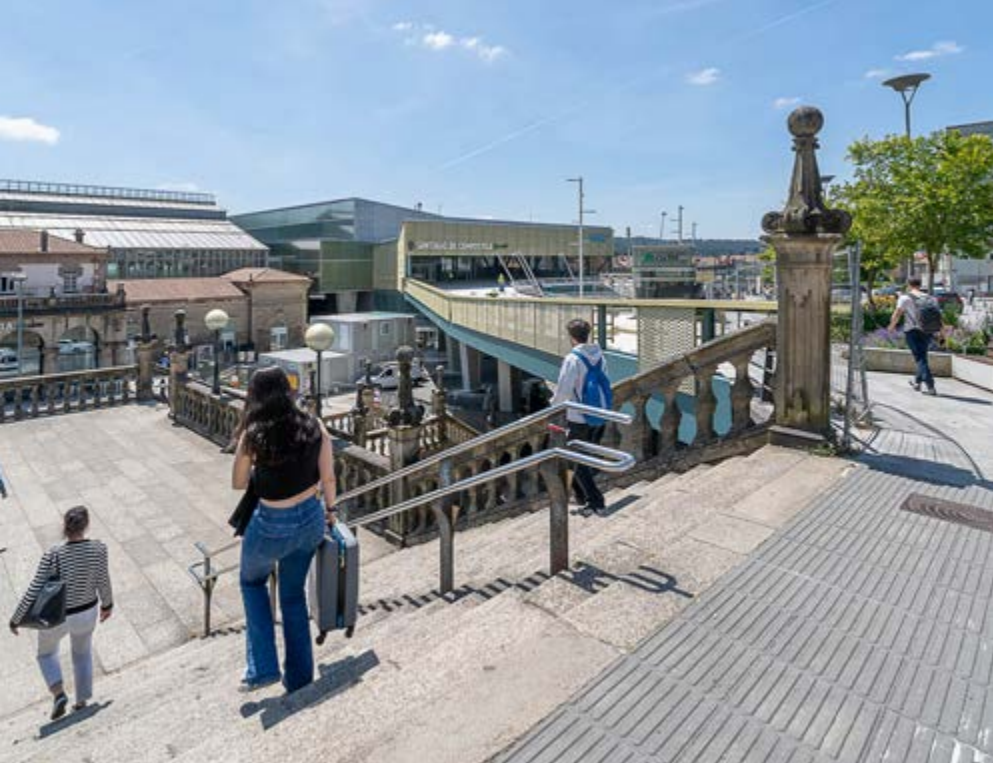
La escalera de acceso a la estación ha perdido su funcionalidad con el nuevo edificio, situado a cota de la calle.
