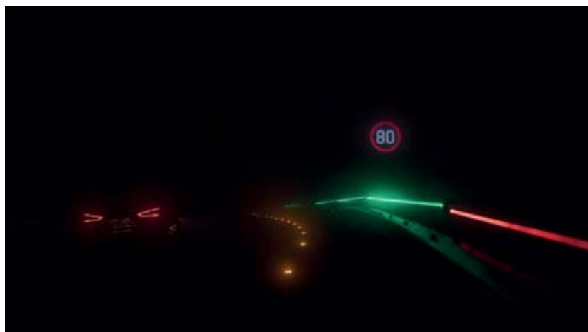
Balizamiento lateral de la vía con luz láser en la autovía A-8.
