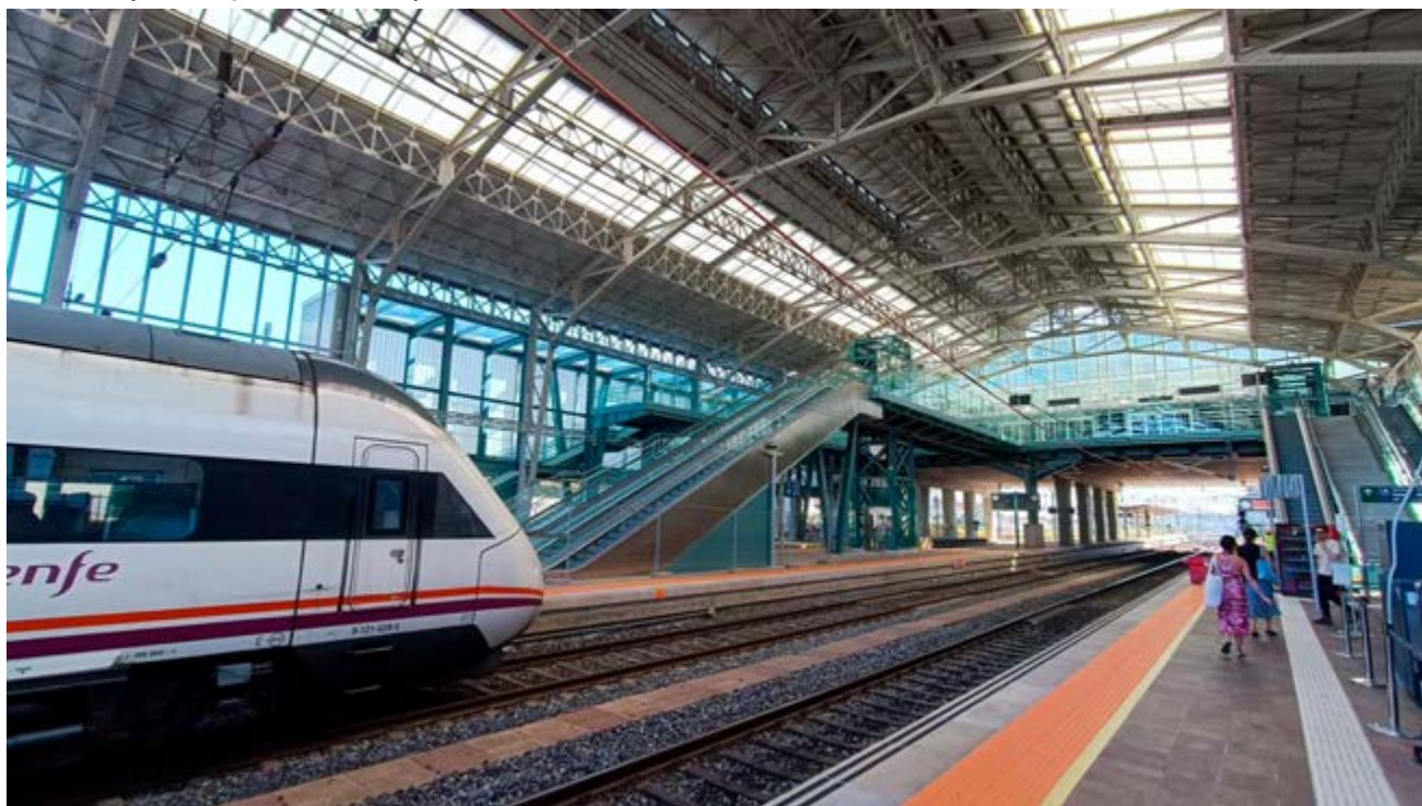
Andenes bajo la marquesina histórica y conexiones verticales con el nuevo edificio.
