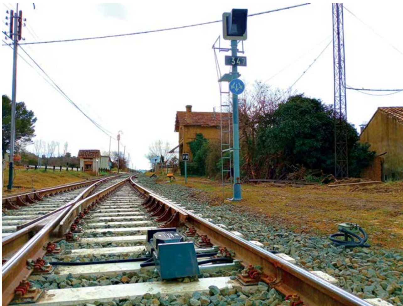
Instalaciones de señalización y vía en el subtramo Plasencia del Monte-Ayerbe.
