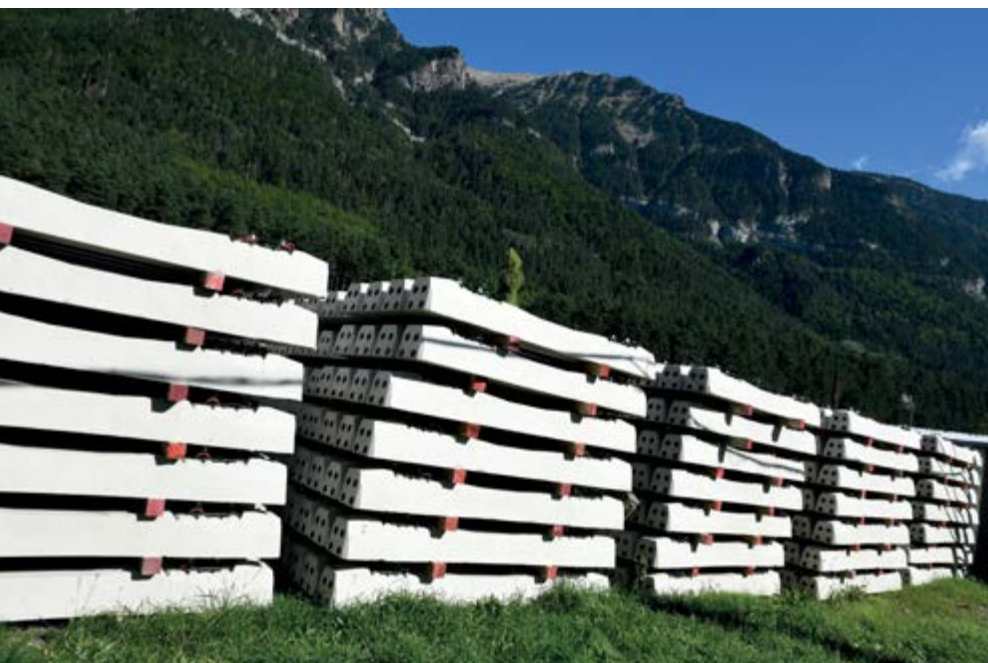
Traviesas polivalentes a la espera de montaje.
