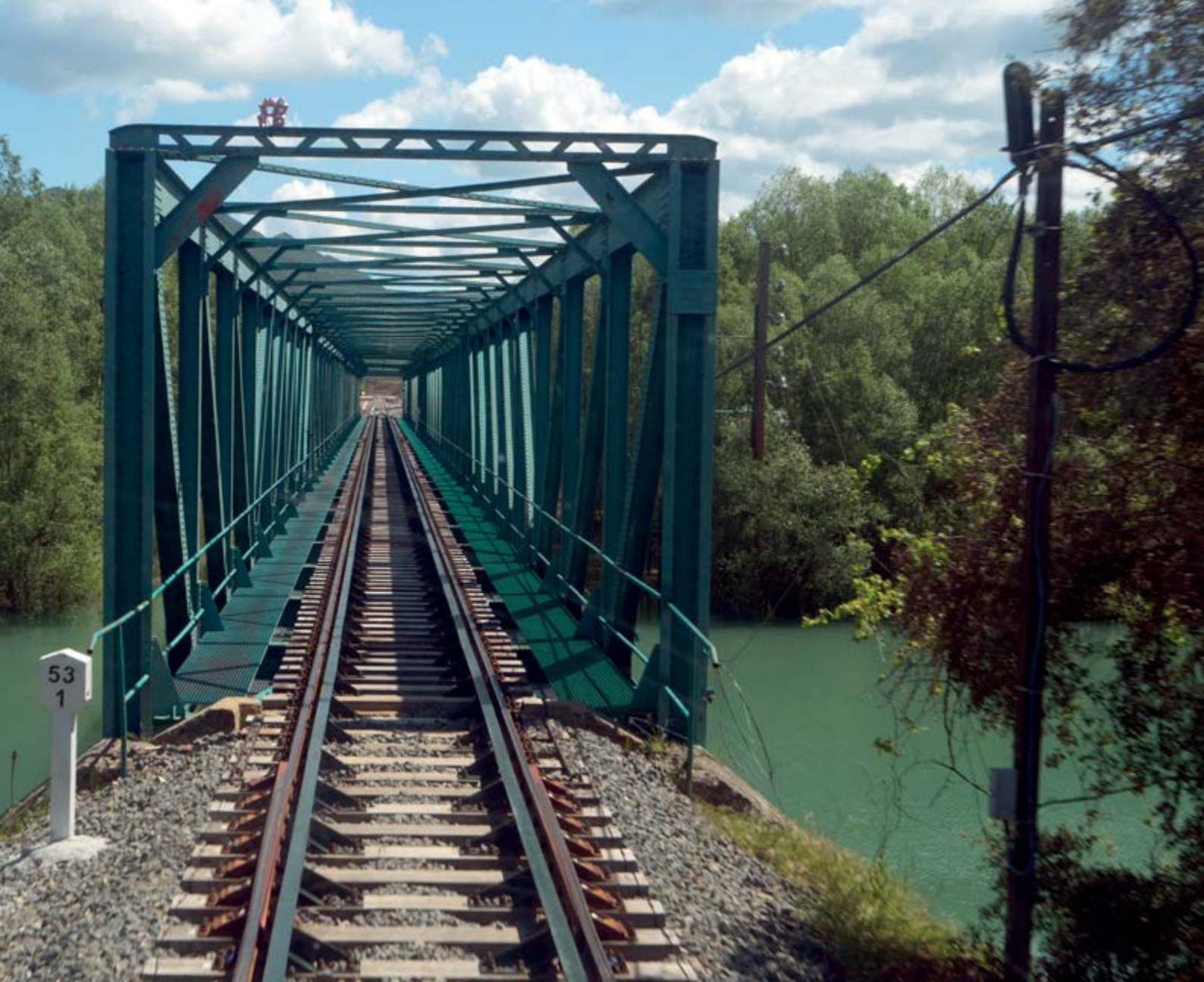
Puente metálico sobre el río Gállego.
