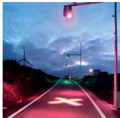
Sistema de señalización horizontal inteligente con tecnología LED proyectada sobre la calzada en la autovía A-8.
