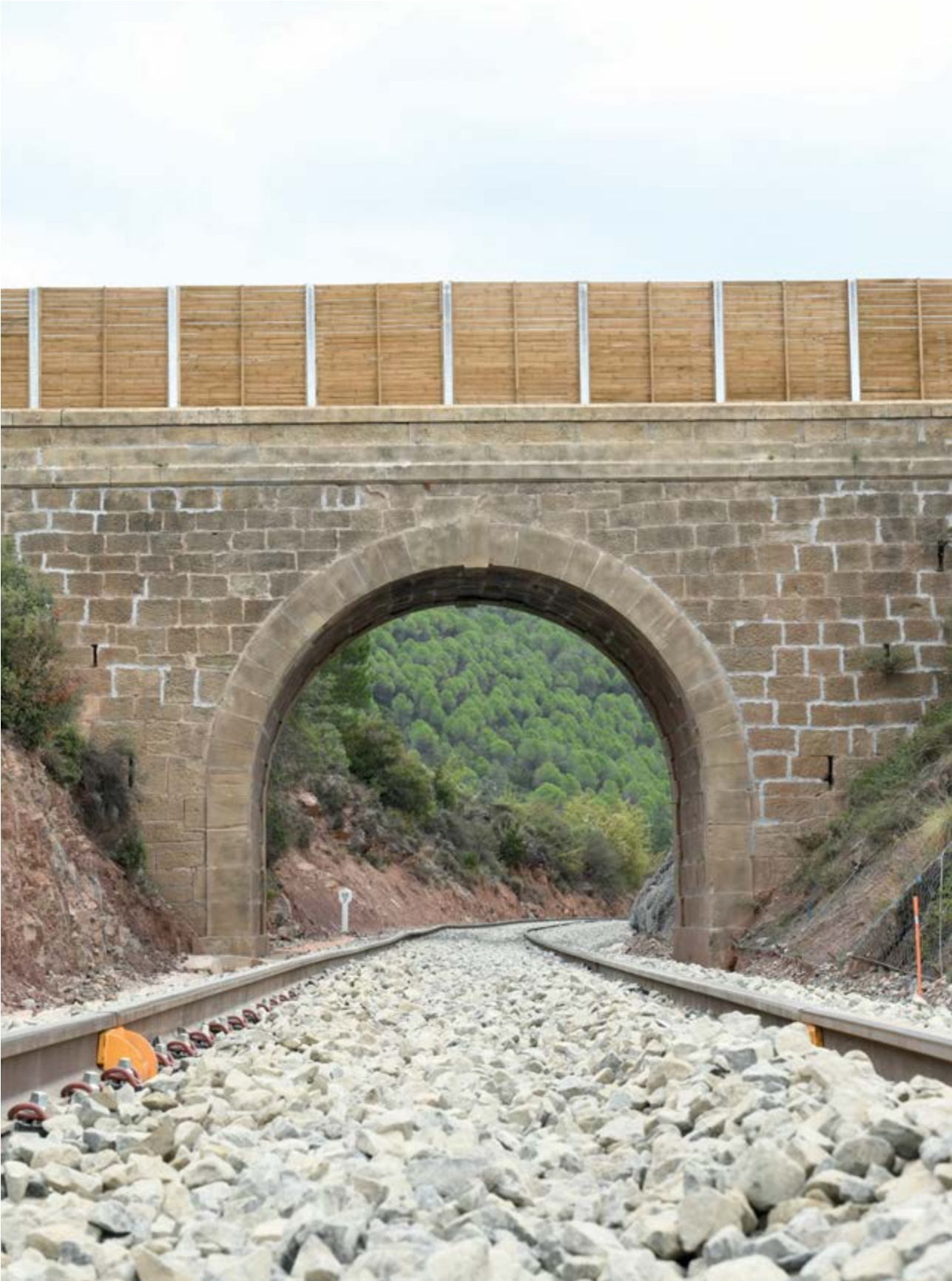
Paso superior reforzado en el entorno de Riglos.
