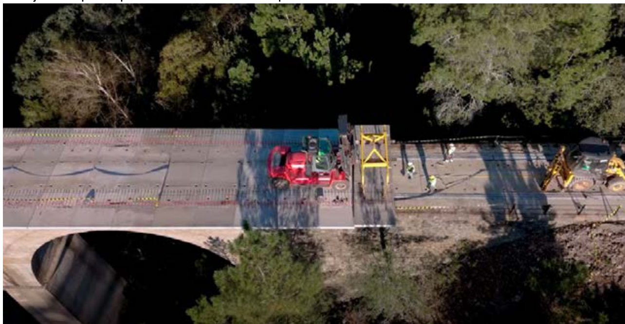
Montaje de losa para ampliar la anchura del tablero de un puente.
