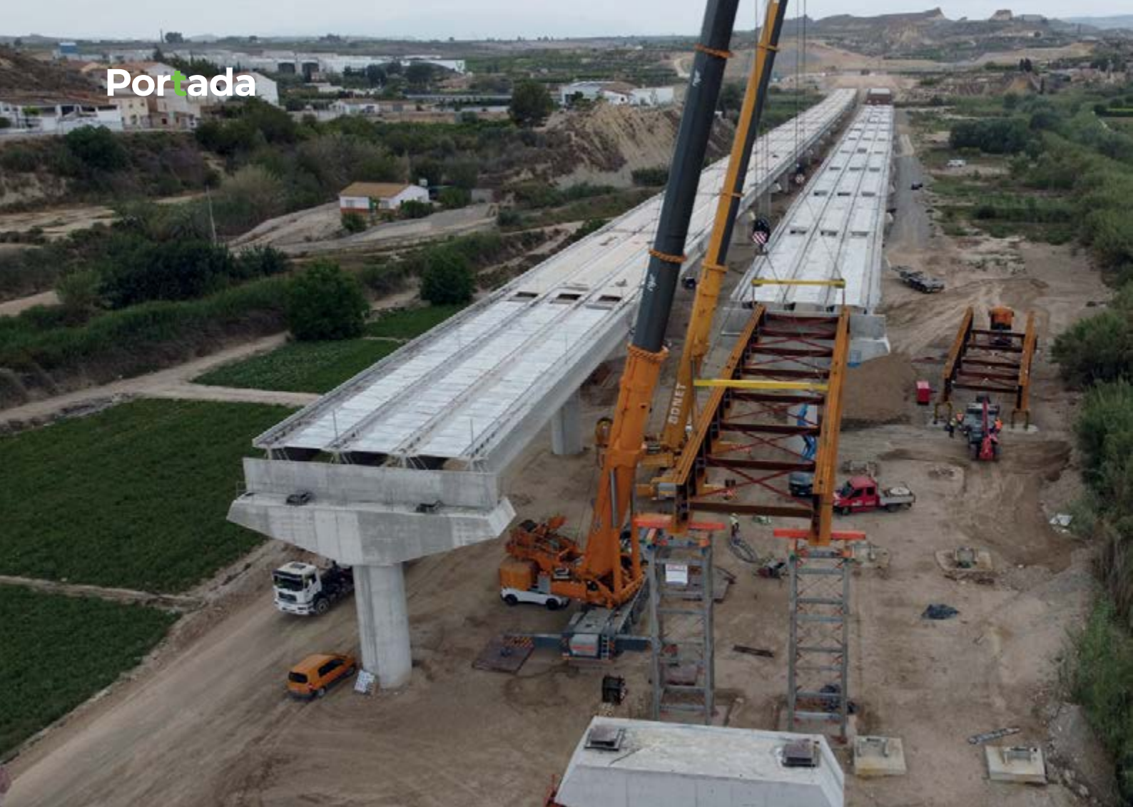
Montaje de viga metálica en el viaducto sobre el río Segura, cuyos tableros lucen las prelosas ya montadas.
