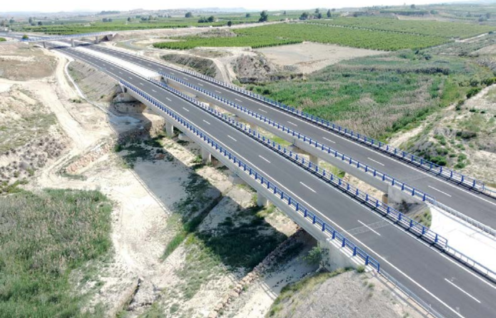
Estructura E3 del tramo B.
