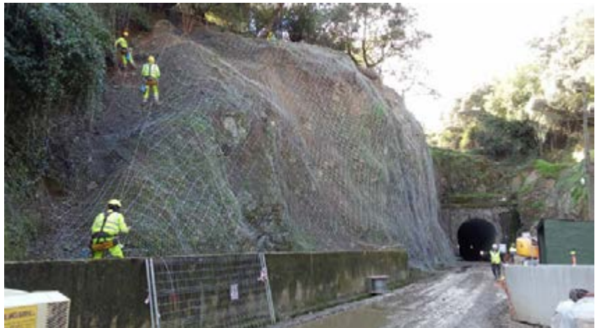
Sostenimiento de un talud en el tramo más septentrional.
