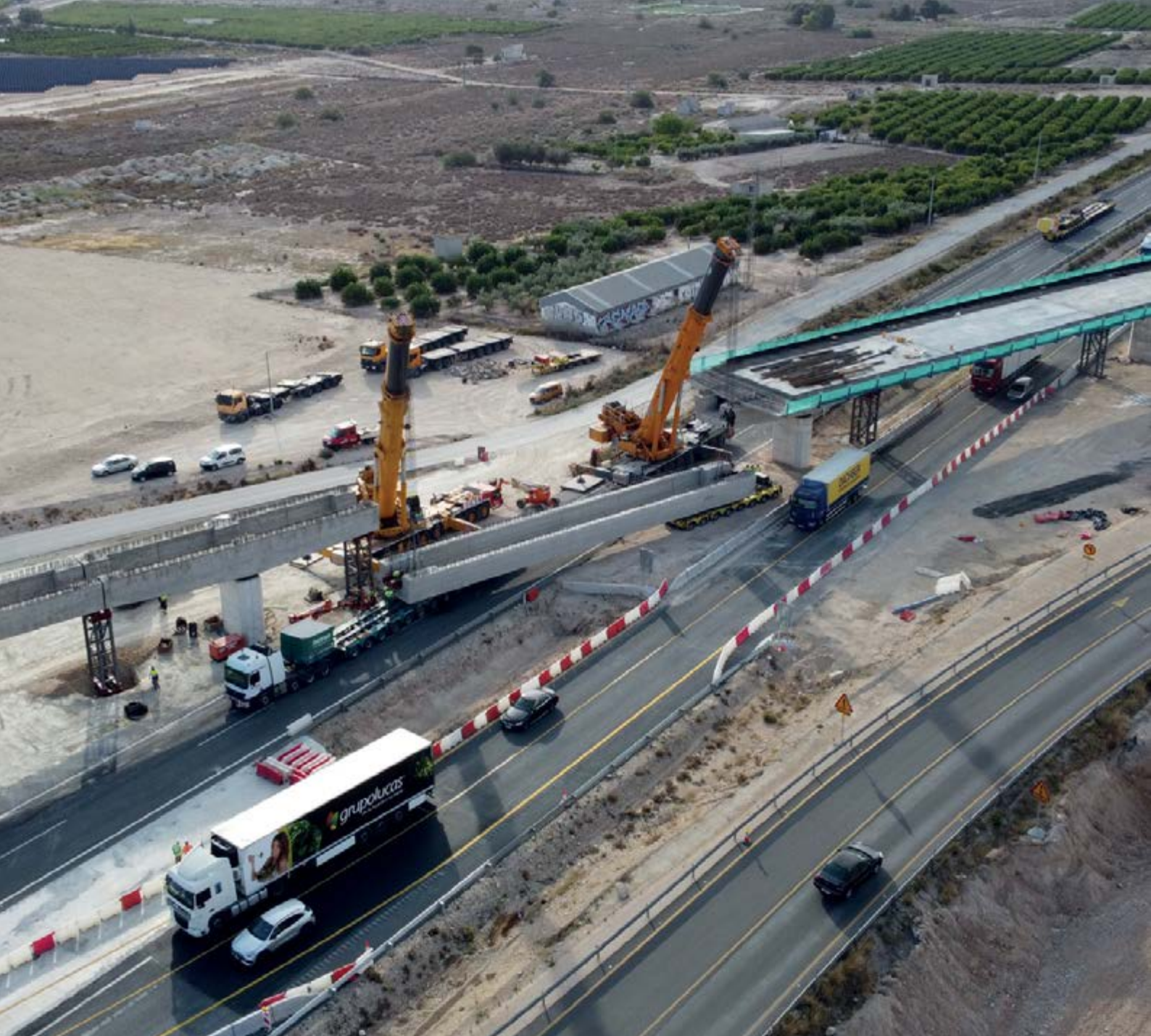
Montaje de viga de hormigón en el viaducto sobre la A-30, en el origen del Arco Noroeste.
