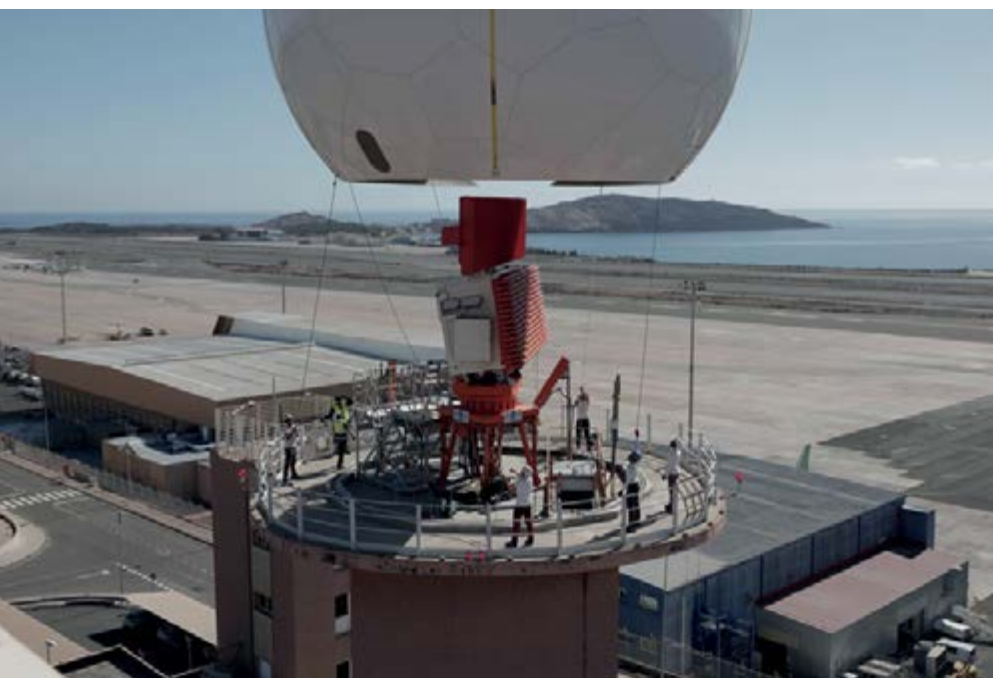
Colocación del radomo que protege el radar.
