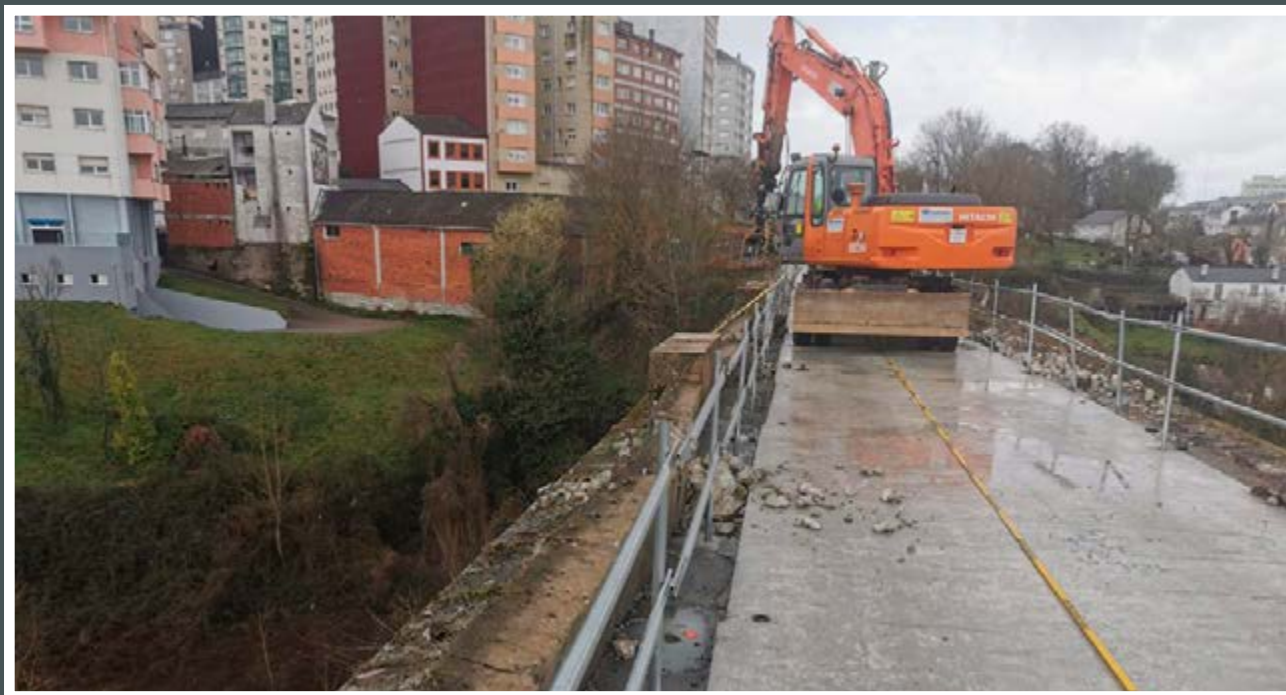
Durante la restauración integral se ha reforzado la fábrica de sillares de piedra.
