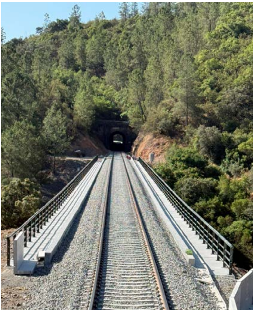
Vía renovada sobre un puente en la sierra de Aracena.
