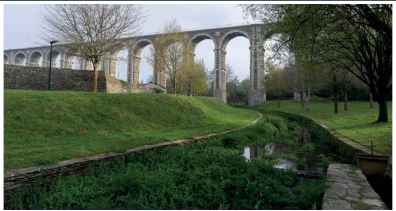
Vista del puente de A Chanca tras la restauración integral.
