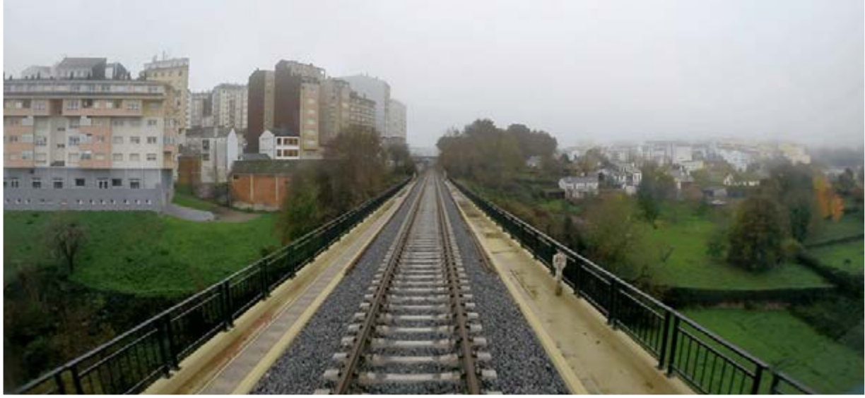
La vía ha sido completamente renovada con el tendido de nuevos elementos.
