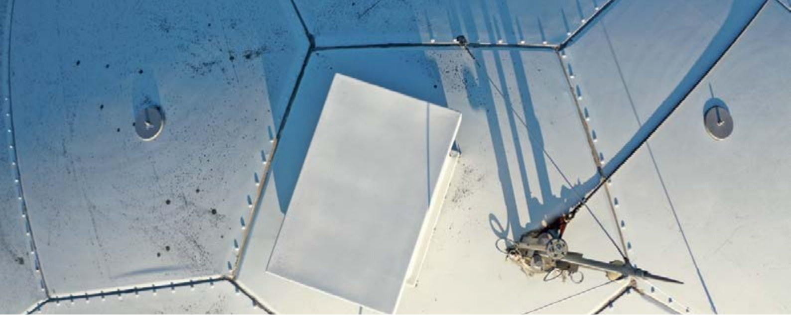
Vista aérea del radomo que cubre el radar.
