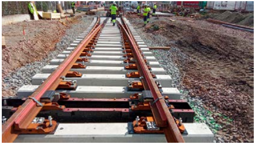
Montaje de desvío en la estación de Jabugo-Galaroza.
