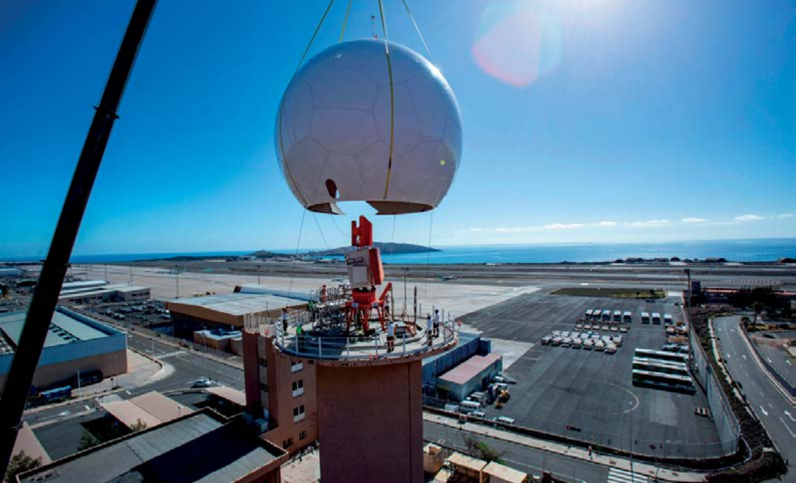
Montaje de radomo en Aeropuerto de Gran Canaria.
