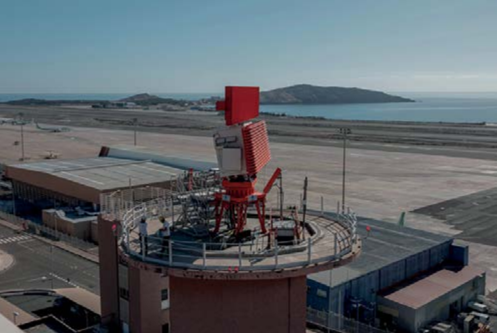
Antena del radar 3D en Gran Canaria antes de ser cubierta.
