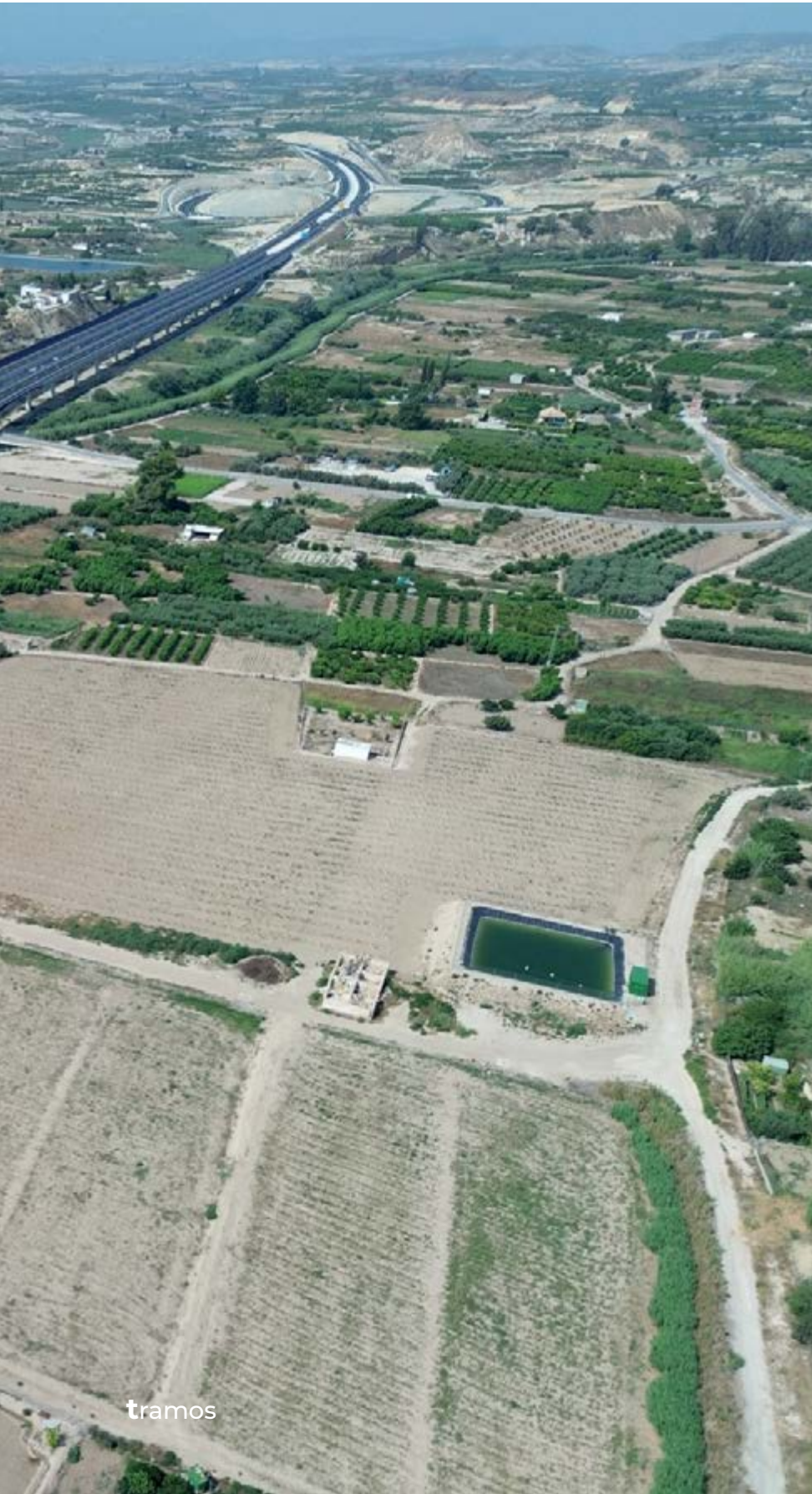
Viaducto sobre el río Segura (1250 metros), principal estructura del tramo A.
