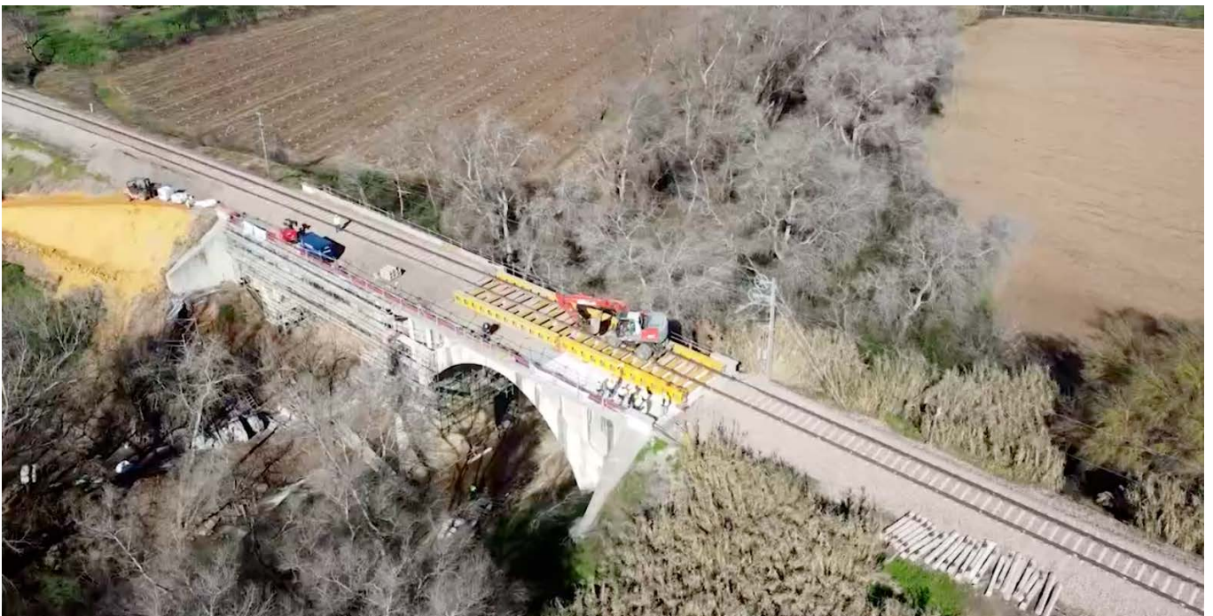
Sistema de apeo en el puente de Guadalbacar para compatibilizar los trabajos de impermeabilización en el tablero con el paso de los trenes.
