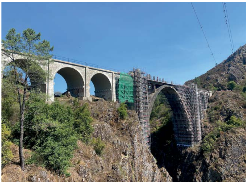
Vista del viaducto de Gundián con el andamiaje montado.
