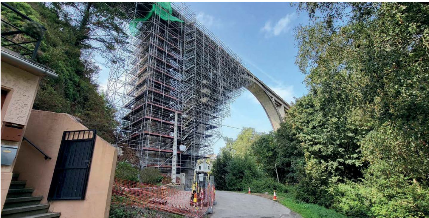
Andamiaje para reparar el arco del viaducto sobre el río Negro.
