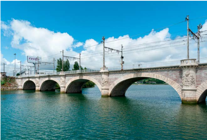
Puente internacional sobre el Bidasoa ya rehabilitado.
