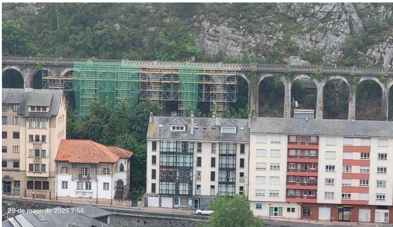
Puente de La Fomigal en plena fase de obra.
