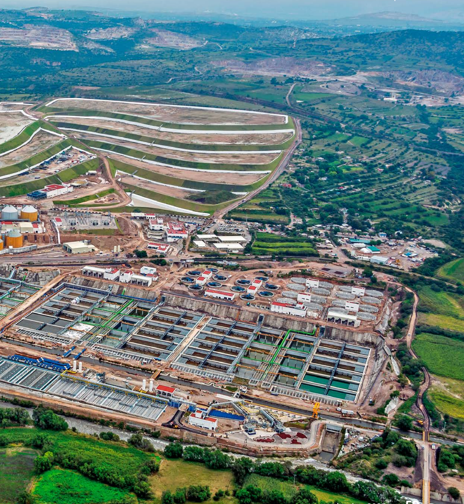
Planta de Atotonilco en México, la mayor depuradora del mundo ejecutada en una sola etapa. 2017.
