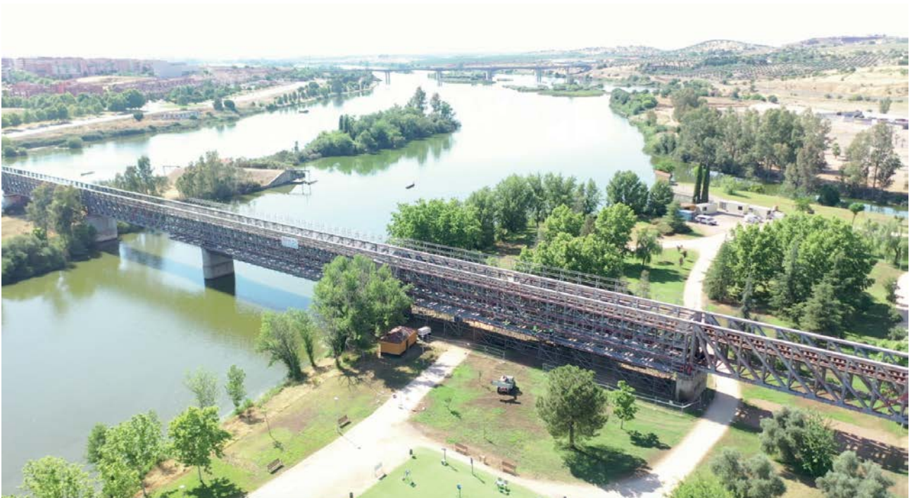
Vanos 4 y 5 con andamio en el puente de hierro de Mérida.
