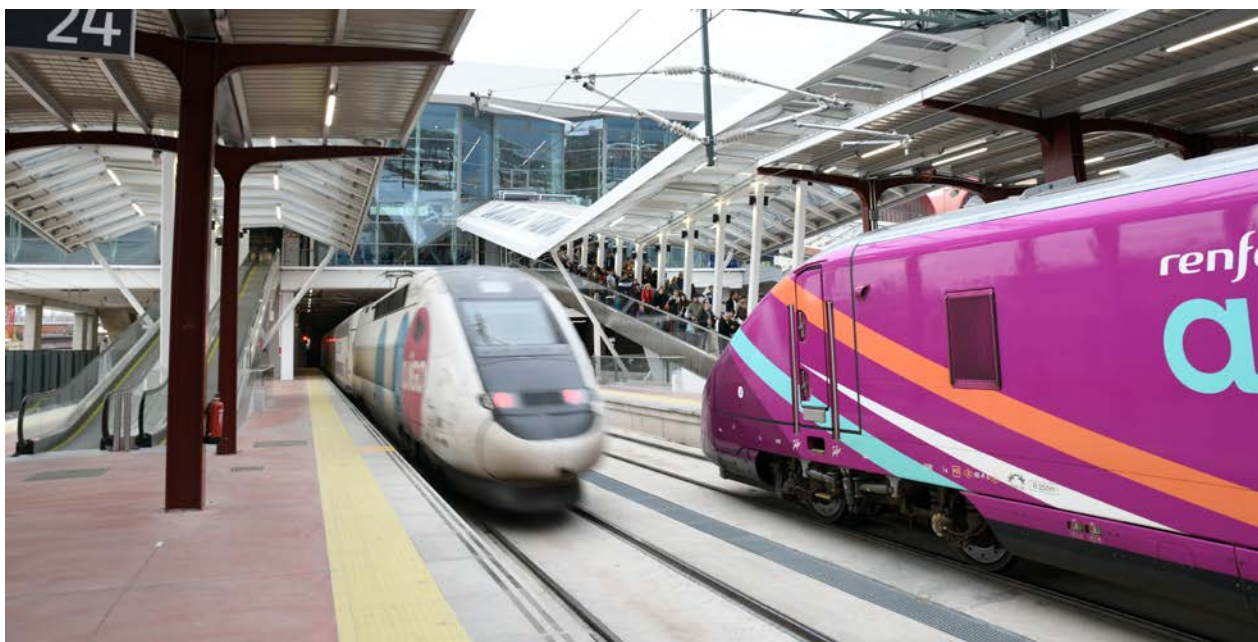
Nuevos andenes y fingers de acceso en la estación de Madrid Chamartín-Clara Campoamor.
