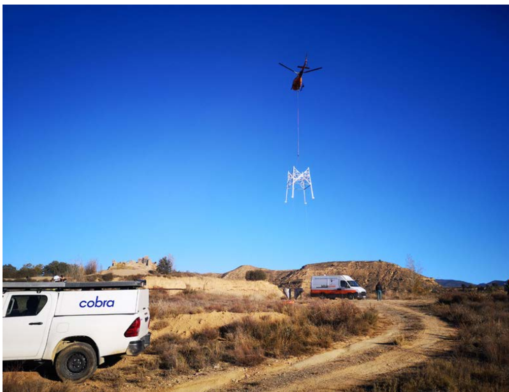
Base de torre de alta tensión helitransportada.
