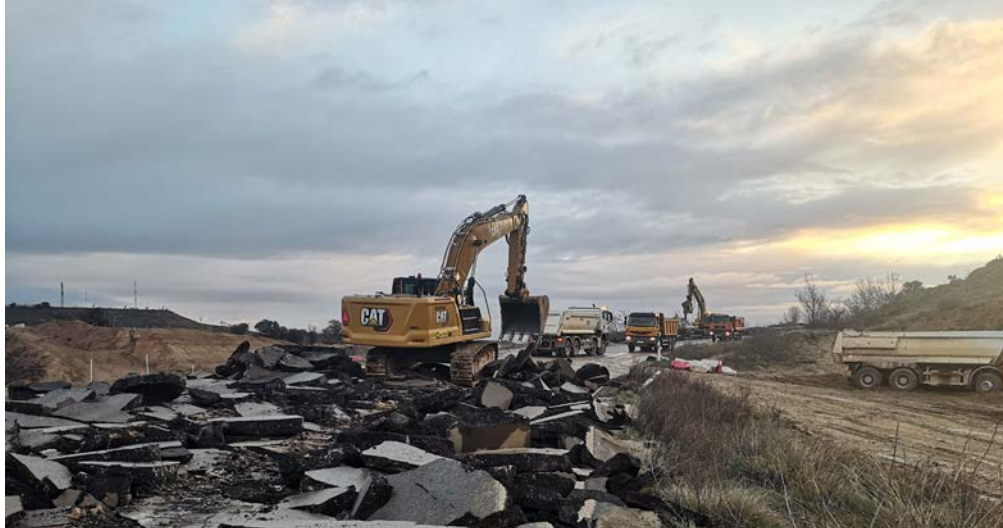
Demolición del firme de la carretera N-240.
