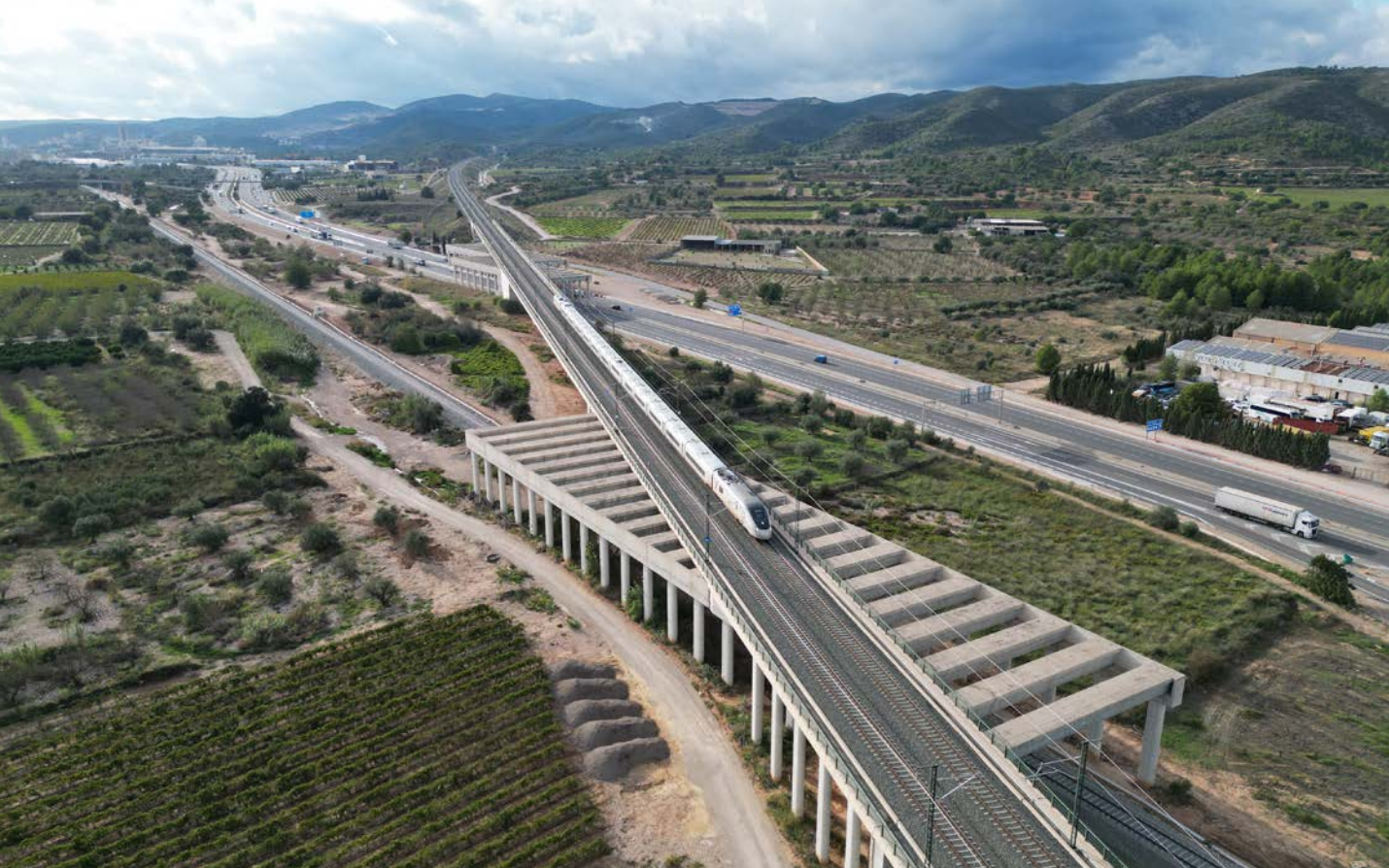
Doble pérgola sobre la autovía A-3 y la línea convencional cerca de Chiva (Valencia).
