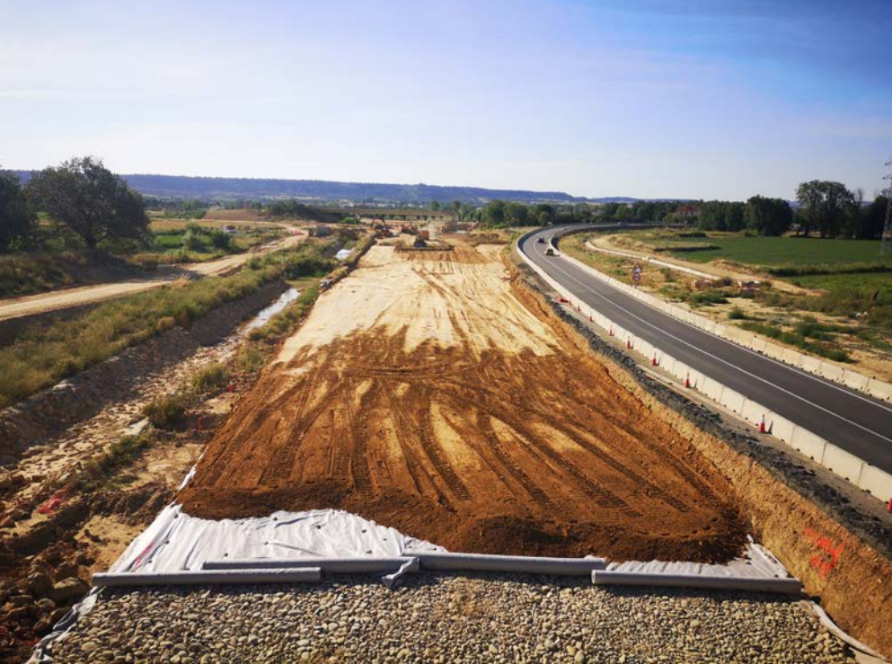
Extendido de manto drenante en la zona de Quicena.
