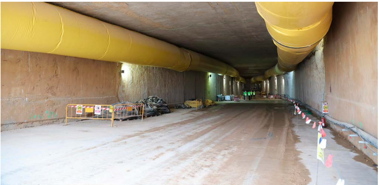
Obra subterránea del canal de acceso a Valencia.
