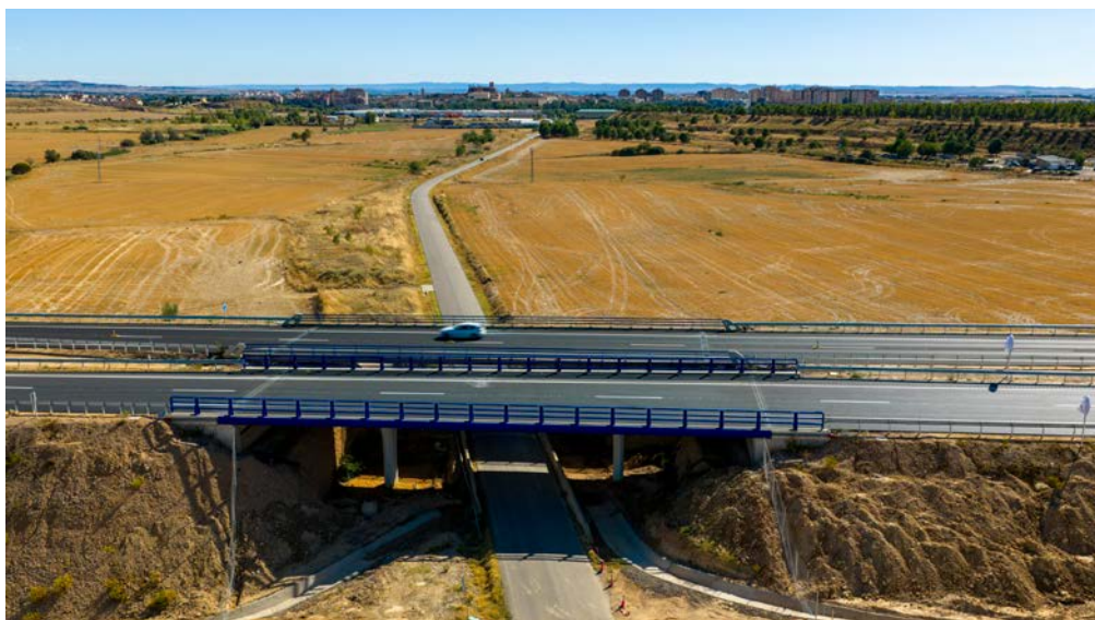
Paso superior sobre la carretera HU-V-3240.
