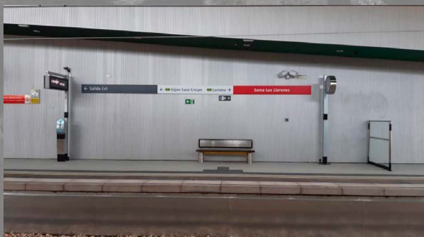
La nueva estación de Sama-Los Llerones dispone de un nuevo enclavamiento electrónico.
