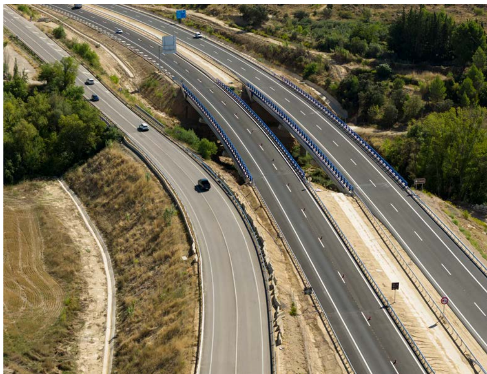
Viaducto doble sobre el río Flumen.
