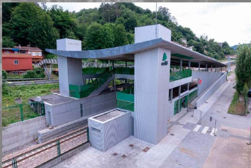
Acceso exterior a la nueva estación de Sama-Los Llerones.
