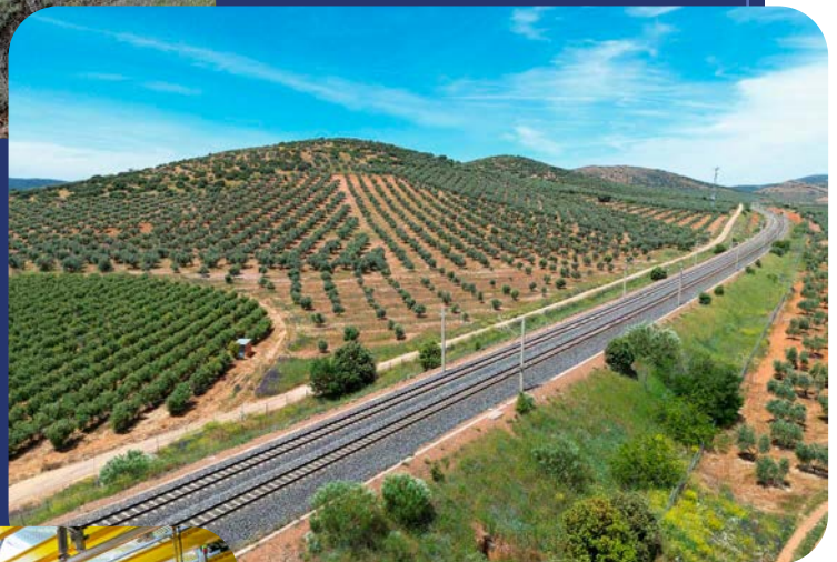
Tramo Madrid-Ciudad Real de la LAV Madrid-Sevilla.
