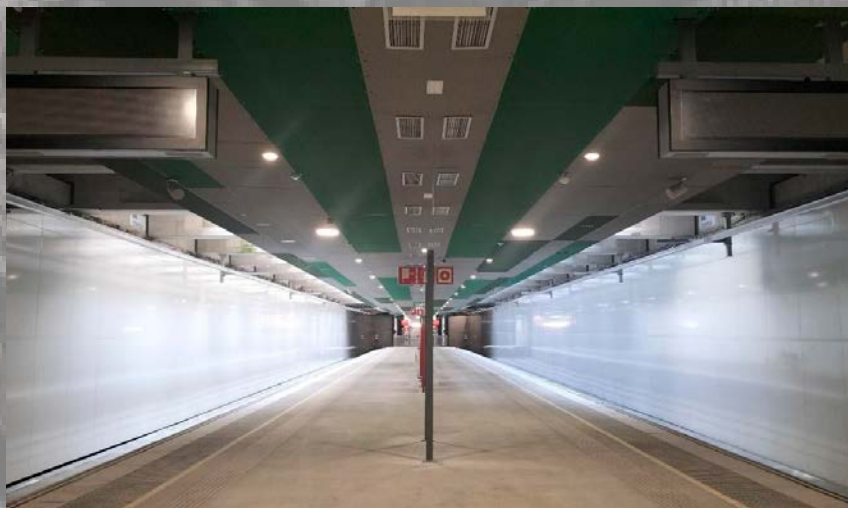
La renovación integral de la línea C5 de Cercanías ha implicado la sustitución de las vías, nuevos sistemas eléctricos, señalización y telecomunicaciones.
