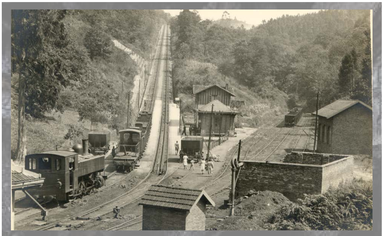
Una de las grandes obras de la línea es el plano inclinado de la Florida que presenta un desnivel de 660 metros. Fototeca Museo del Ferrocarril de Asturias.
