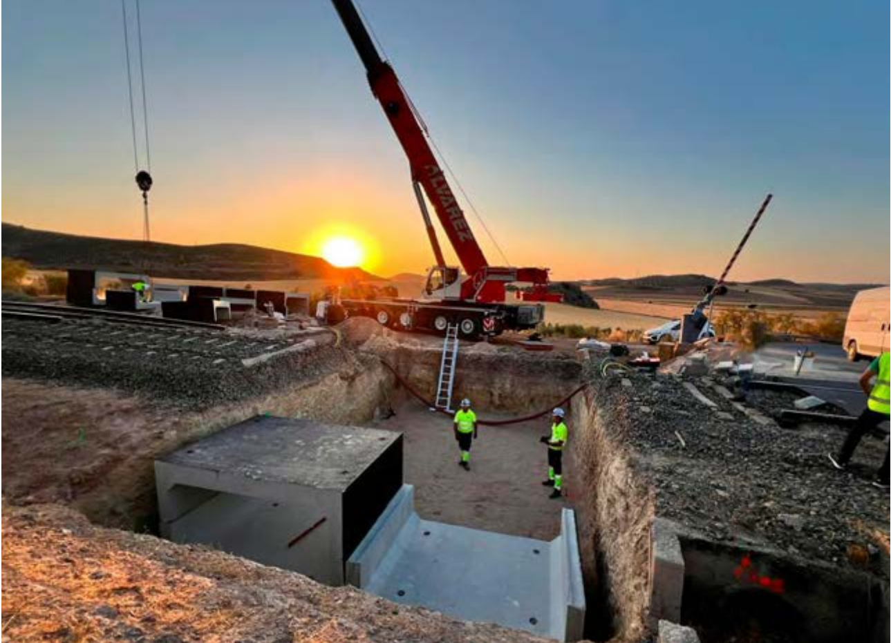
Colocación y montaje de marcos de hormigón del sistema de drenaje transversal en el tramo Bobadilla-Ronda.
