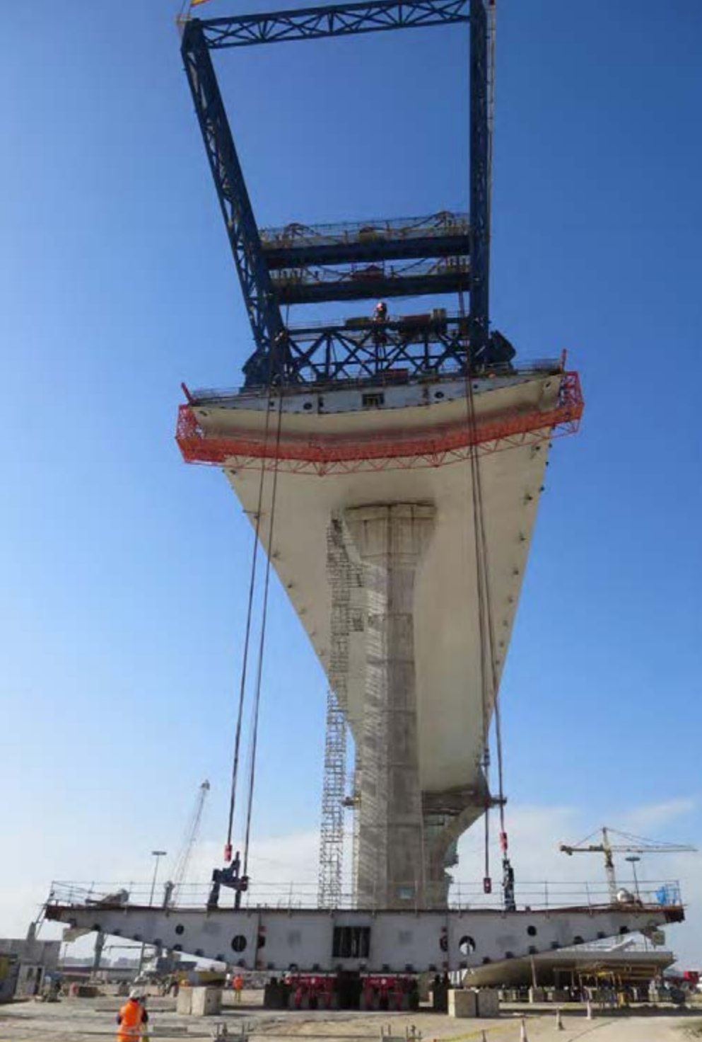
Vista del tablero desde abajo.
