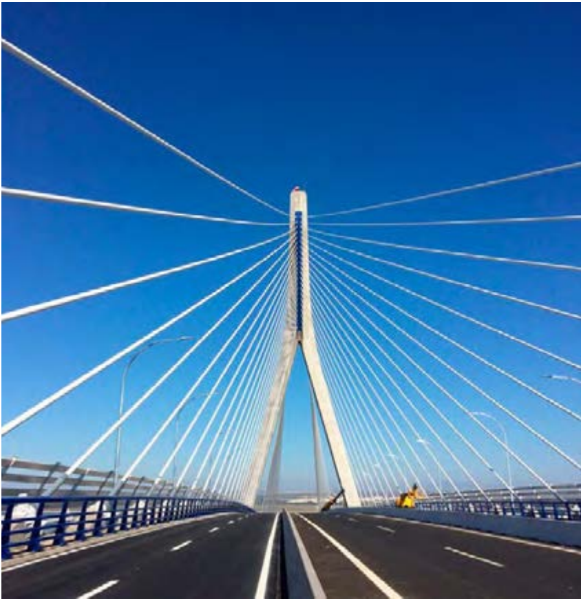
Vista de los tirantes.
