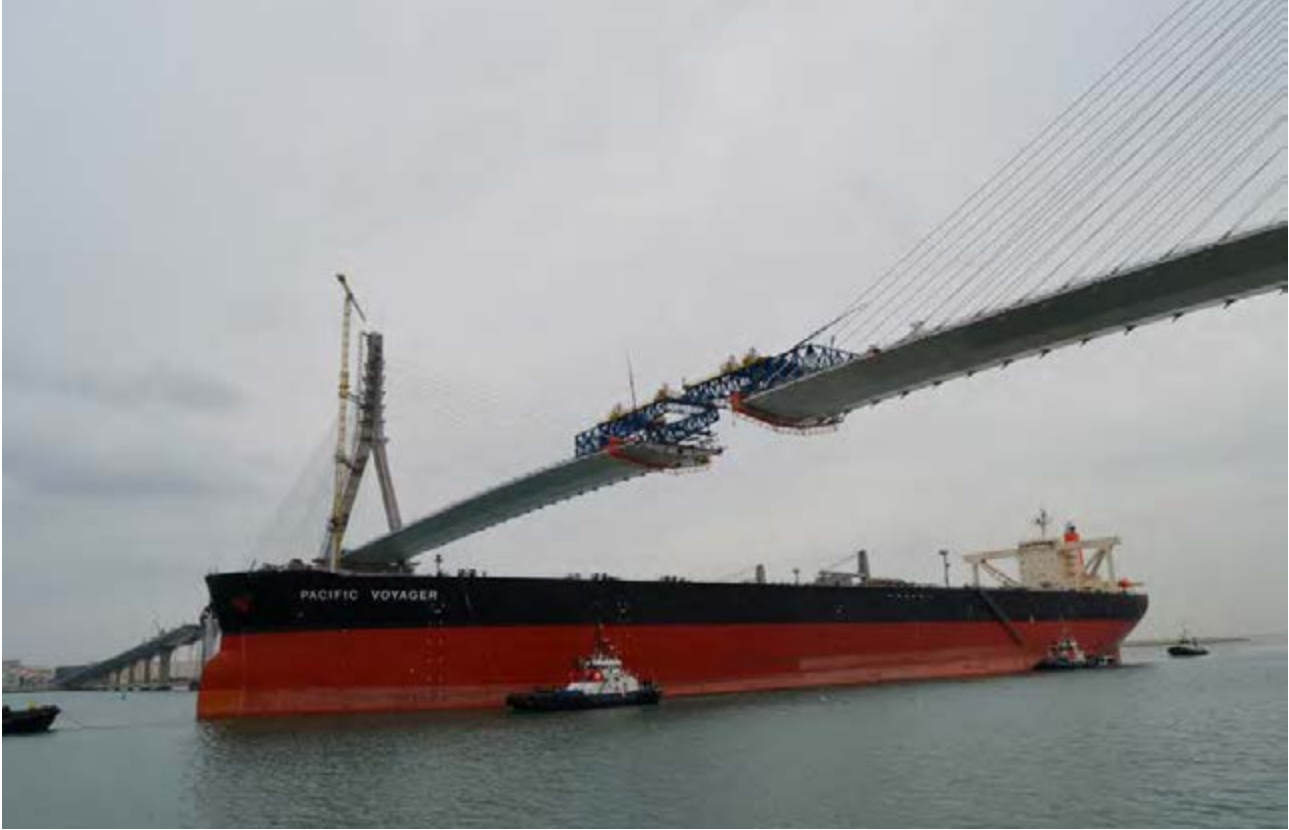
Barco pasando por el tramo atirantado en ejecución.
