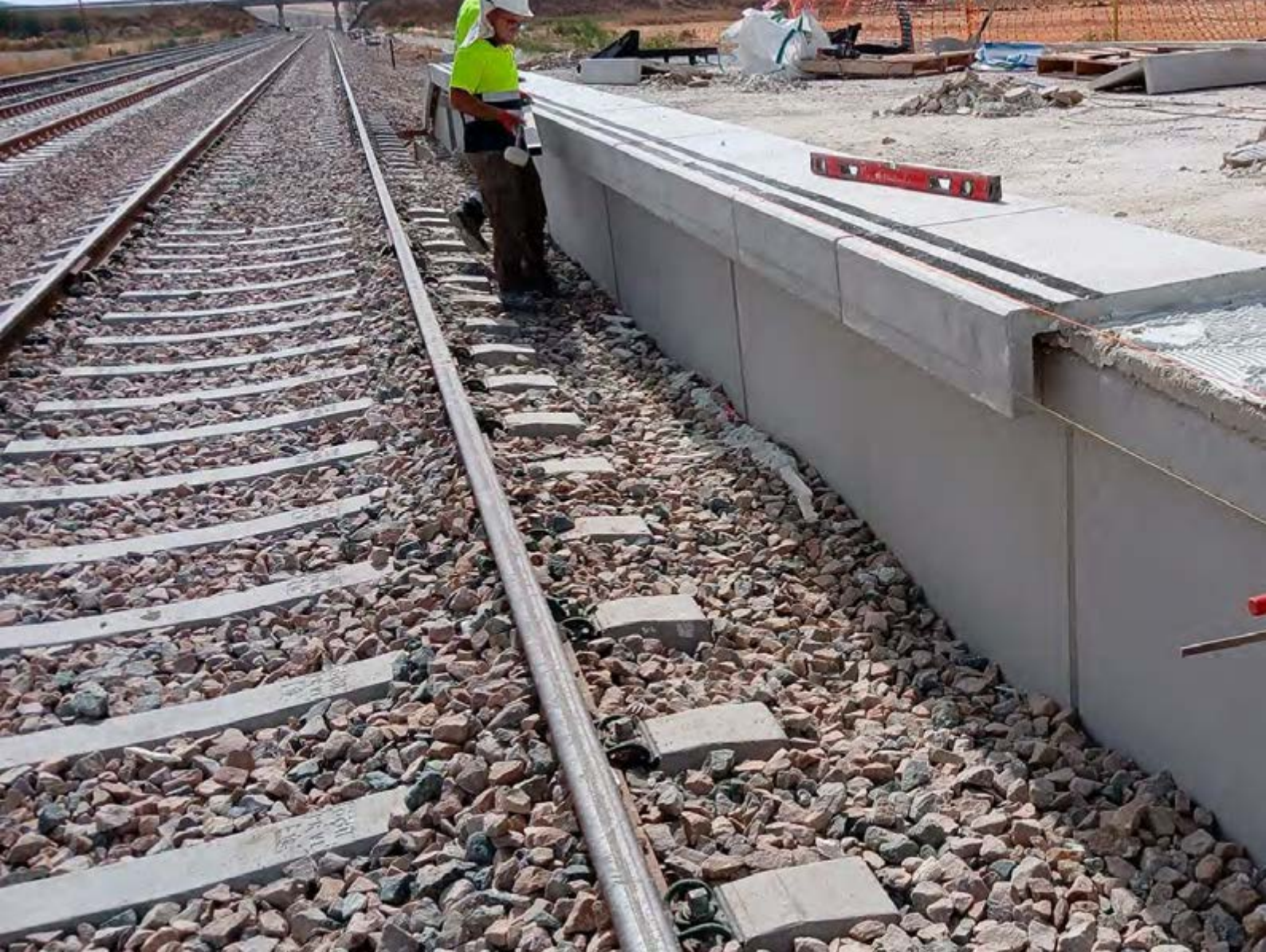
Recrecido de andén en la estación de Campillos.
