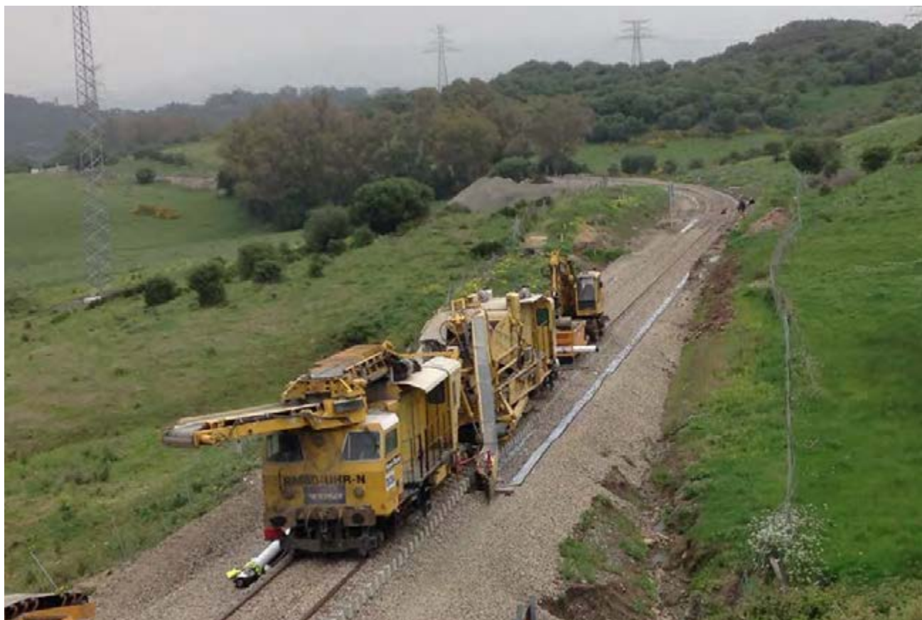
Colocación de geocompuesto y riego de balasto en el tramo Almoraima-Algeciras.
