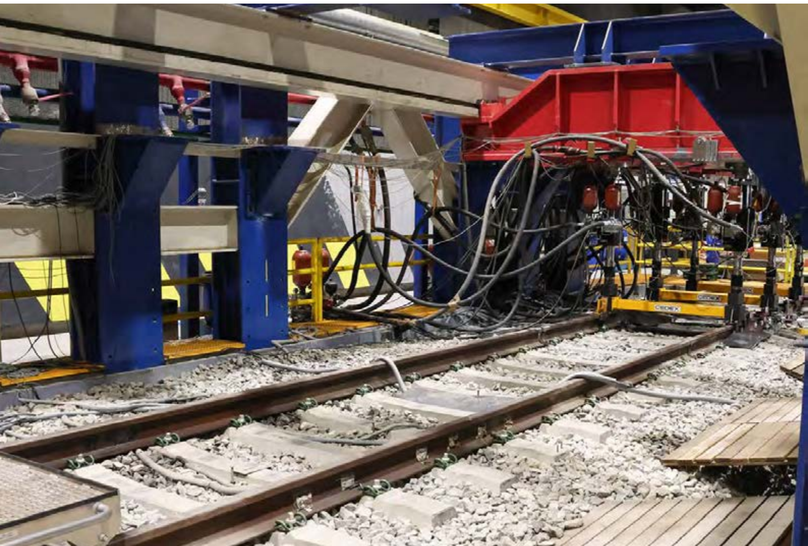
Panorámica del «Cajón Ferroviario del CEDEX» (CFC) preparado para ensayar sobre una sección en balasto.
