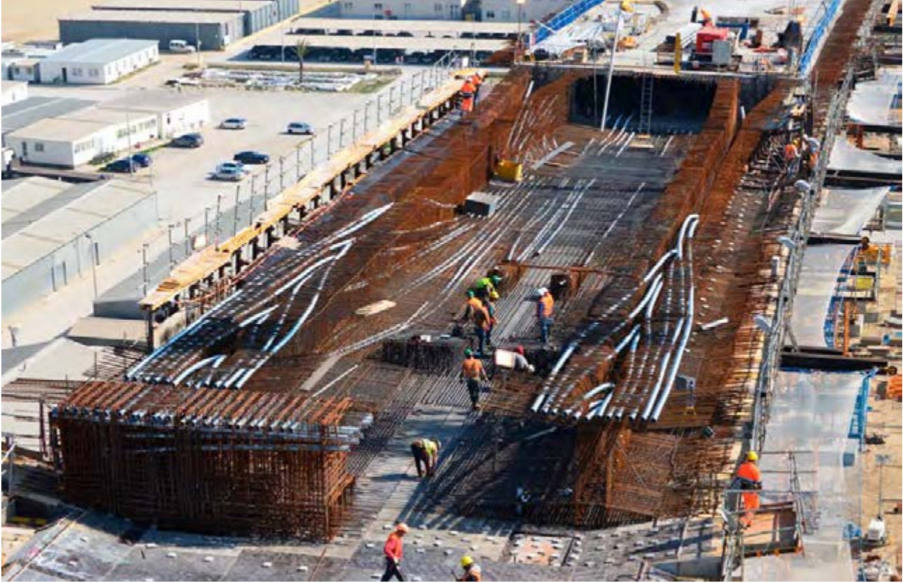
Construcción del tablero.
