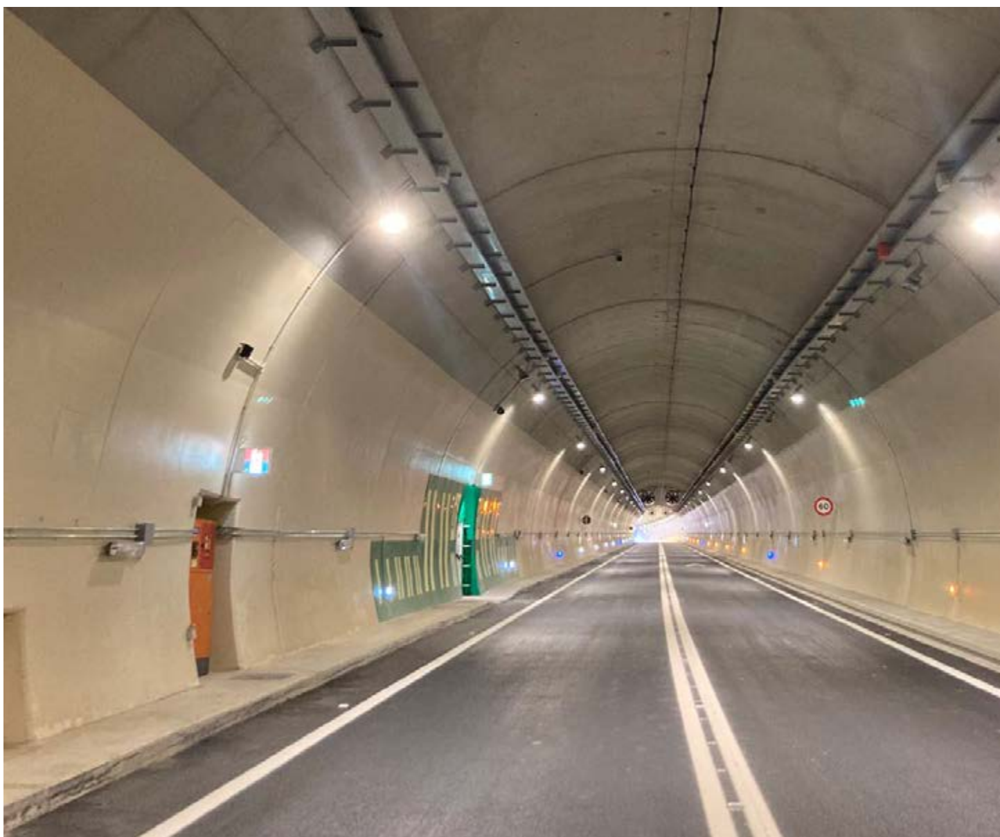
Interior del túnel de Campo en la N-260 (Huesca), en servicio desde 2024.
