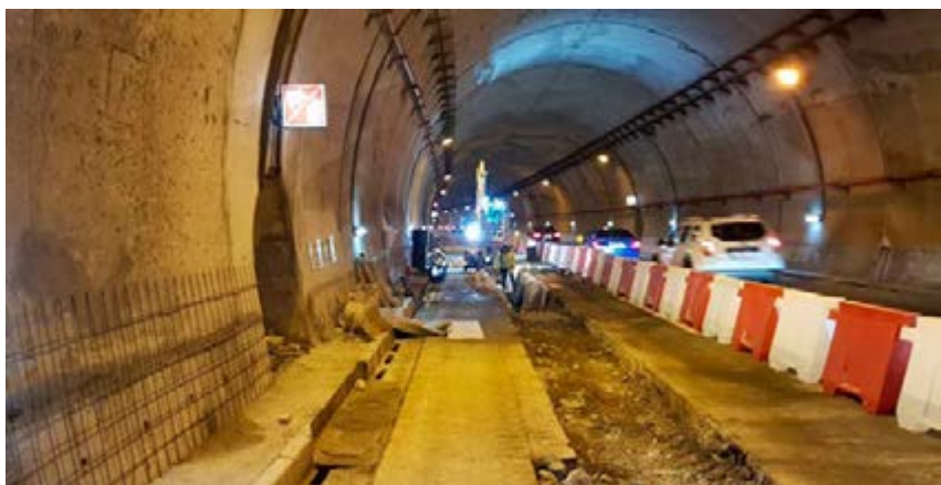
Obra de mejora de drenaje en el túnel de Fabares, en la A-64 (Asturias).
