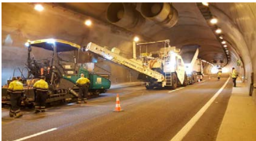
Trabajos de reposición de firme en uno de los túneles de Guadarrama (Madrid).
