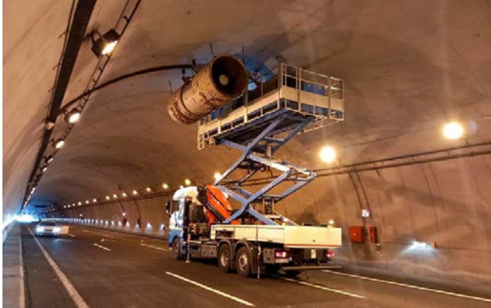
Inspección del sistema de ventilación del túnel de Trabadelo en la A-6 (León).
