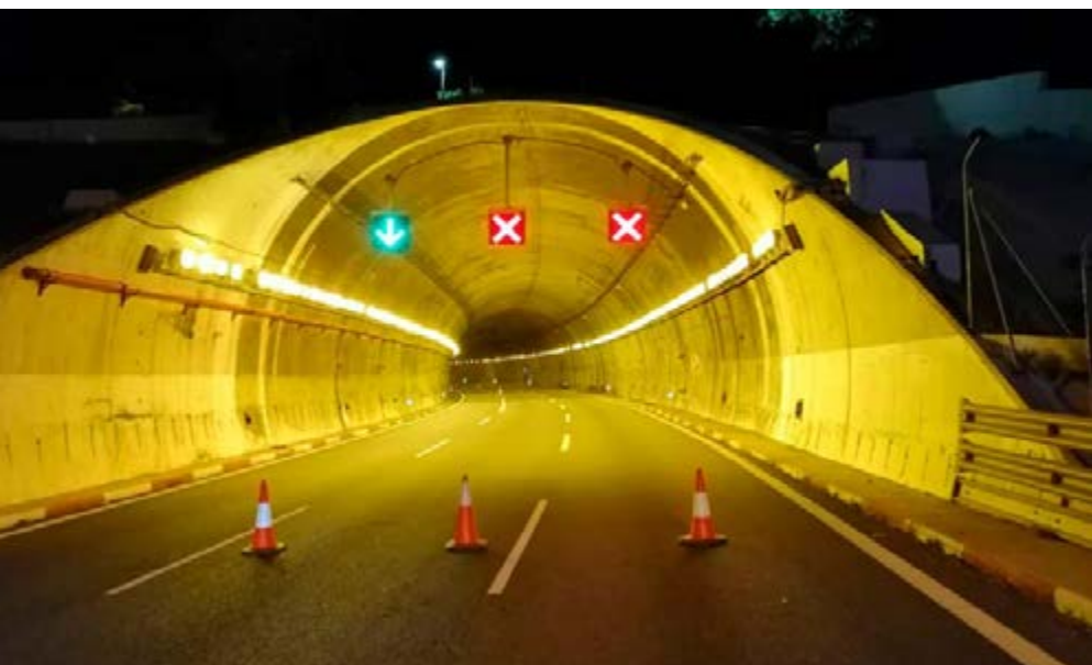
Boca del túnel de Cerrado de Calderón en la A-7 (Málaga), cerrado al tráfico durante las obras de adecuación.
