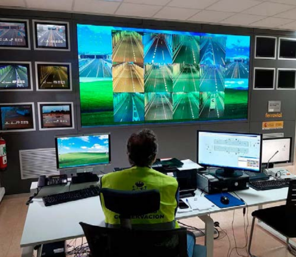
Centro de control de una autopista de peaje gestionada por un operador privado.
