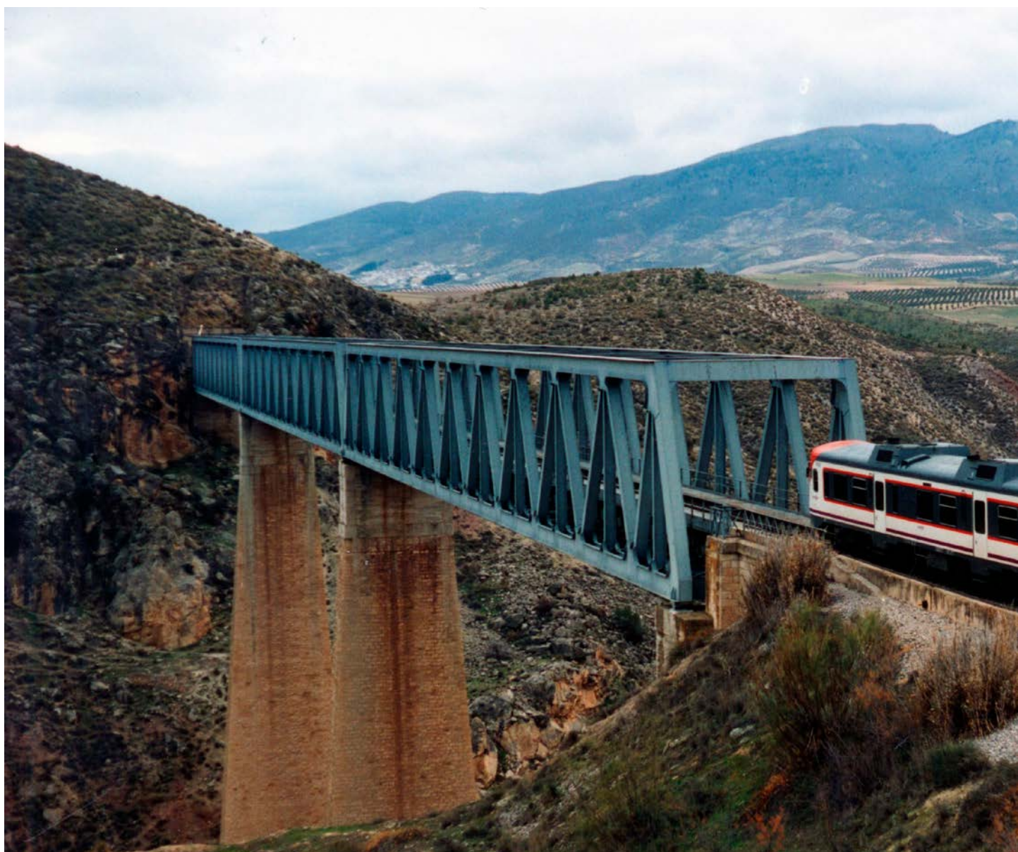
Esta infraestructura forma parte de la línea de ferrocarril Linares-Almería.
