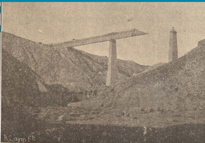
El viaducto del arroyo Salado, ubicado entre las estaciones de Quesada y Larva, debía superar un barranco profundo en una zona de difícil acceso.
