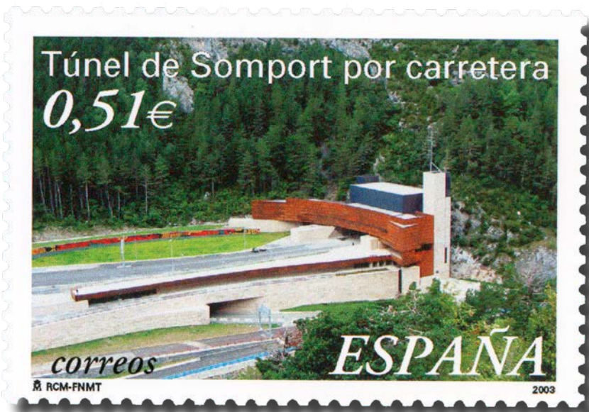
Túnel de Somport por carretera.
