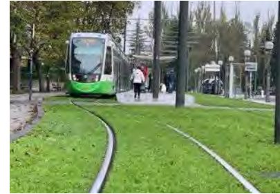
infraestructuras 24 El tranvía de Vitoria-Gasteiz avanza hacia Zabalzana
