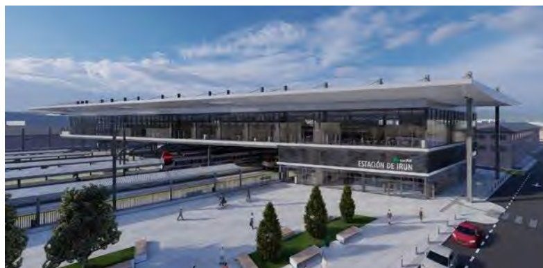
infraestructuras 6 En servicio el módulo de cercanías de la nueva estación de Irún
