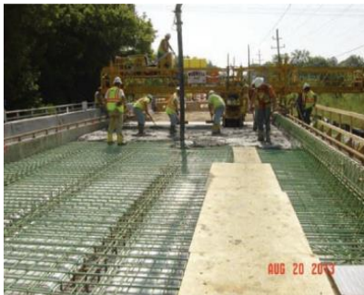
Fotografía 24. Detalle de la ejecución de la losa de hormigón de un puente. El color verde de las armaduras se debe a que están revestidas con resina epoxi. [123]
