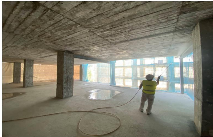
Figura 38. Aplicación de inhibidor de corrosión en superficie. [79]
