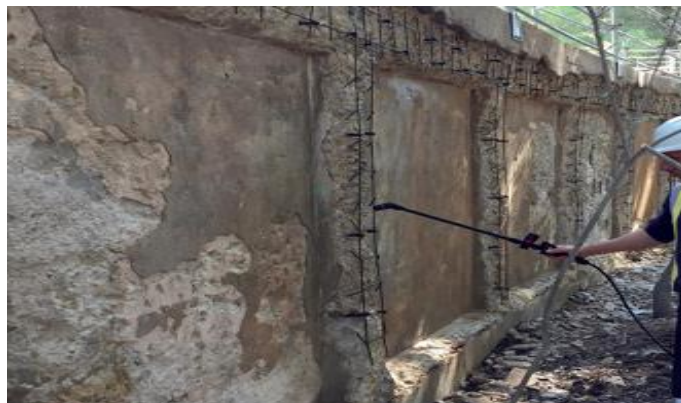
Figura 39. Aplicación del inhibidor en el tablero del puente de Pravia. [80]
