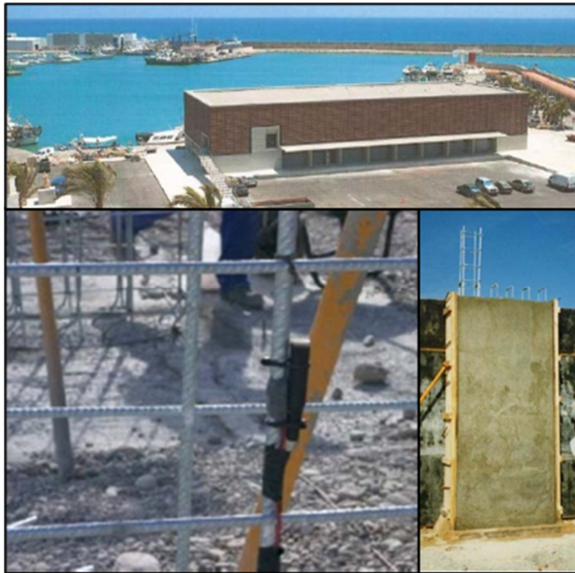
Figura 6: Arriba, obra finalizada; abajo, detalles de la armadura galvanizada antes y después del hormigonado © [17]
