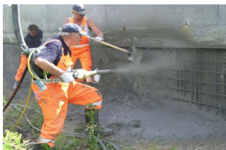
Fotografía 38. Aplicación de hormigón proyectado en Lyngby, Dinamarca. [142]
