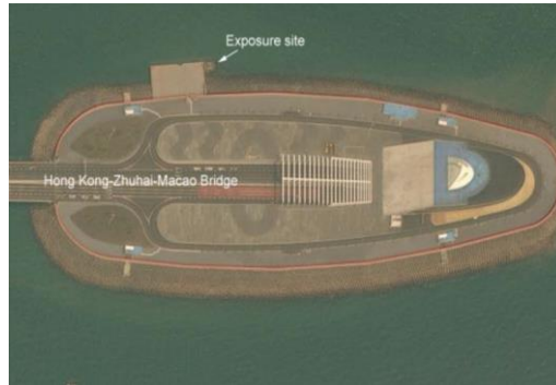
Figura 66. Zona especialmente habilitada para probetas que habrán de ensayarse para comparar con muestras de obra y realizar seguimiento del puente HZM [128]
