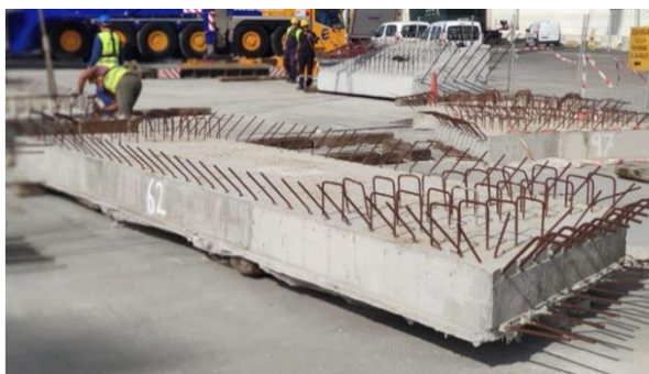
Figura 42. Pieza de hormigón recién fabricada sobre la que se aplica inhibidor de corrosión [81]
