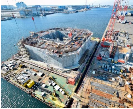
Fotografía 27. Plataforma de hormigón aligerado en construcción. Proyecto FLOTAGEN. [131][132]
