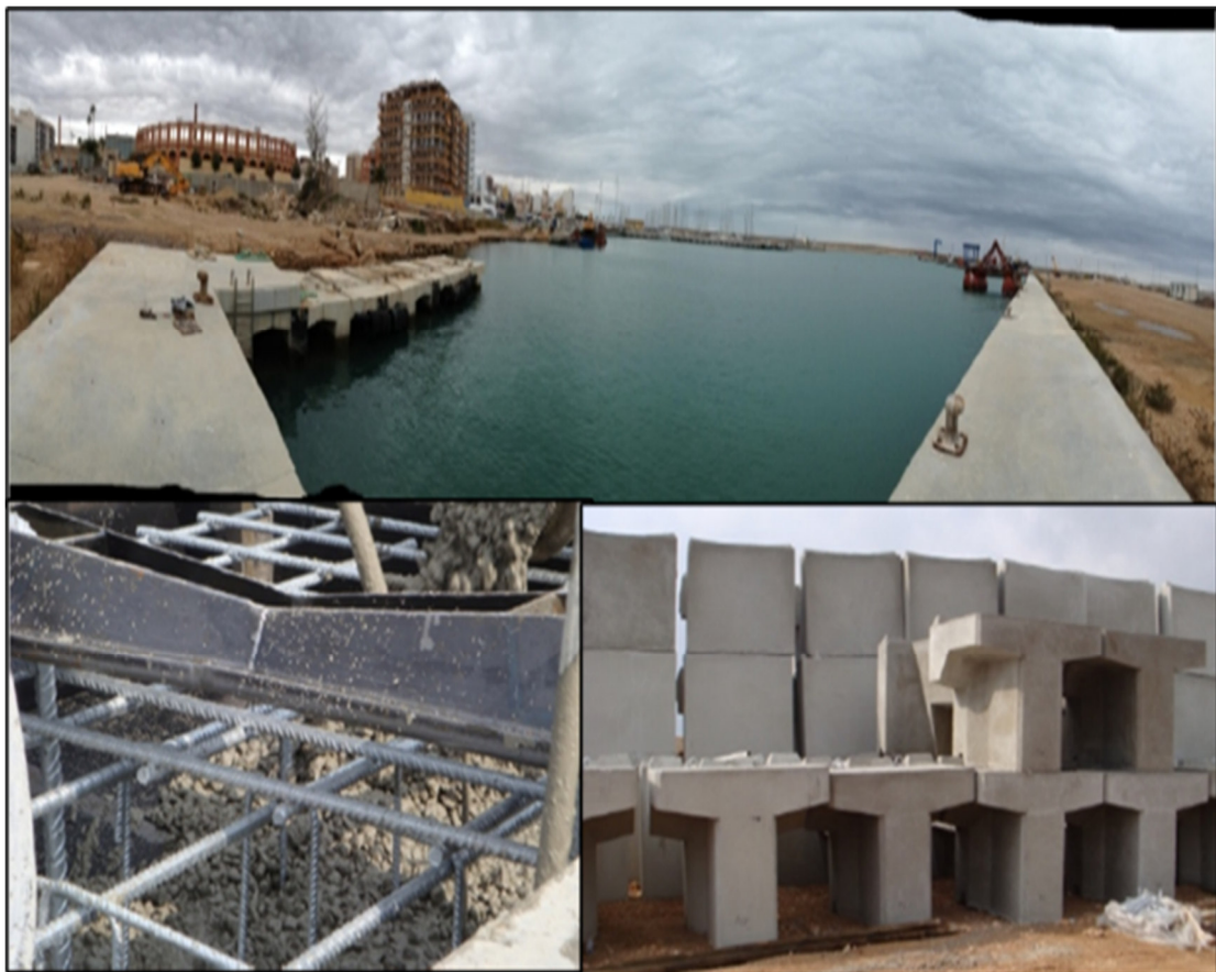
Figura 7: Arriba, obra finalizada; abajo, detalles de la armadura galvanizada antes y después del hormigonado © [17]
