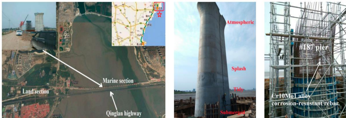
Fotografía 3. Pila en la zona del puente expuesta a ambiente marino en todas sus posibilidades: sumergido, carrera de mareas, salpicaduras y ambiente aéreo [41]
