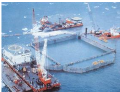
Fotografía 30. Tarsiut Island (1981) hecha a base de cajones sumergibles aligerados [136]
