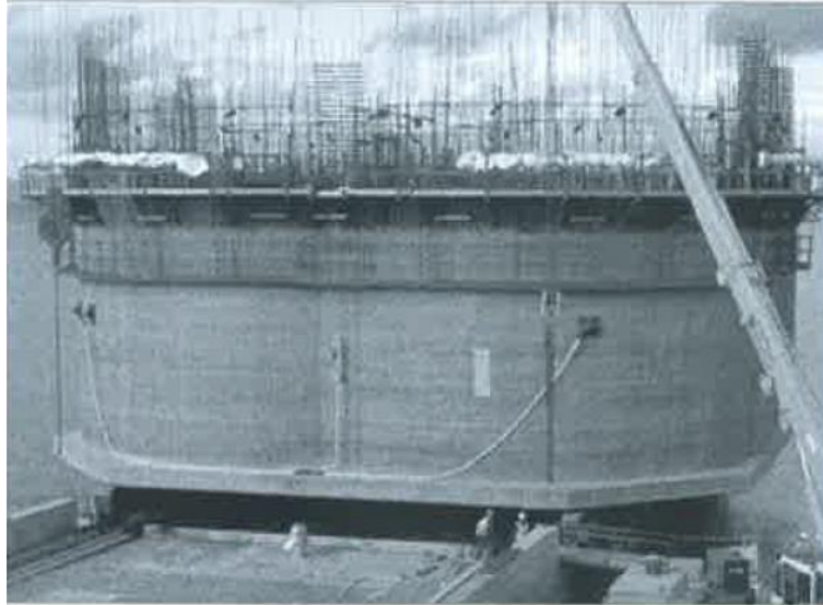
Fotografía 16. Construcción del nuevo muelle en la zona inferior derecha de la fotografía [45]
