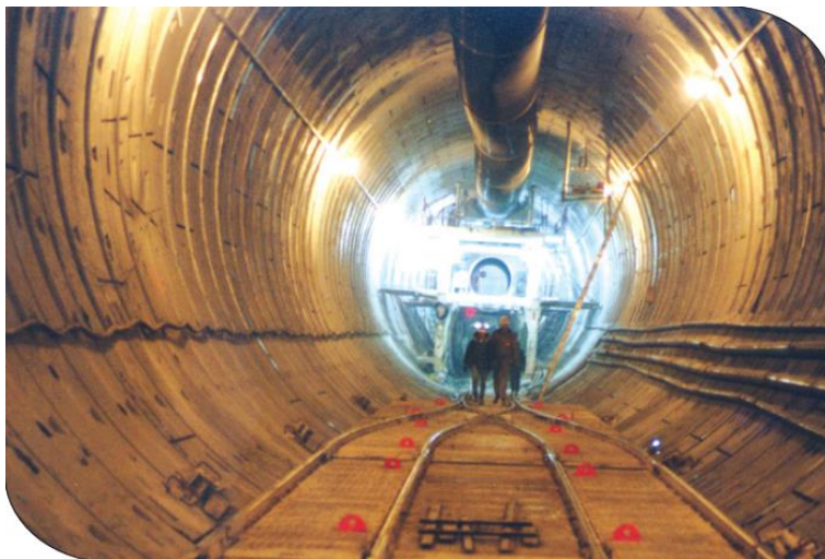
Fotografía 5. Túnel de St. Clair [27]
