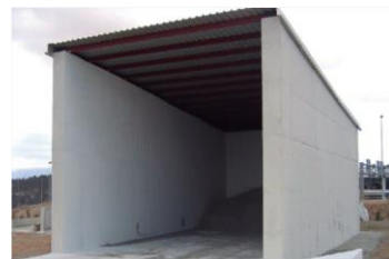
Figura 49. Almacén de sales de dehielo. Demarcación de carreteras de Teruel [84]
