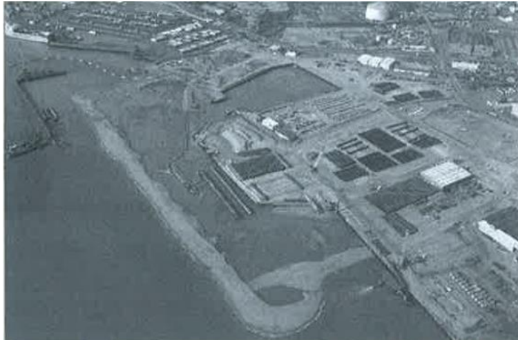
Fotografía 10. Construcción del nuevo muelle en la zona inferior derecha de la fotografía [45]
