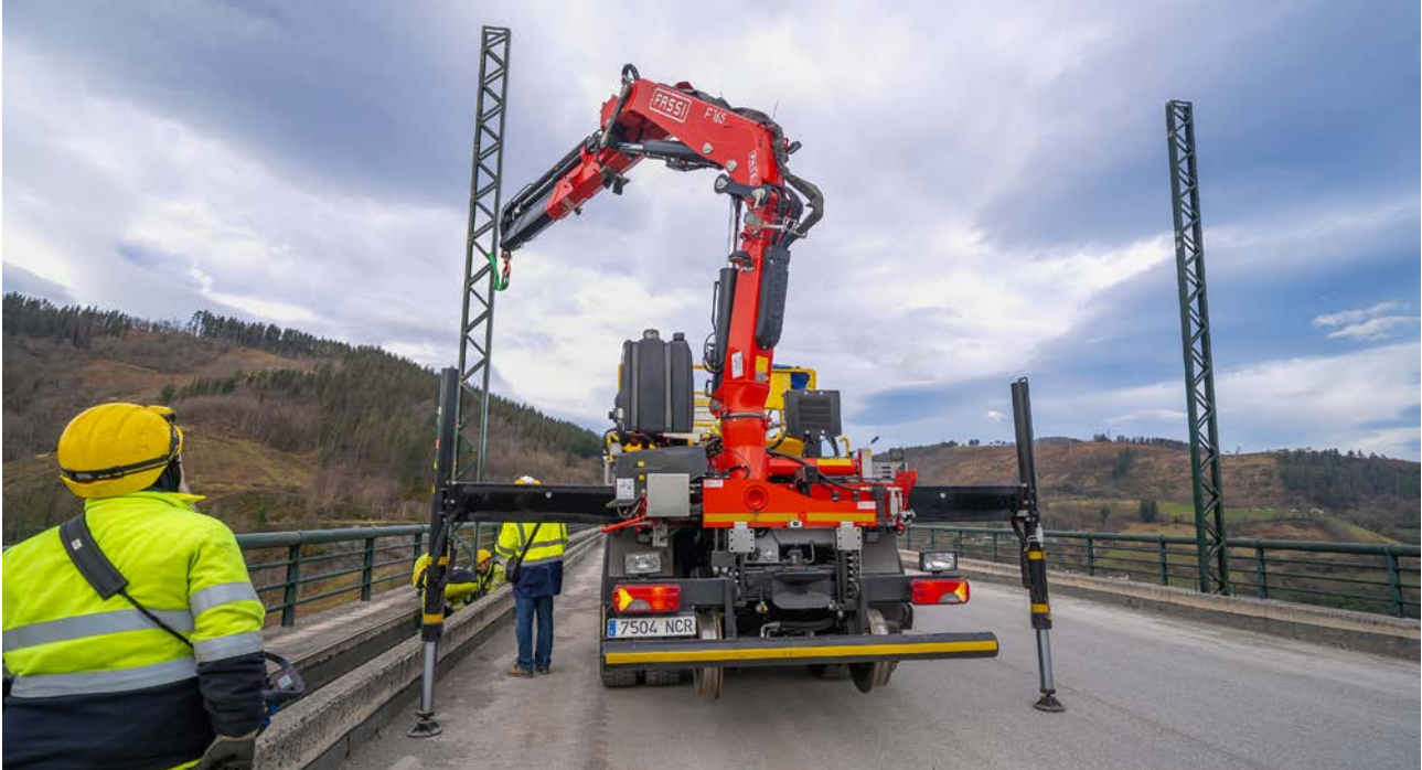
Izado de uno de los postes de electrificación en el viaducto Deba.
