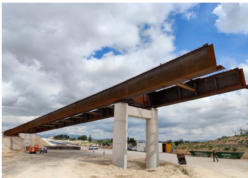
Viga de acero corten del vano inicial de la estructura E-12.
