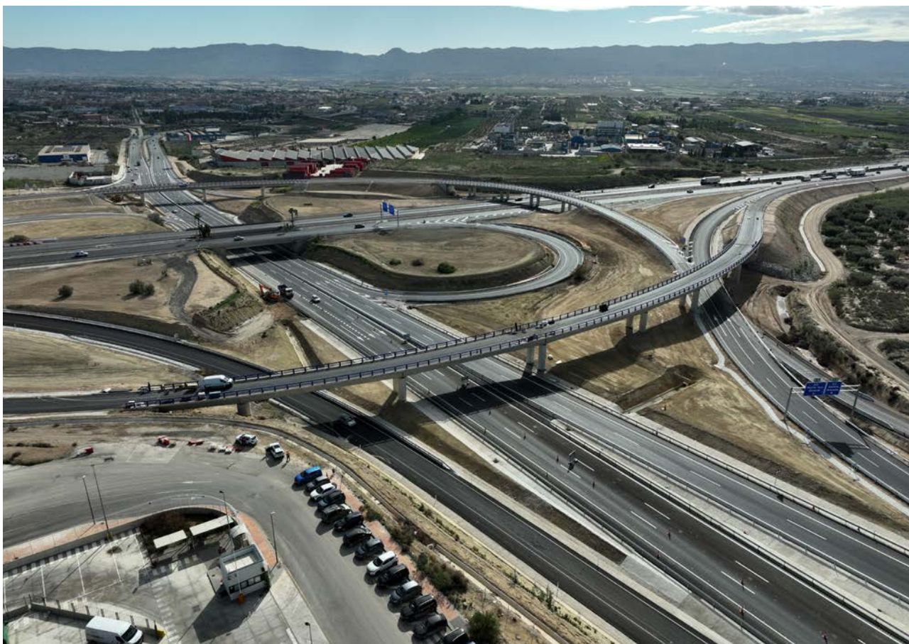
Enlace de Alcantarilla, con la estructura E-11 en primer plano.
