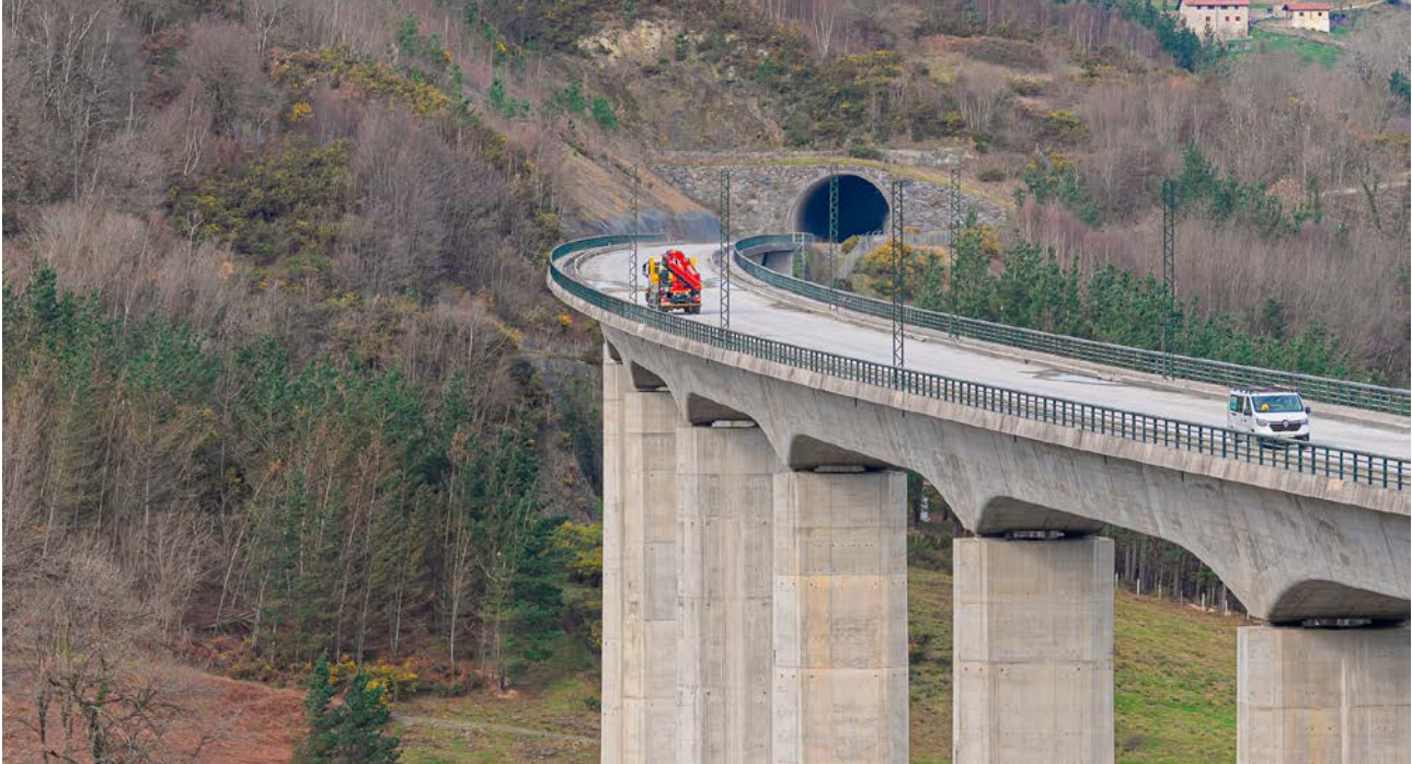
Postes de catenaria izados en el viaducto sobre el río Deba.
