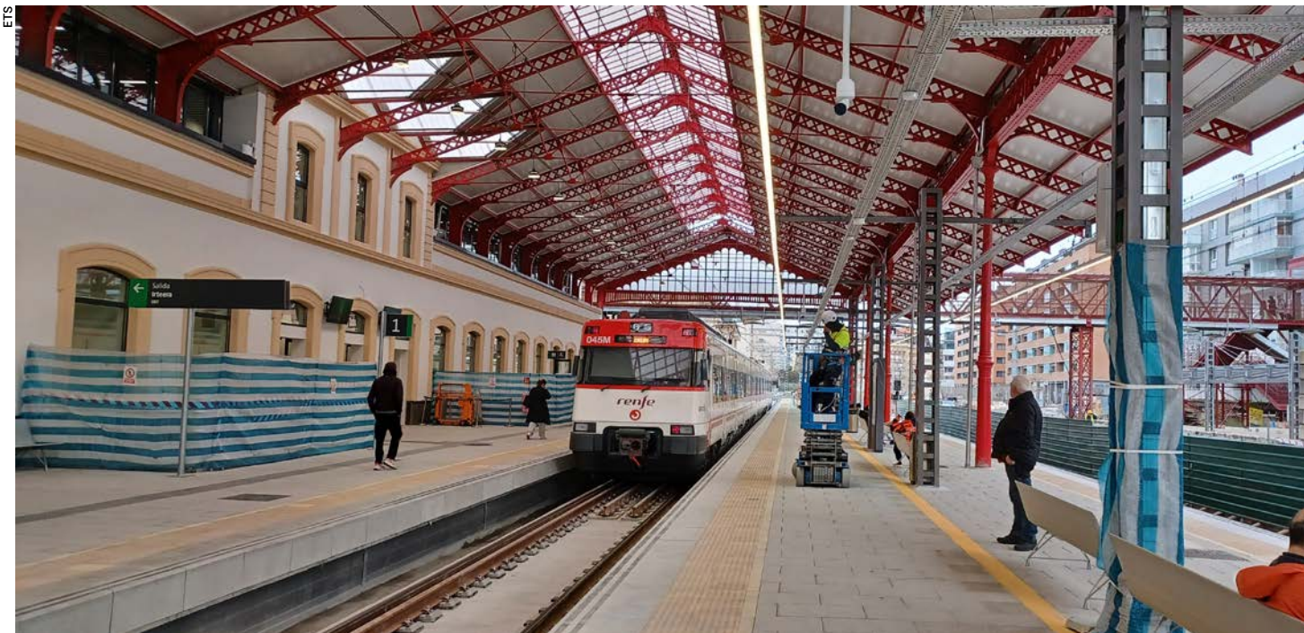
Andenes de Cercanías con vías de ancho mixto en la remodelada estación de Atotxa.
