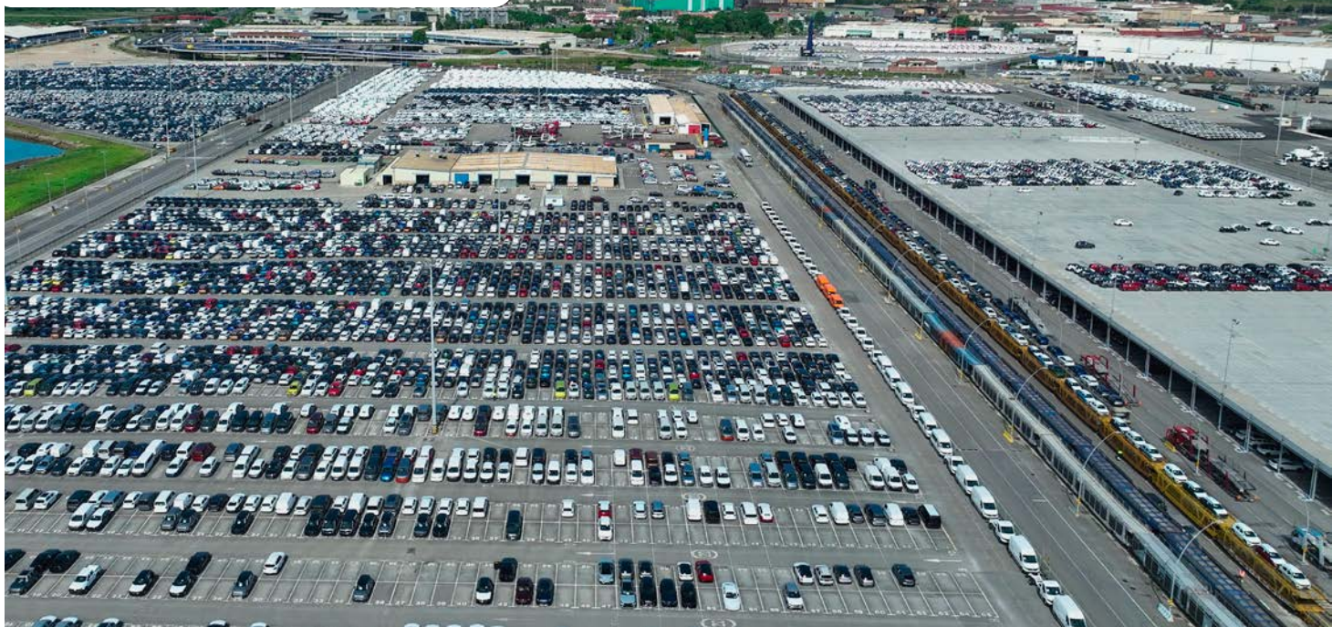
Terminal de vehículos del puerto de Santander. Fuente: Autoridad Portuaria de Santander.
