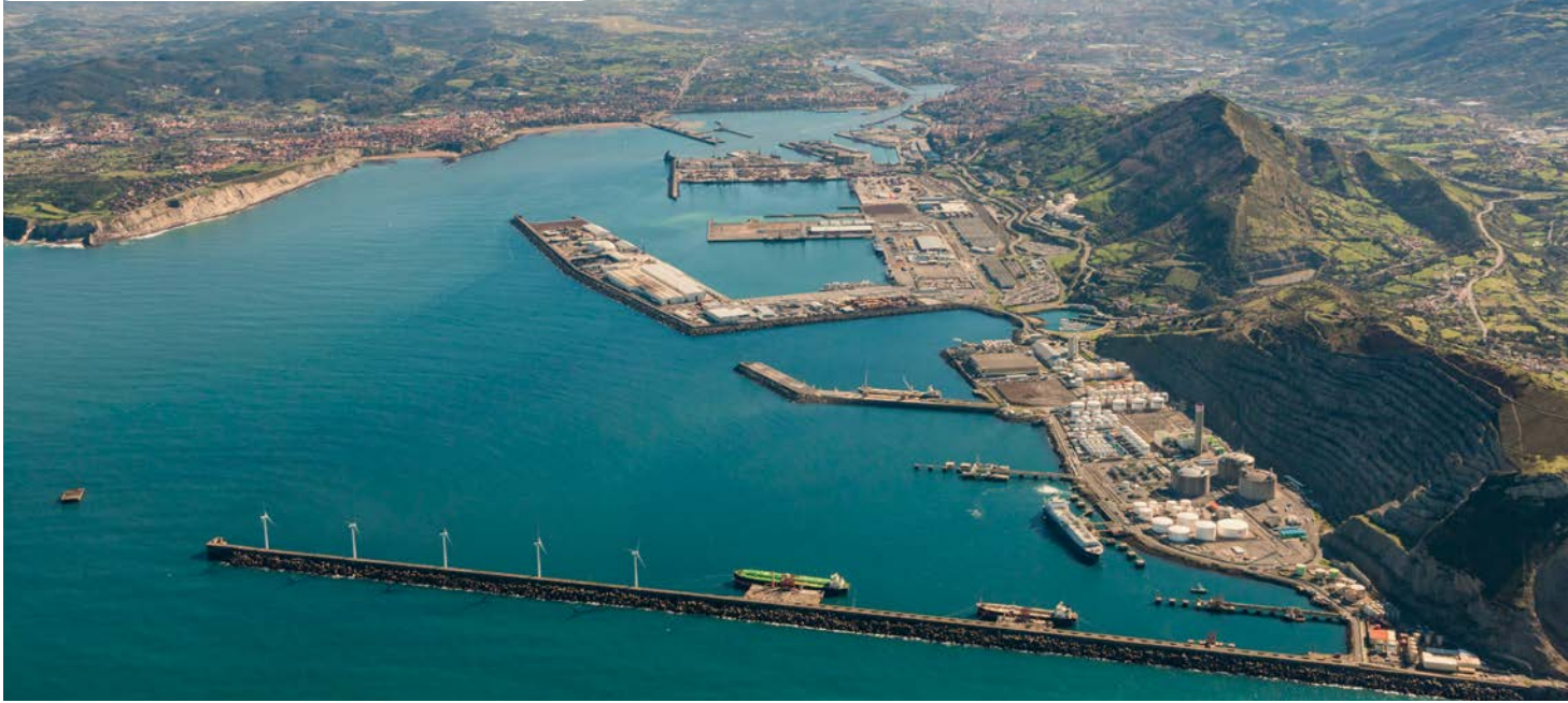
Vista aérea de las terminales del puerto de Bilbao. Fuente: Autoridad Portuaria de Bilbao.
