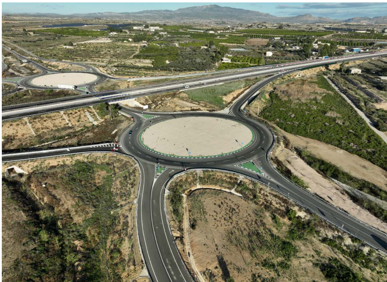
Enlace de Las Torres de Cotillas con la carretera RM-B37.
