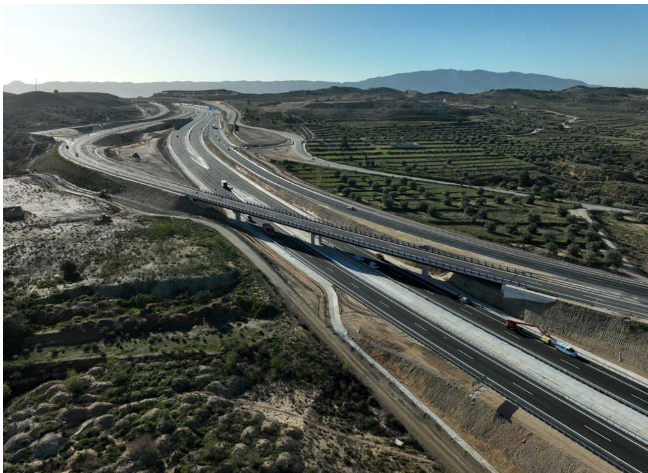
Vista de la estructura E-12 sobre la nueva autovía.
