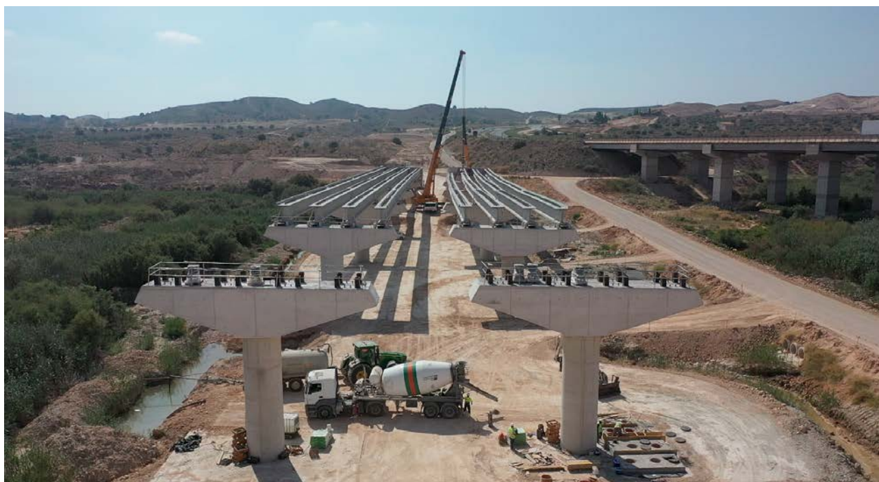
Colocación de viga en doble T en el viaducto de la Rambla Salada.
