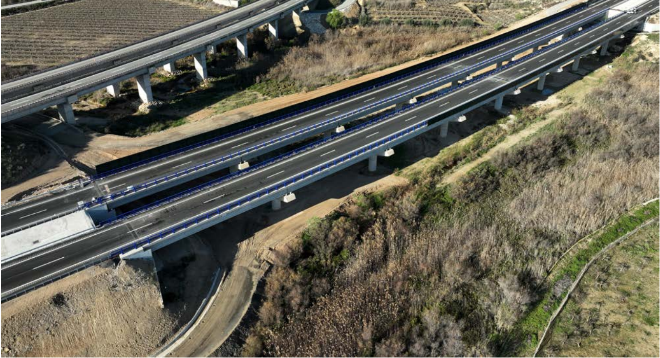
Viaducto sobre la Rambla Salada, de 272 metros de longitud.
