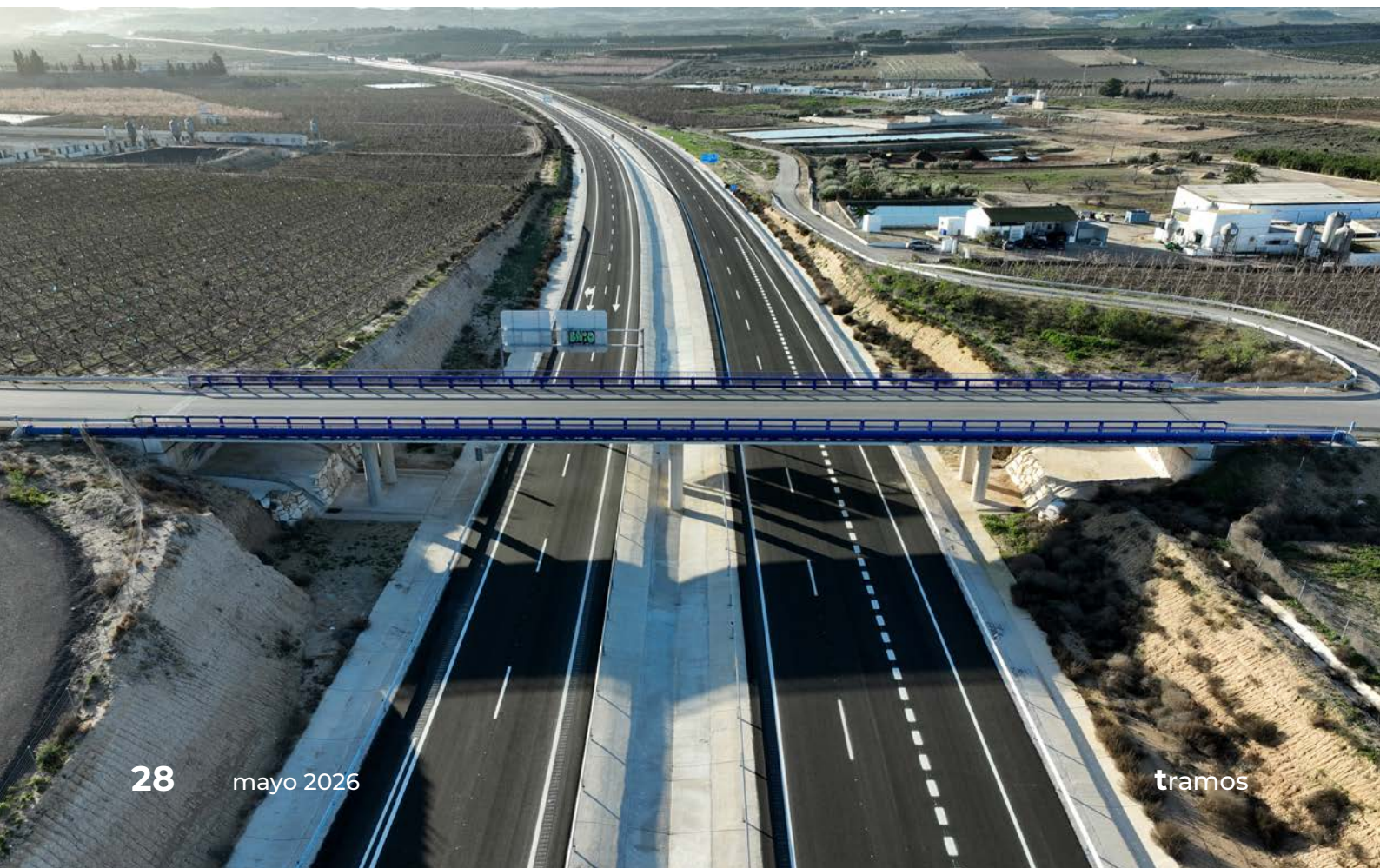
Paso superior en el p. k. 15+130 del Arco Noroeste.
