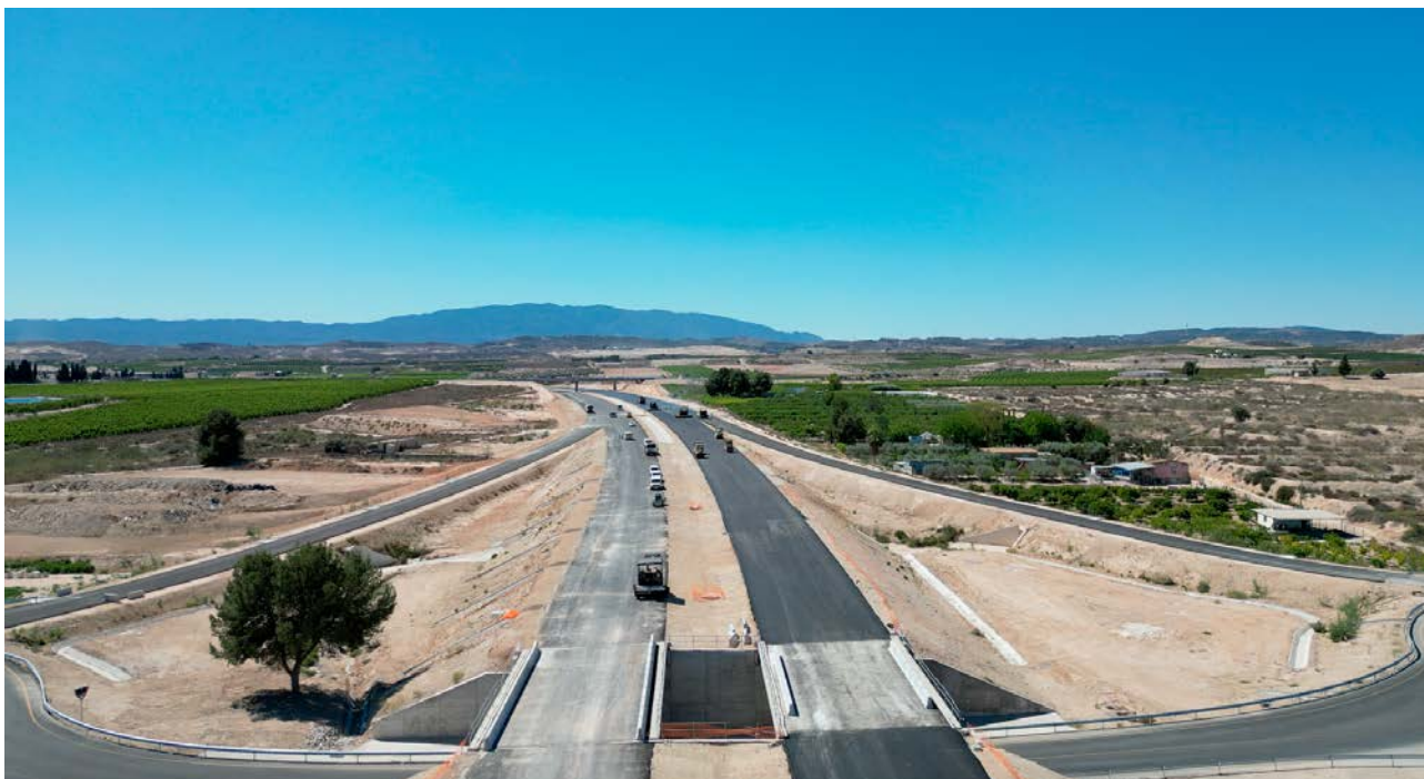
Ejecución de una de las capas de firme en una calzada de la autovía.
