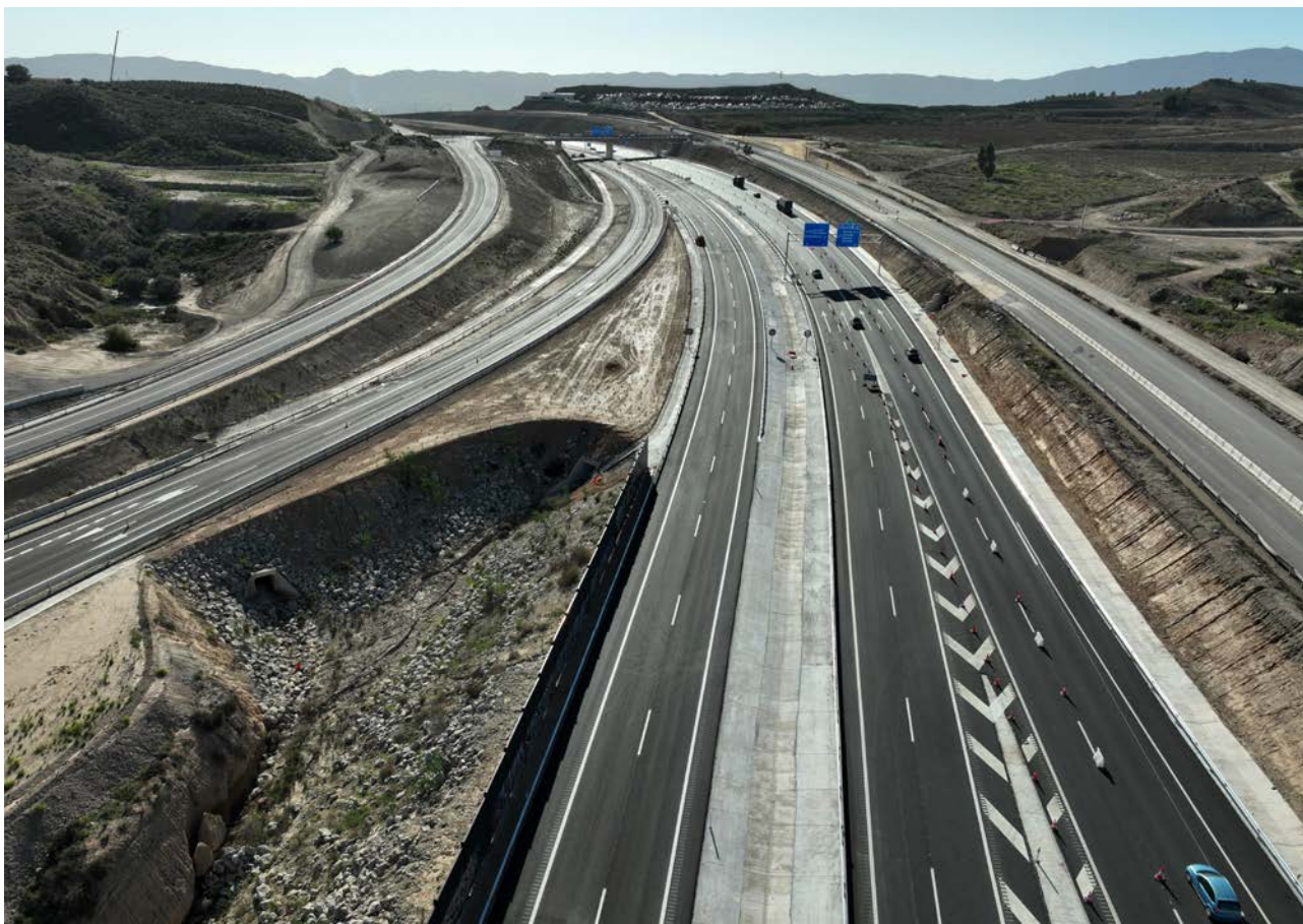
Tramo de la A-30 entre los enlaces de Alcantarilla y la RM-15.
