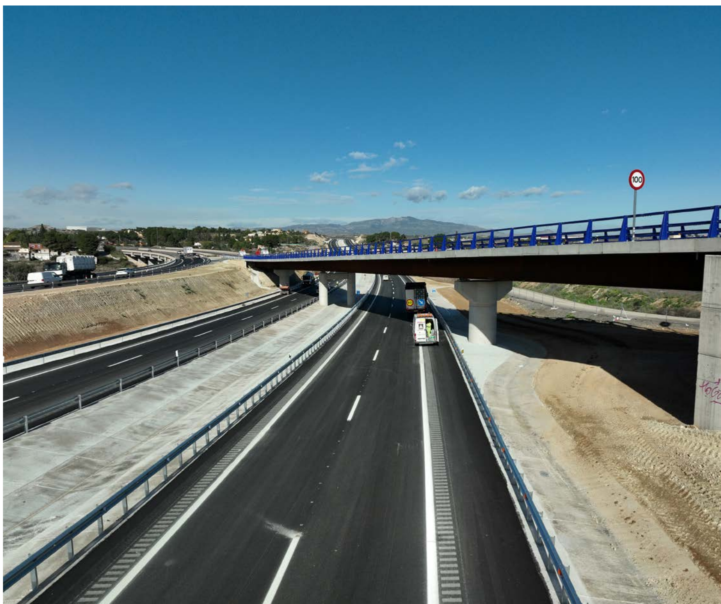
Estructura E-12 de conexión con la autovía RM-15.
