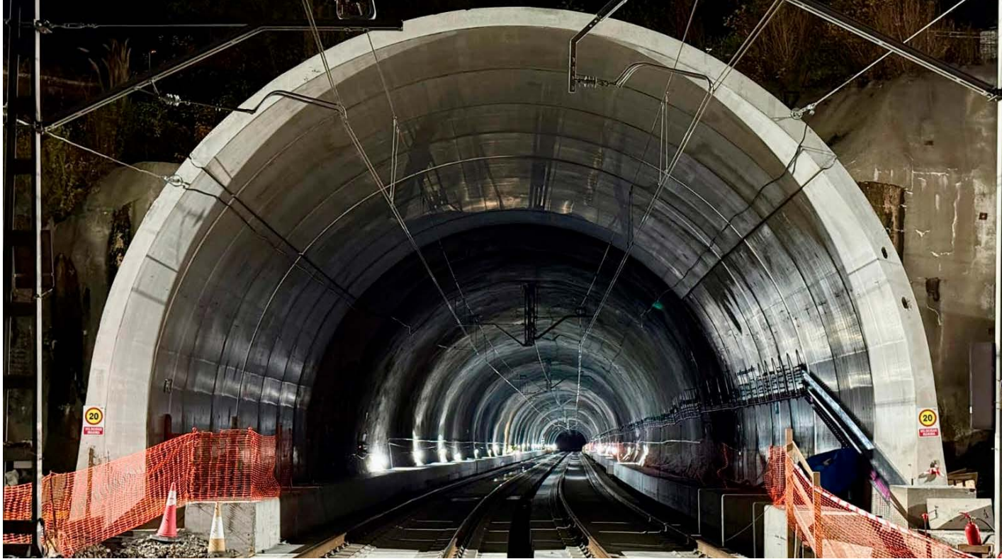
Emboquille del túnel de Gaintxurizketa con la sección ya ampliada.
