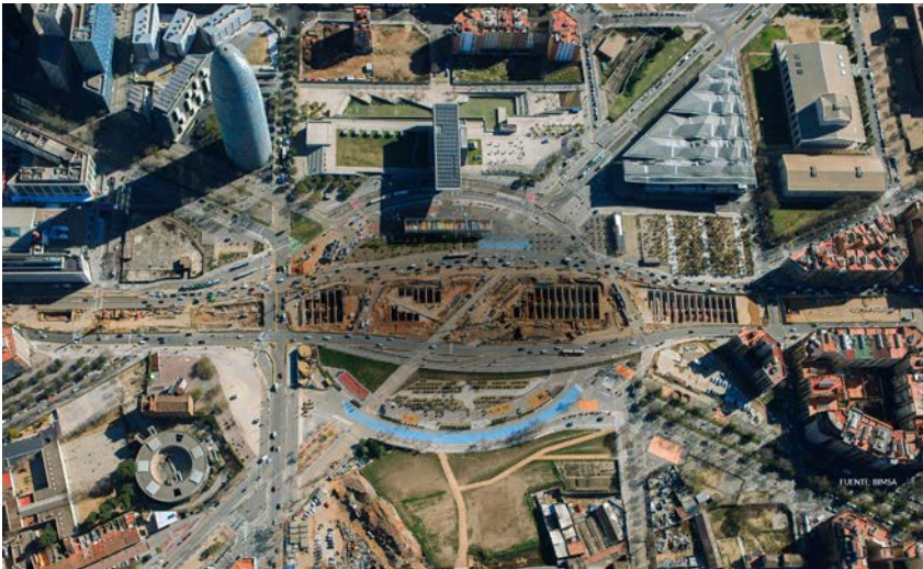
Nuevos túneles viarios en Plaza de las Glòries, Barcelona. Javier Rui-Wamba (PNIC 2016).
