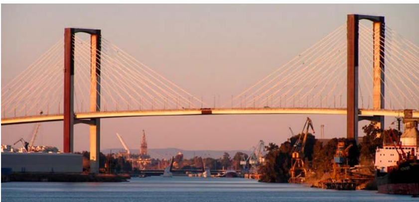
Puente V Centenario sobre el río Guadalquivir, Sevilla. Julio Martínez Calzón (PNIC 2017).
