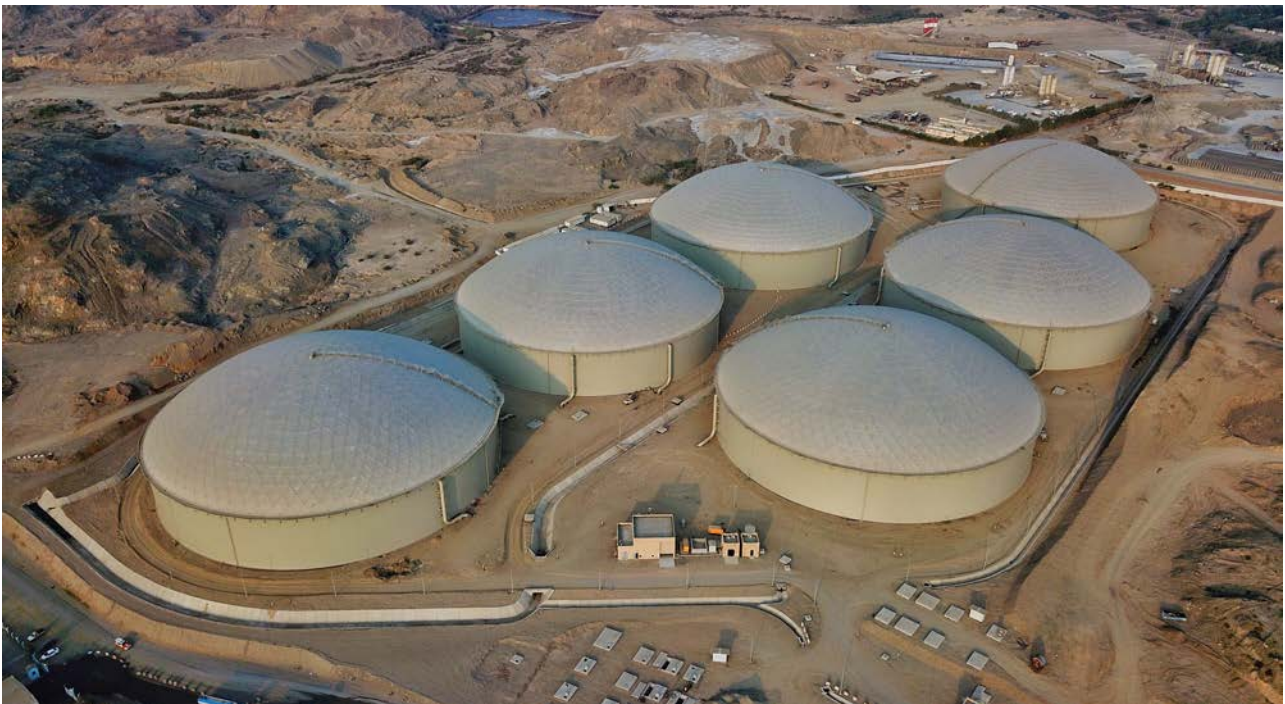
Abastecimiento de Agua en Arabia Saudí, 6 tanques metálicos en Braiman, Jedah. Carmen de Andrés (PNIC 2021).
