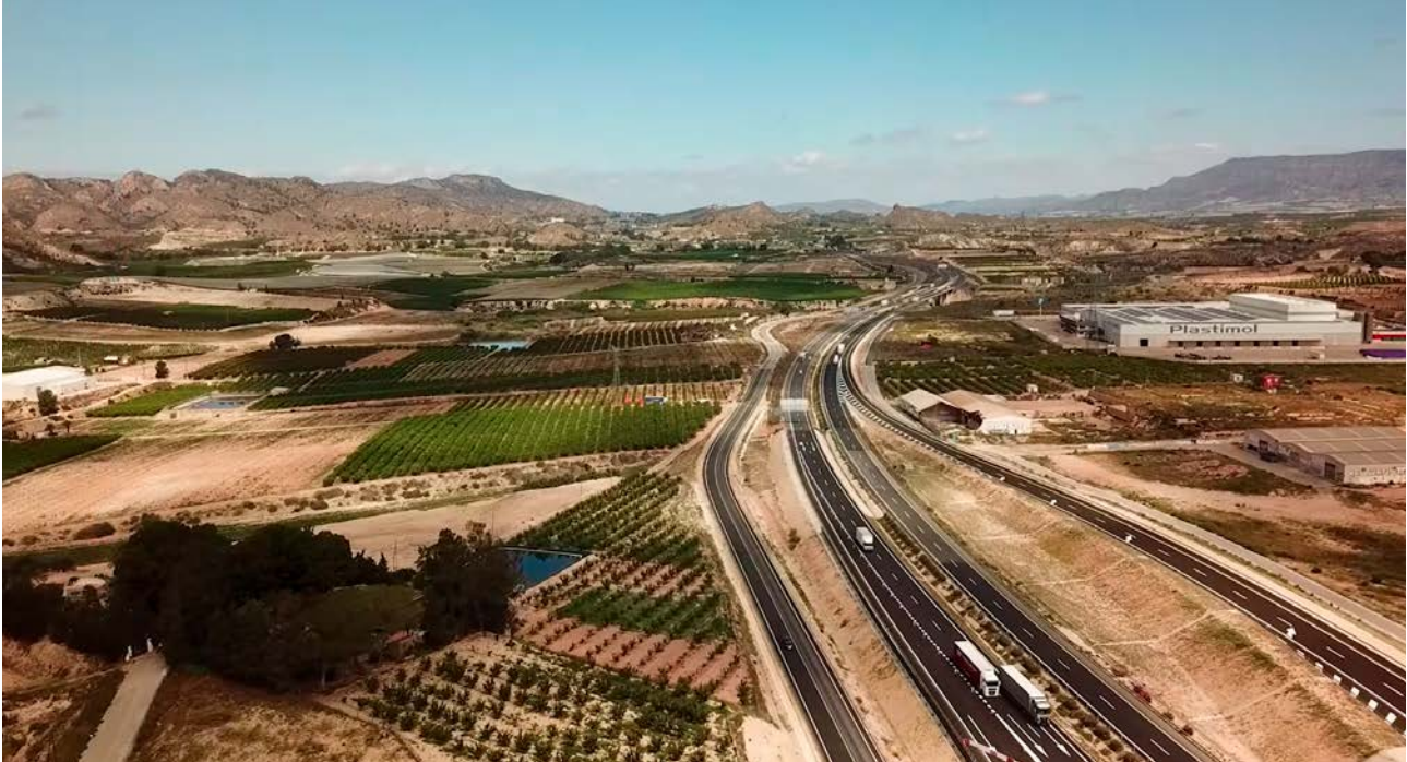
Tronco de la A-30 junto al enlace de Archena, origen del Arco Noroeste.
