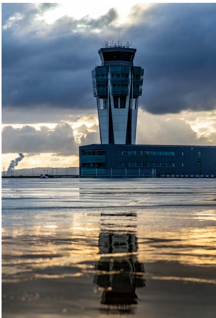
Torre y Centro de Control de Área Terminal de ENAIRE en Santiago.
