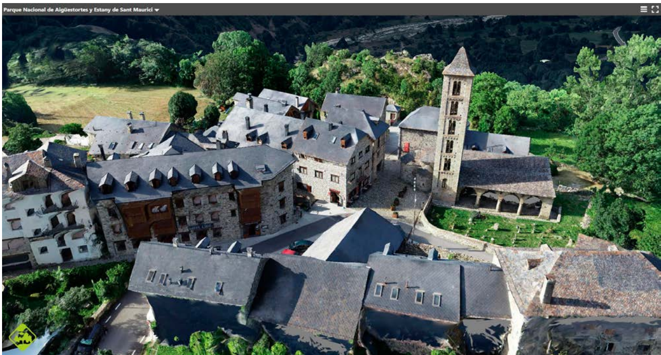
Escena 3D generada a partir de vuelos de dron. Iglesia de Santa Eulalia d'Erill-la-Vall. Parque Nacional de Aigüestortes i Estani Sant Maurici.
