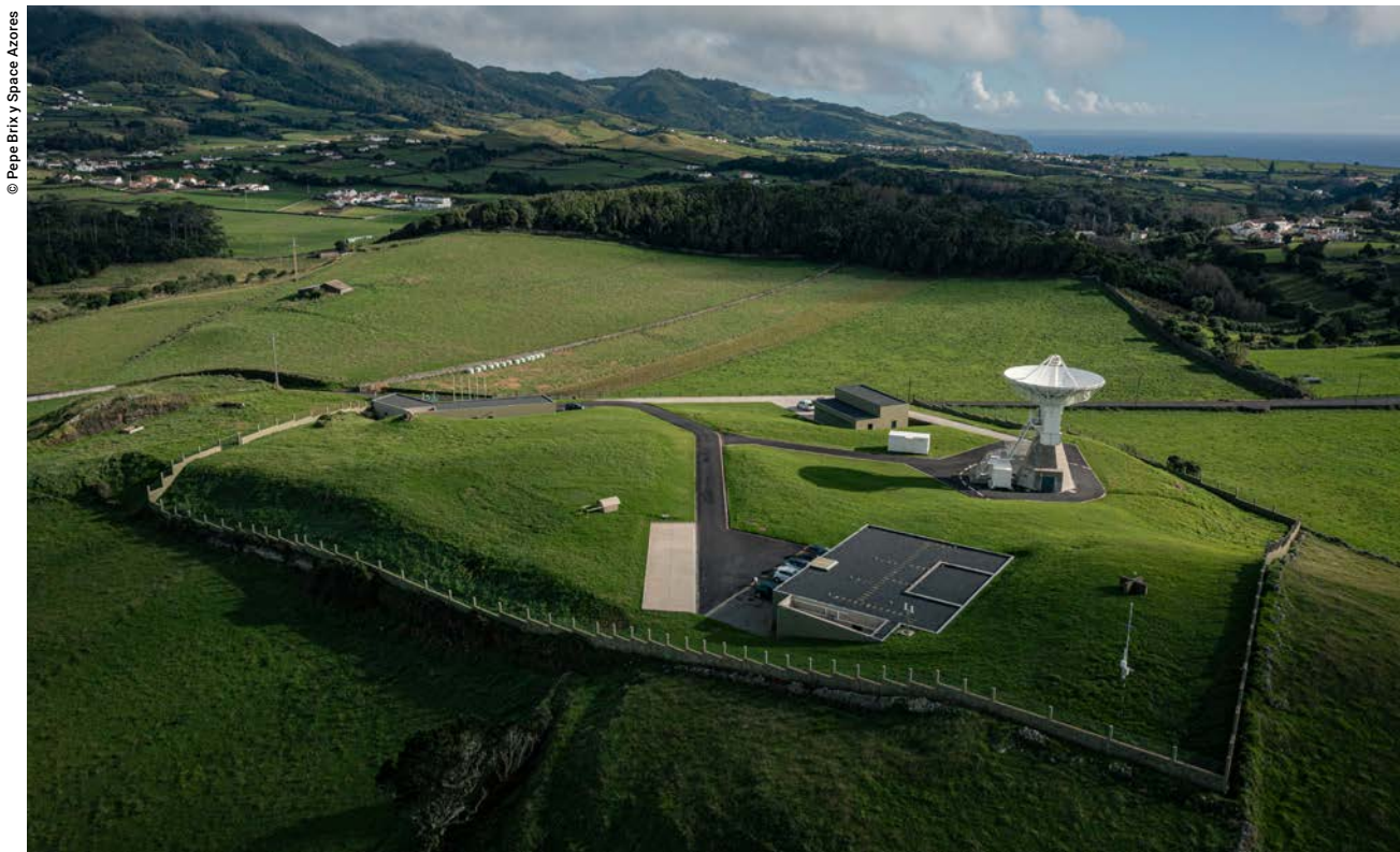
Estación geodésica de Santa María (Azores, Portugal), segunda estación completada dentro del proyecto RAEGE. Gracias a su localización, extiende hacia el oeste la red europea de radiotelescopios geodésicos, mejorando su distribución y alcance, fundamentales para la monitorización del sistema terrestre.
