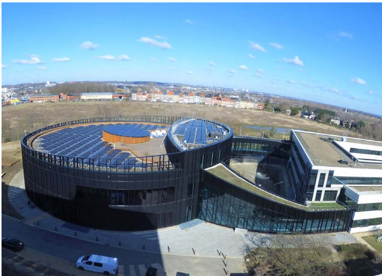
Edificio del Centro de Operaciones del Gestor de Red en Bruselas.
