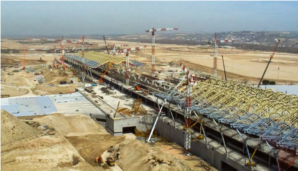
Construcción de la T4 en el Aeropuerto Adolfo Suárez Madrid-Barajas. Fuente: Aena.
