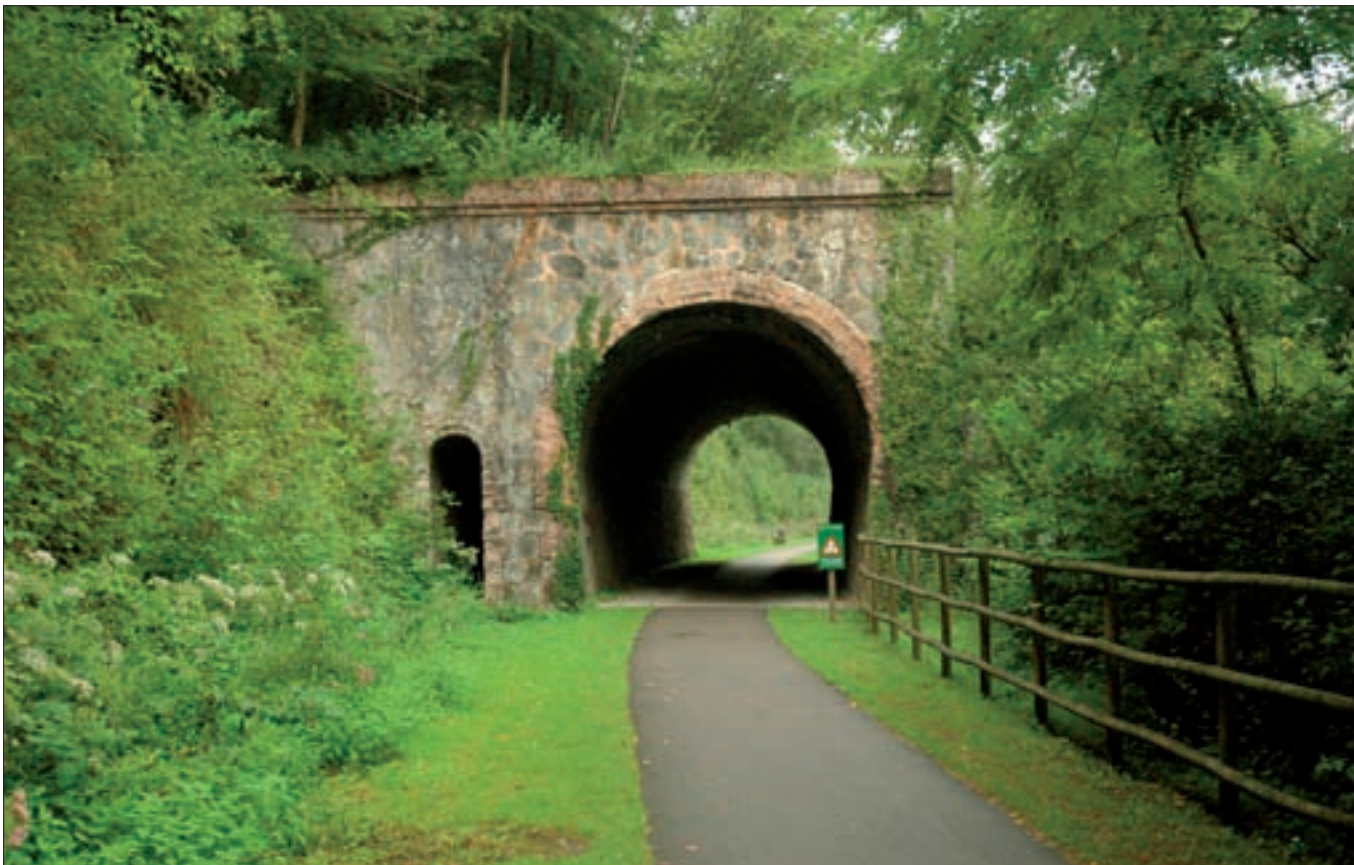
Arriba, único túnel de la vía verde, de 49 metros de longitud. Debajo, la vía verde se ha equipado con barandillas en los lugares con cierto riesgo para los usuarios.
