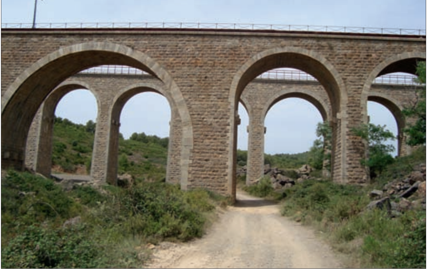
► El barranco de la Fuensanta, en Caudiel (Castellón), es cruzado por dos viaductos, uno en servicio (en primer plano) y otro en el trazado de la vía verde.
