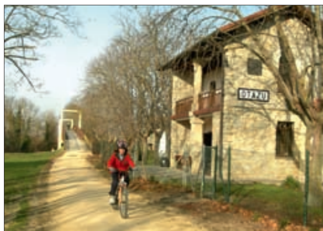
► Antigua estación de Otazu (Araba), actual albergue turístico.
