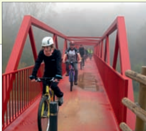
► Pasarela sobre la carretera Vitoria-Estella, en el tramo II de la vía verde.
