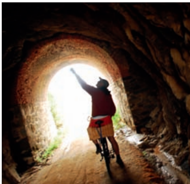
► Túnel roqueño con emboquillado en ladrillo al principio del recorrido.
