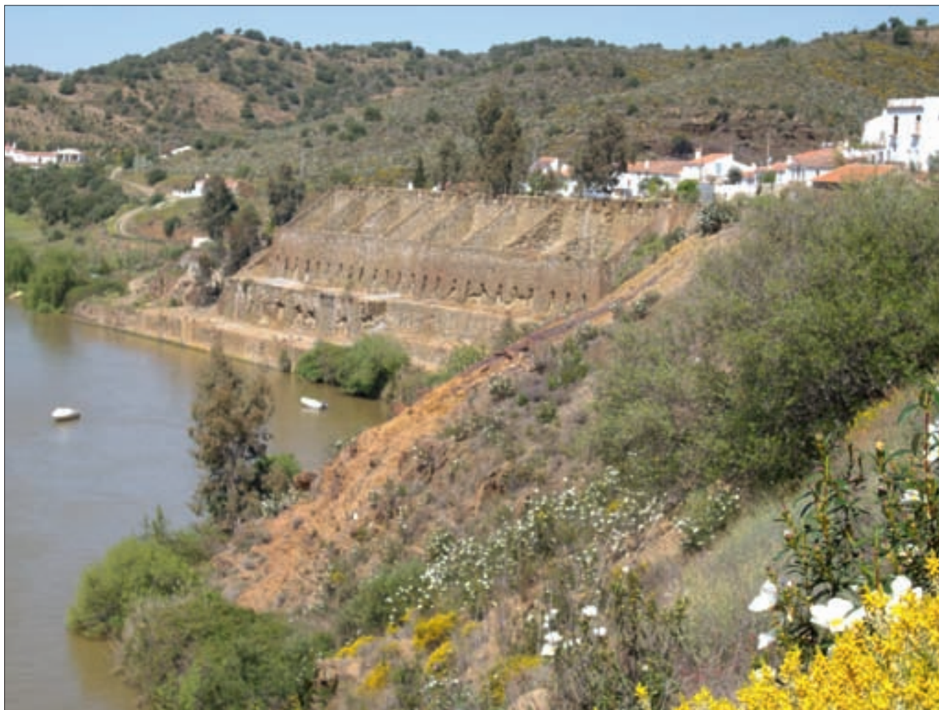
► El cargadero fluvial sobre el río Guadiana, en el puerto de La Laja, se construyó aprovechando la pendiente natural de la ribera.
