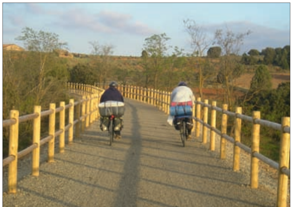
► El firme de la vía verde es de carácter mixto, a base de asfalto y tierra compactada.
