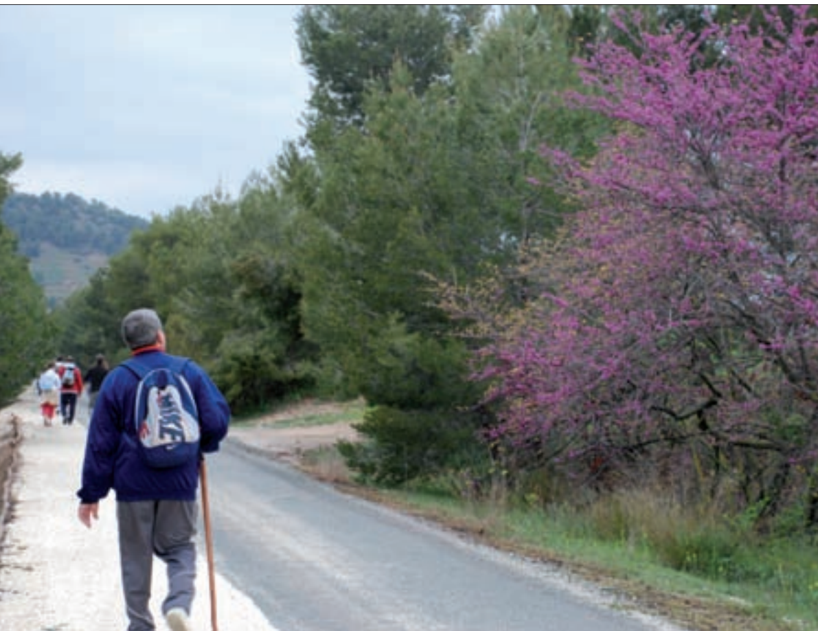
► La vía verde presenta un firme mixto, con asfalto y zahorra compactada. Derecha, uno de los viaductos del trazado.
