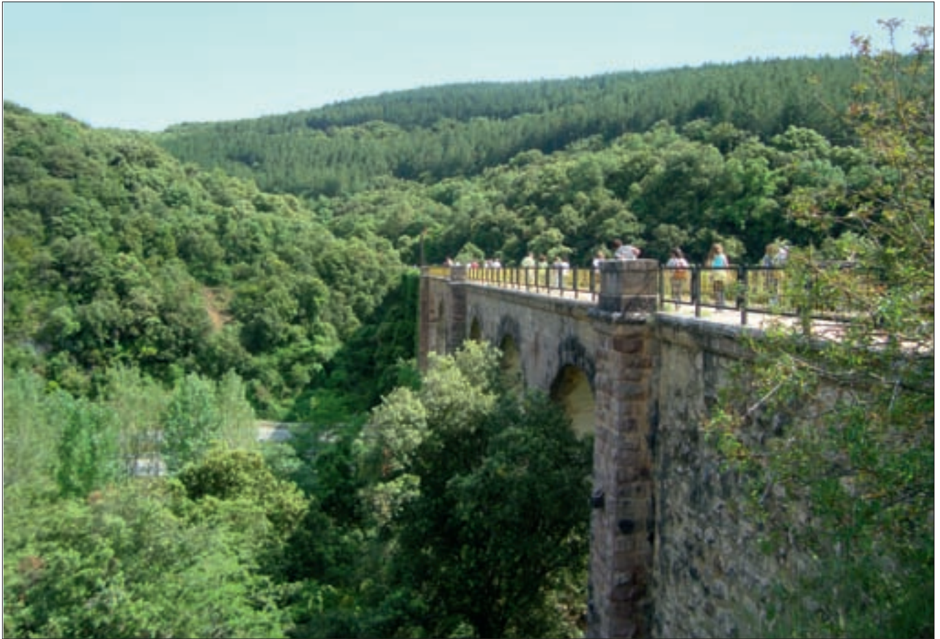
▮ Viaducto sobre el río Ega en el desfiladero de Arquijas (Navarra), estructura de 9 vanos y 30 metros de altura.
