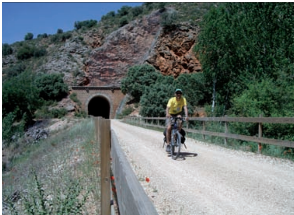
▶ En la parte final, el recorrido se estrecha, obligando a la construcción de ocho túneles.
