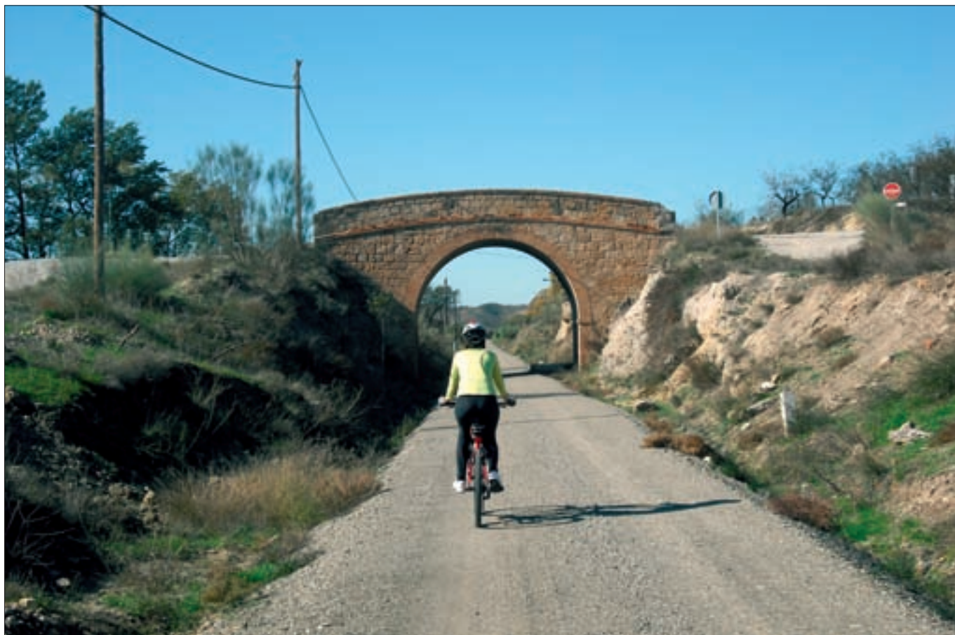
► El trazado de la Vía Verde del Almanzora permite a paseantes y ciclistas admirar algunas estructuras de la vieja línea férrea aún en pie, como este paso superior.
