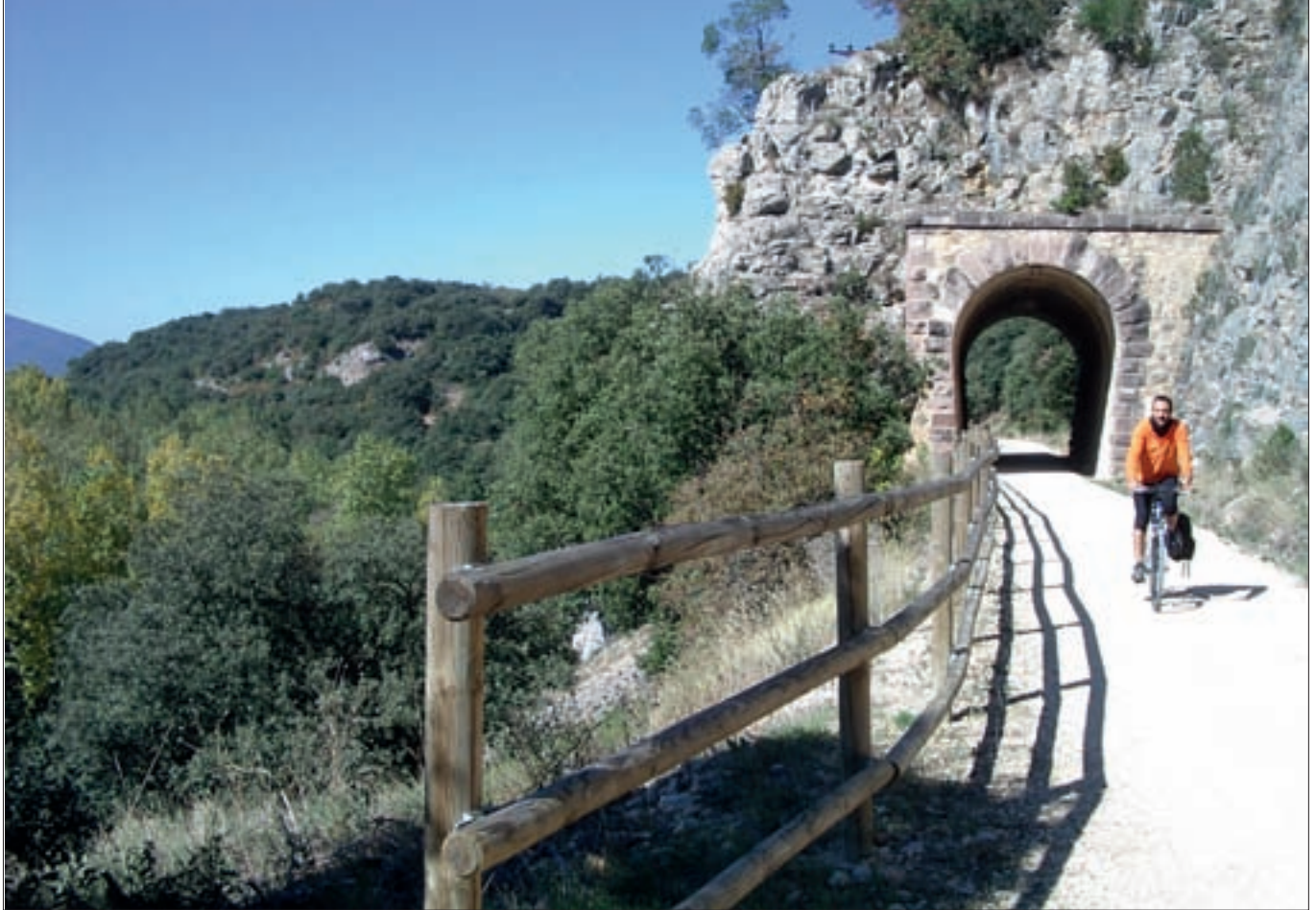
► El firme de la vía verde está compuesto por tierra compactada o asfalto, dependiendo de los tramos.
