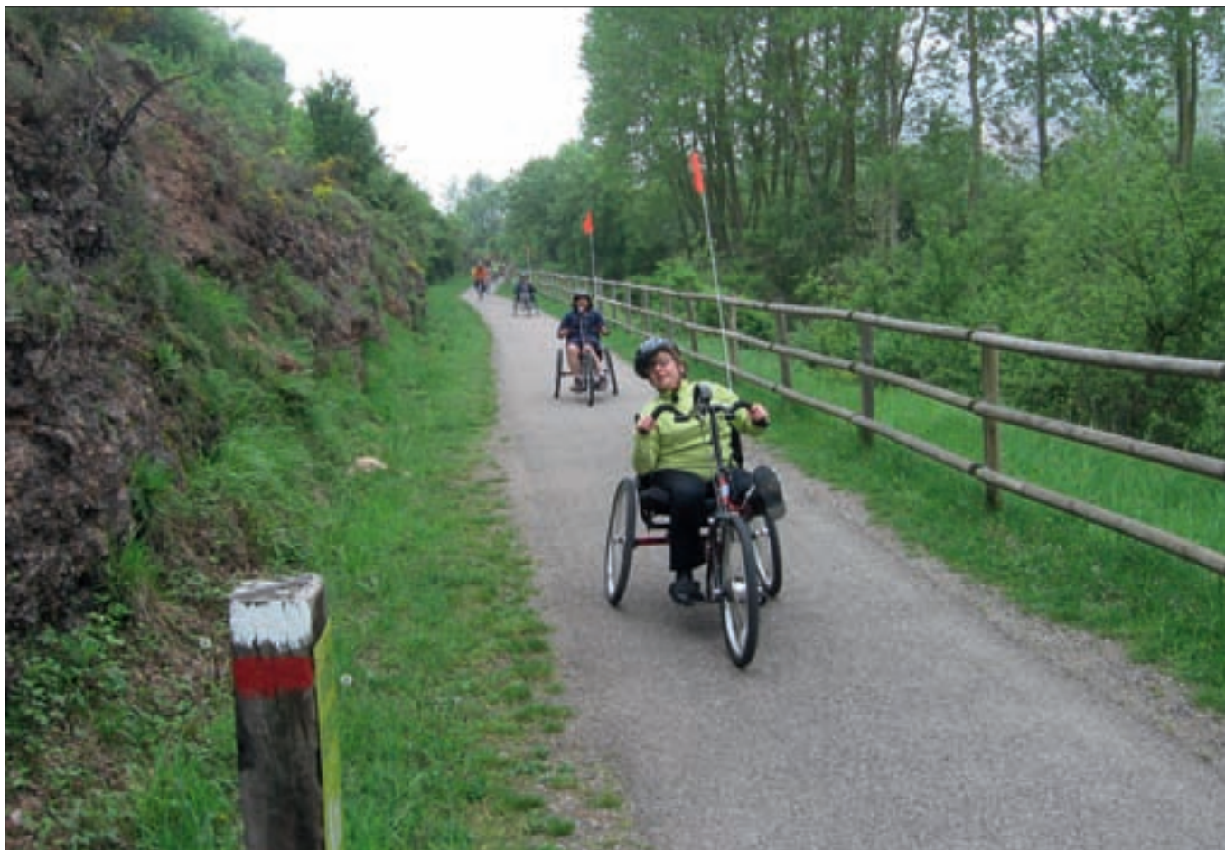
La vía verde se asienta sobre un firme mixto, formado por asfalto y tierra compacta.
