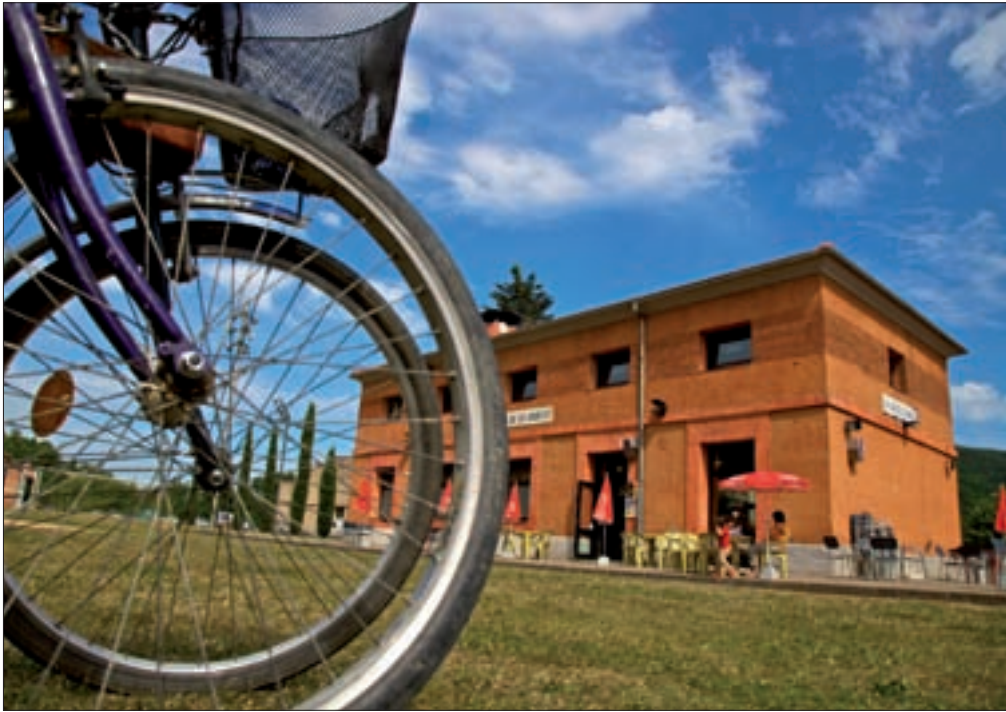
► Antigua estación de Sant Joan de les Abadesses e instalaciones de la vieja línea férrea.
