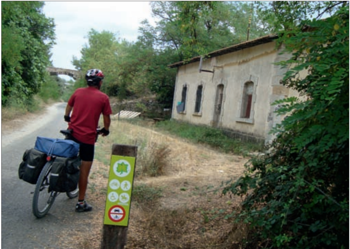
La vía verde discurre junto a antiguas edificaciones que han perdido su funcionalidad con la clausura del trazado ferroviario.
