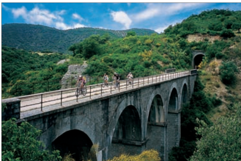
▶ En el recorrido se han construido cuatro viaductos para salvar los ríos Guadalete, Guadalporcún y Guadamanil.
