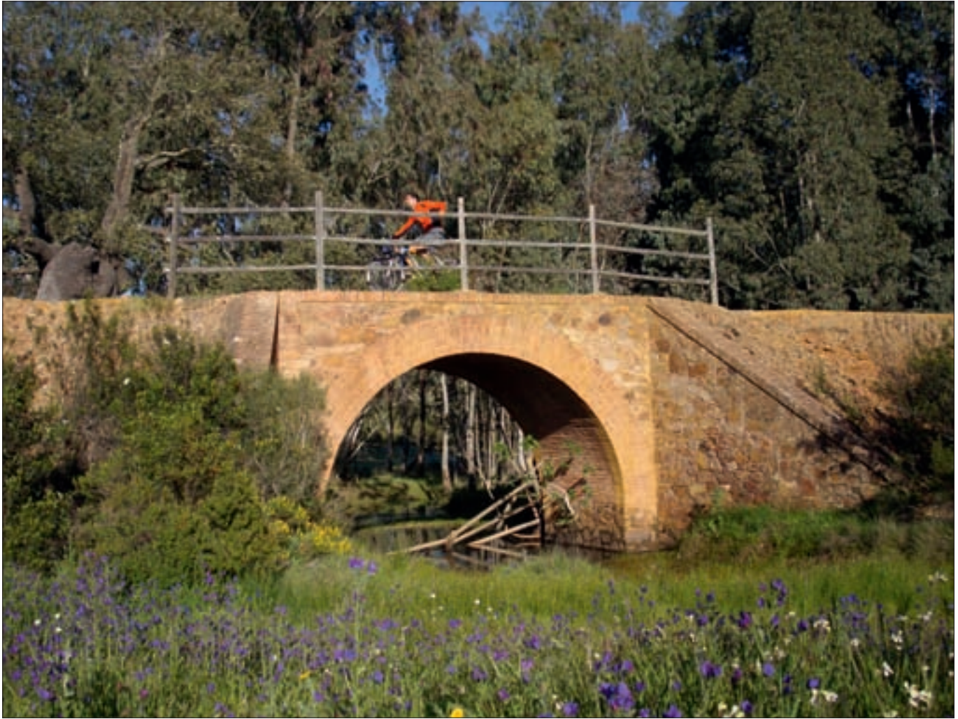
► El trazado ferroviario incluyó la construcción de cinco viaductos, sobre los cuales ahora caminan o pedalean los usuarios de la vía verde.
