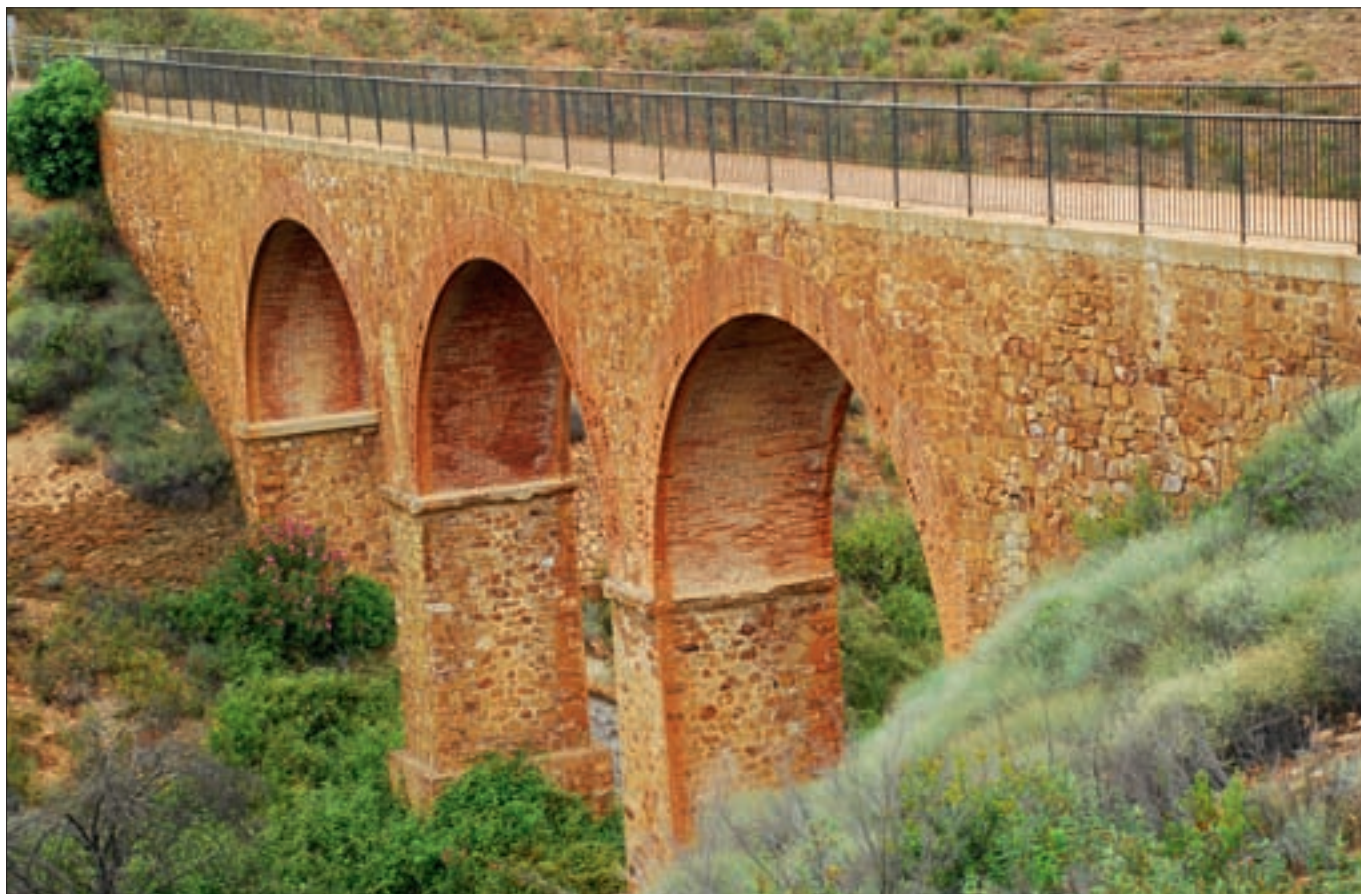
► Puente sobre el barranco del Lobo, de 65 metros de longitud y tres arcos de medio punto. Debajo, vegetación junto a la vía verde.
