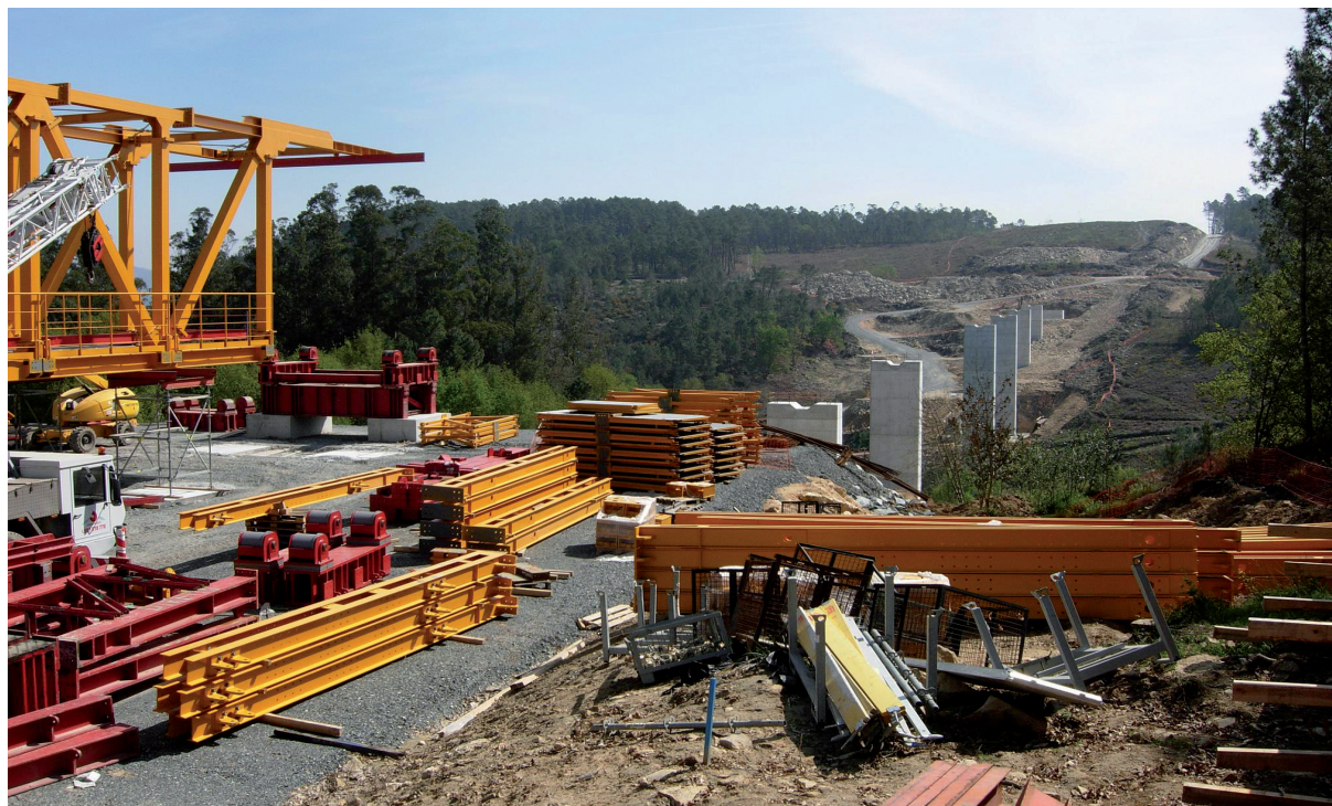
Obras del AVE en Pazos de Bordén (Pontevedra).
