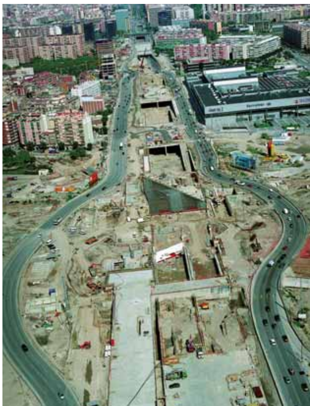
Estado de las obras en verano del 2006 con la nueva estación ya cubierta y las estructuras de la C-31 completas. Para garantizar la gestión eficiente de los más de 100.000 vehículos diarios de circulación fue necesaria una inversión superior a los 7 millones de euros.
