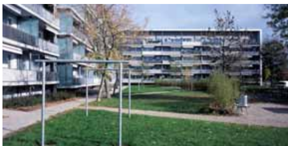
Tratamiento del espacio libre entre los bloques rehabilitados. © Future Documentation.
