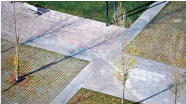
Detalle del pavimento de la losa que cubre la C-31.
