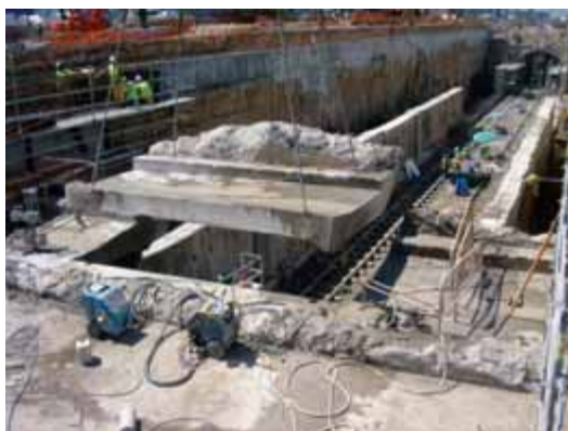
Imagen de la estación sobre L-8 ya existente. Todo el proceso se concentró en las seis semanas de verano.
