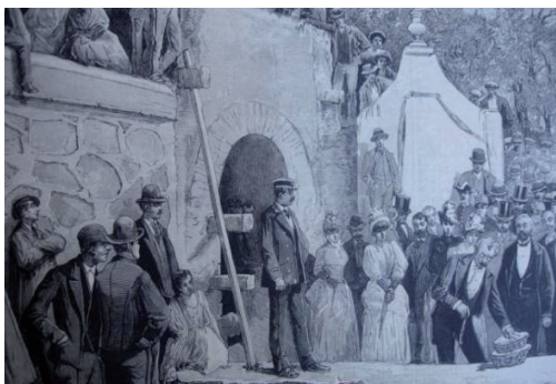
Fig. 2/ Colocación de la primera piedra del manantial de Llantonos para el abastecimiento de agua de Oviedo
