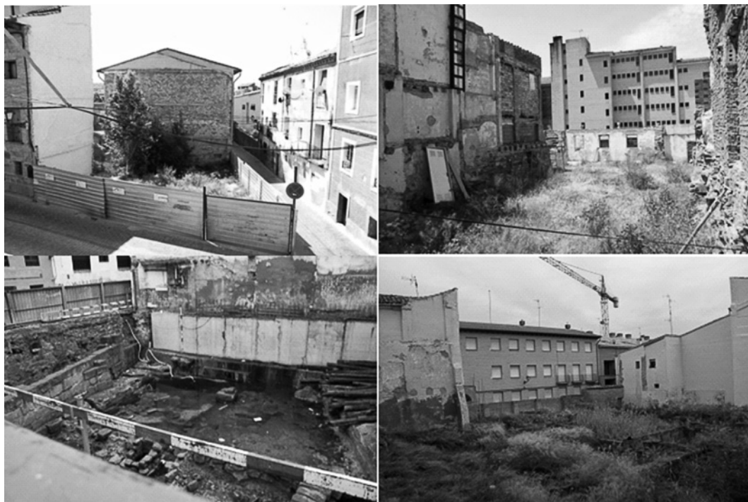
FIG. 8/ Situación en el 2012 de solares vacíos algunos con presencia de restos arqueológicos
