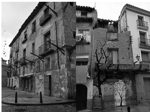
FIG. 6/ Edificios deteriorados en las proximidades de San Pedro 2012
