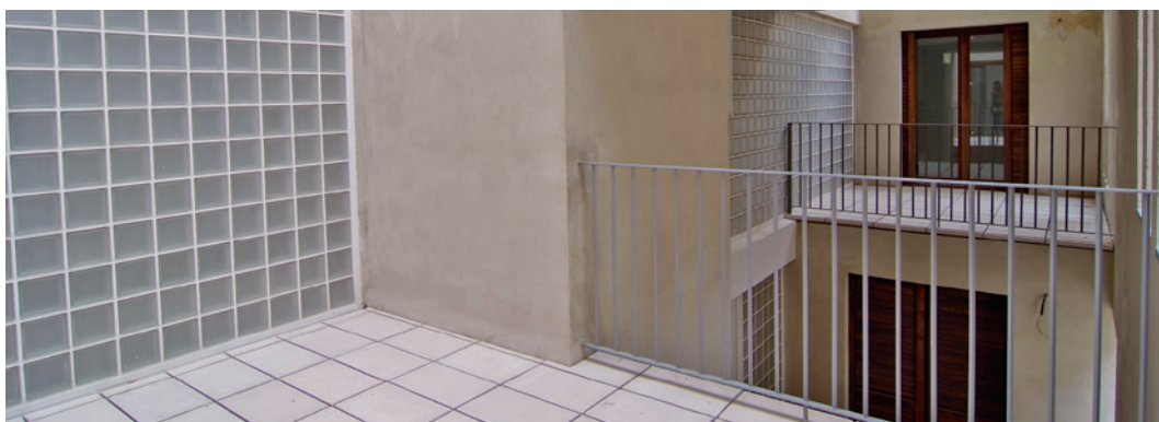
Vistas cruzadas entre las terrazas creadas por los vacíos troquelados en el volumen del edificio B (Tato HERRERO).
