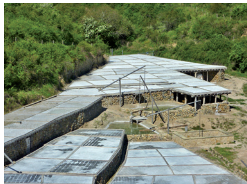
Fig. 3/ Elementos arquitectónicos de las salinas: eras, pozos trabuquetes, mayo 2014
