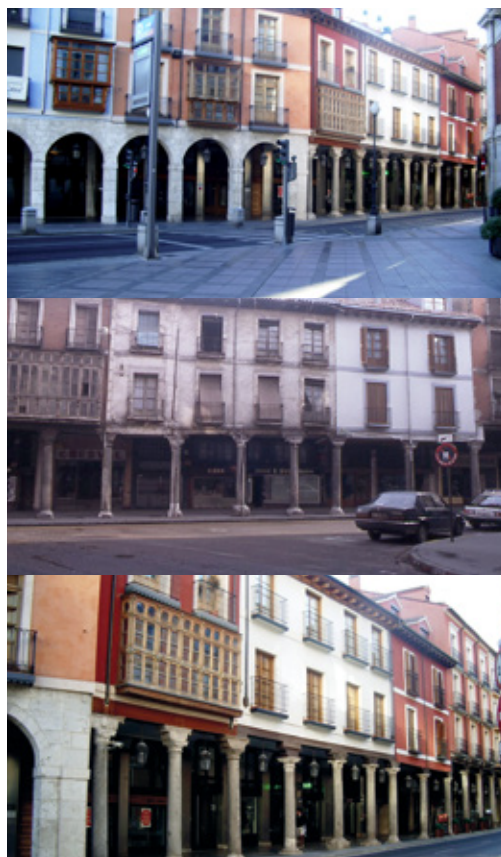
FIG. 5/ Transformaciones en la calle Cebadería.
